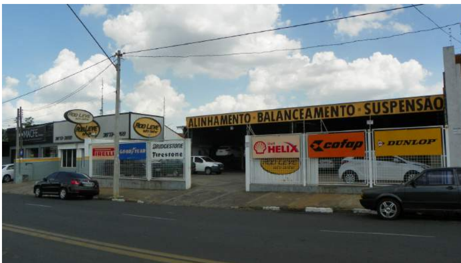
Parte da fachada do imóvel avaliando - oficina (dependência)
