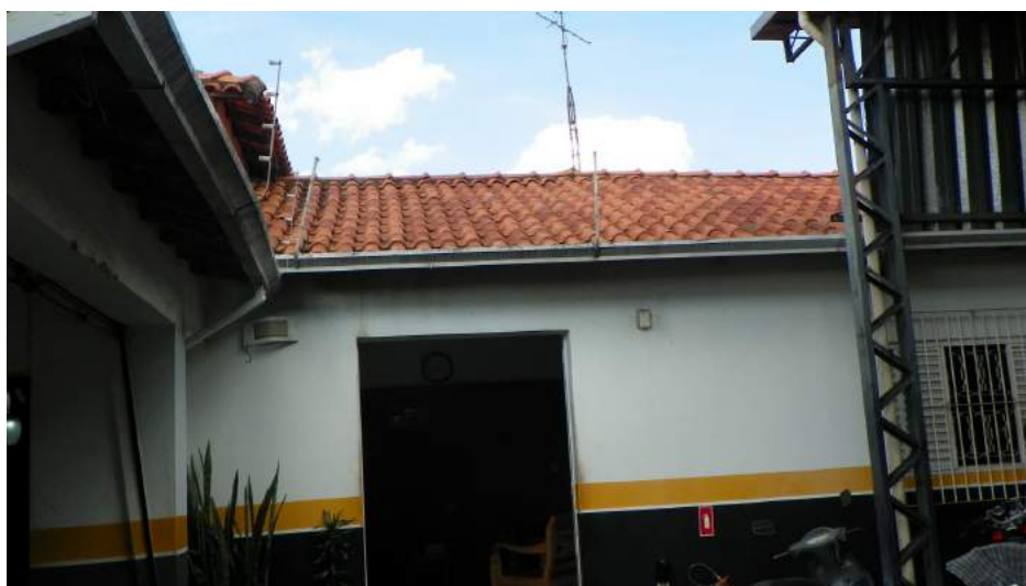
Vista da lateral da antiga residência, transformada em loja
