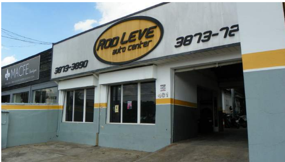
Parte da fachada do imóvel avaliando - loja
