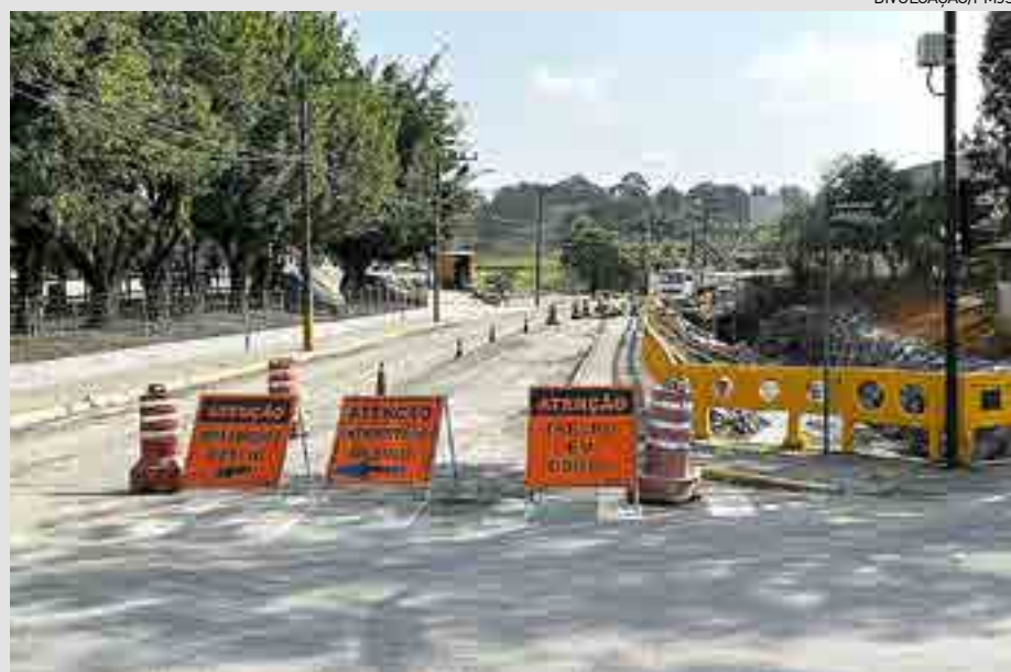
A atual ponte será demolida e no local serão implantadas galerias que deve evitar alagamentos
