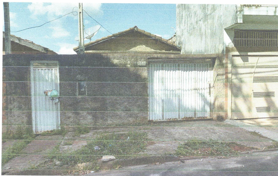
Vista do Imóvel Avaliando
