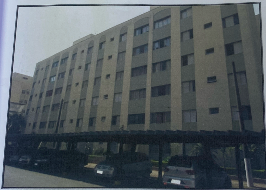
Vista do EDIFÍCIO JAGUARIBE, integrante do CONDOMÍNIO FLUVIAL situado na Avenida São José nº 460 - Centro - Diadema - SP, em segundo plano as garagens.
