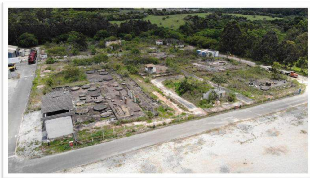
Figura 1 - benfeitorias em ruínas e sem valor de mercado
