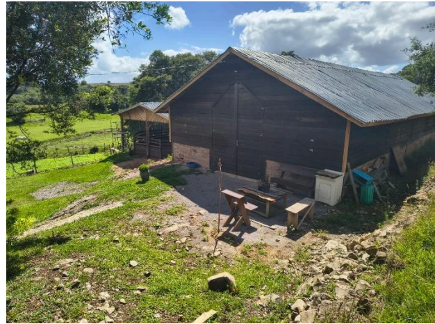
Benfeitorias edificadas pela arrendatária, consistentes em um quiosque e um galpão fechado, com baias destinadas a equinos.
