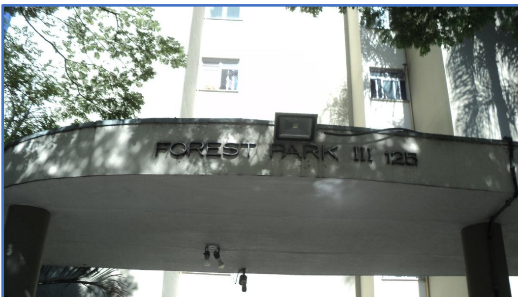
Fotos: identificação do edifício do imóvel avaliando.
