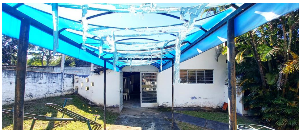
Foto 37: Vista da fachada do Salão de Festas
