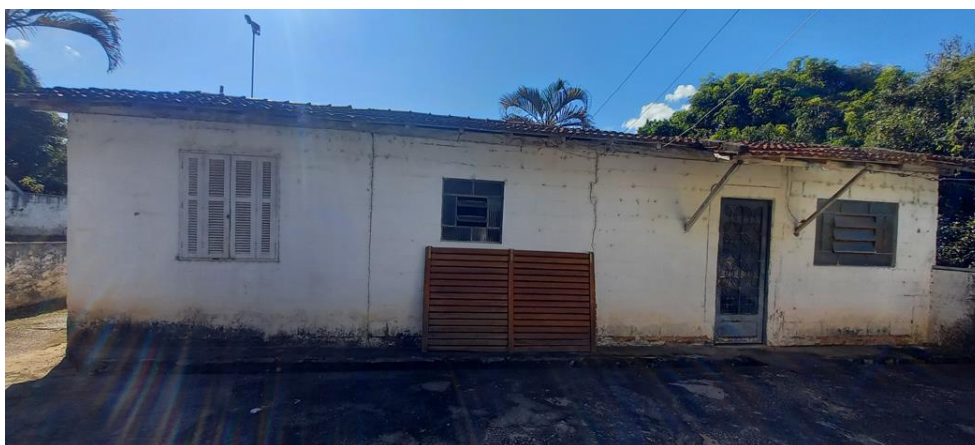
Foto 32: Vista da fachada da Casa do Caseiro
