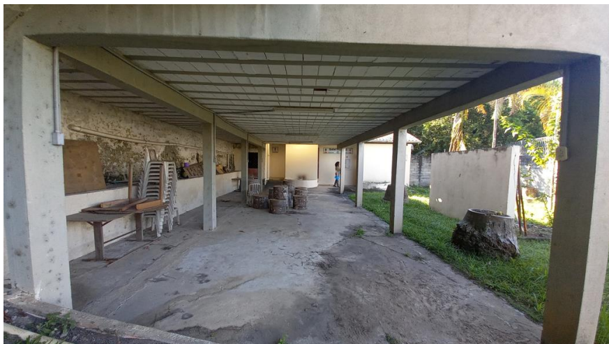
Foto 58: Vista geral do piso inferior ao Rancho sem Churrasqueira
