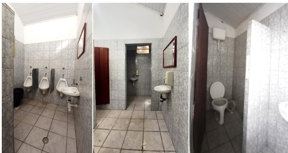
Fotos 42, 43 e 44: Vistas dos banheiros do Salão de Festas.
