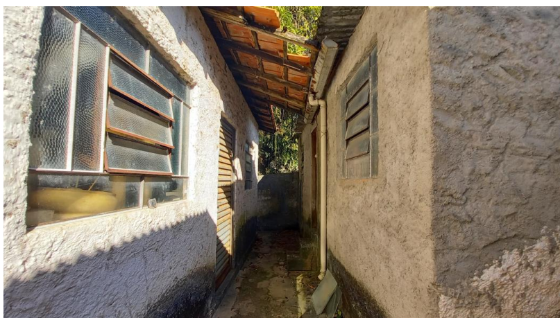
Foto 27: Vista da fachada dos Depósitos do imóvel
