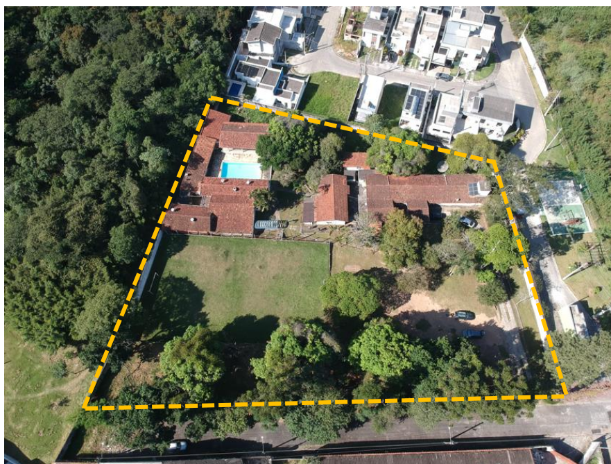
Foto 01: Vista aérea do imóvel
