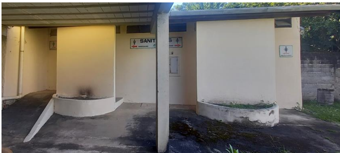
Foto 52: Vista da fachada dos Vestiários
