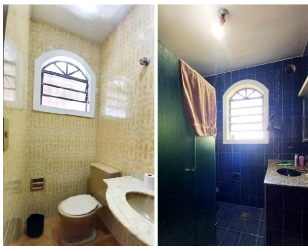
Fotos 16 e 17: Vistas dos banheiros da Casa Principal.
