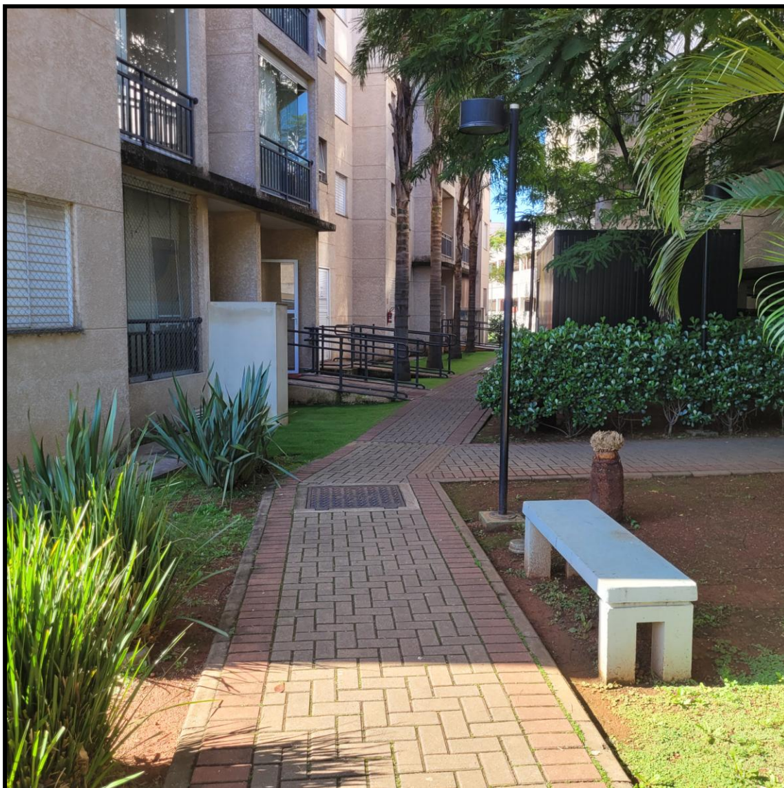
FOTO 16: No piso térreo externo do condomínio, no corredor de acesso ao Bloco que abriga a unidade avalianda.
