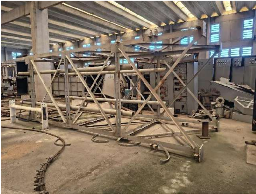
106) Estrutura de ferro tipo torre
