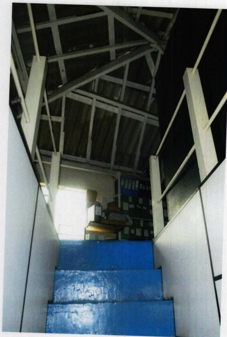
Foto nº 20: Aspecto do depósito existente sobre a sala de reunião retrorreferida
