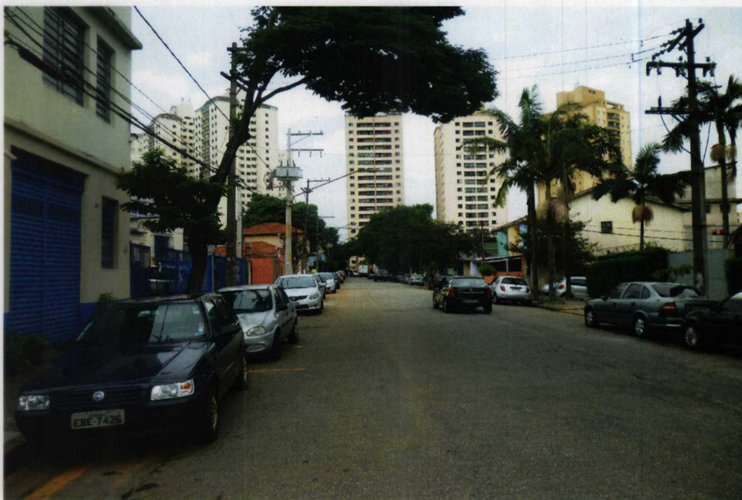
Foto nº 1: Aspecto da Rua Liège, altura do número 156, podendo ser observado o imóvel objeto do laudo à esquerda, em primeiro plano
