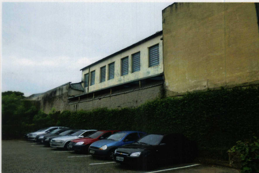
Fotos n os 6 e 7: Vistas laterais da construção "B"
