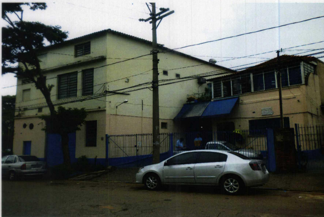
Fotos n os 2 e 3: Vistas da fachada do imóvel
