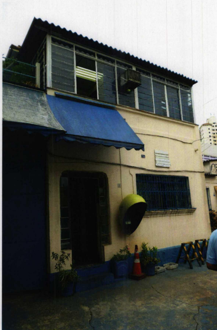
Foto nº 4: Vista da fachada da edificação nº 156 (construção "A")
