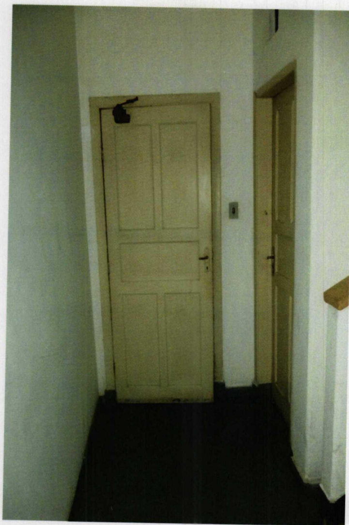
Foto nº 11: Outro ângulo do pavimento térreo da construção "A"
