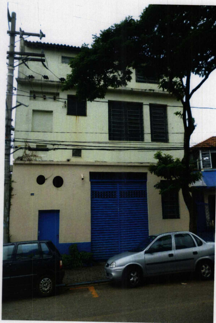
Foto nº 5: Aspecto da fachada da edificação nº 158 (construção "B")
