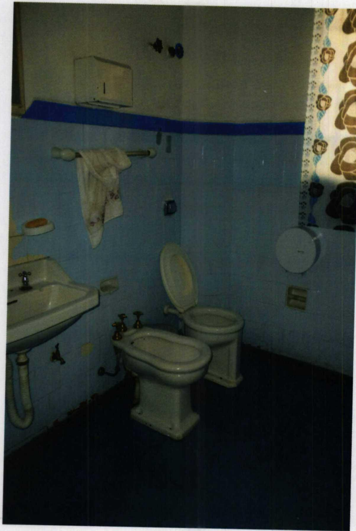
Foto nº 15: Aspecto do banheiro da referida edificação
