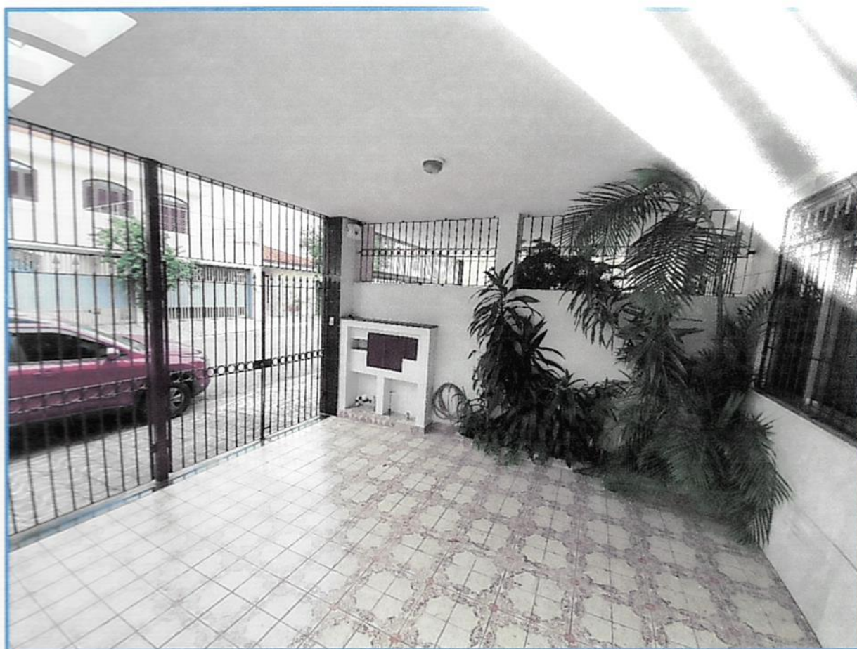
Foto 5 – Vista geral da garagem do imóvel avaliando, observando-se seu padrão construtivo e estado de conservação.
