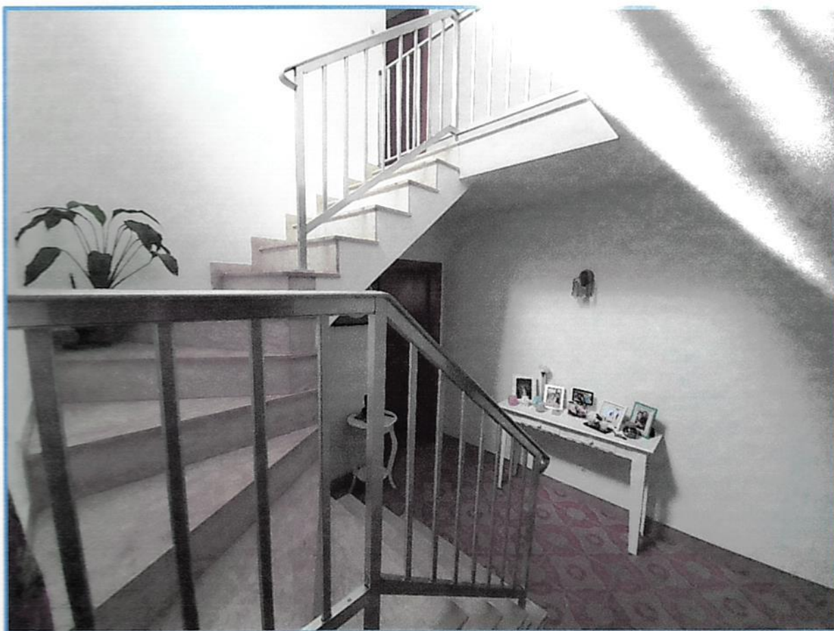
Foto 7 – Vista geral da escada que dá acesso ao pavimento superior do imóvel avaliando.
