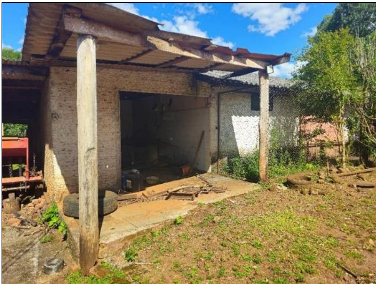
Imagem 2 - Galpão para armazenamento de insumos:
