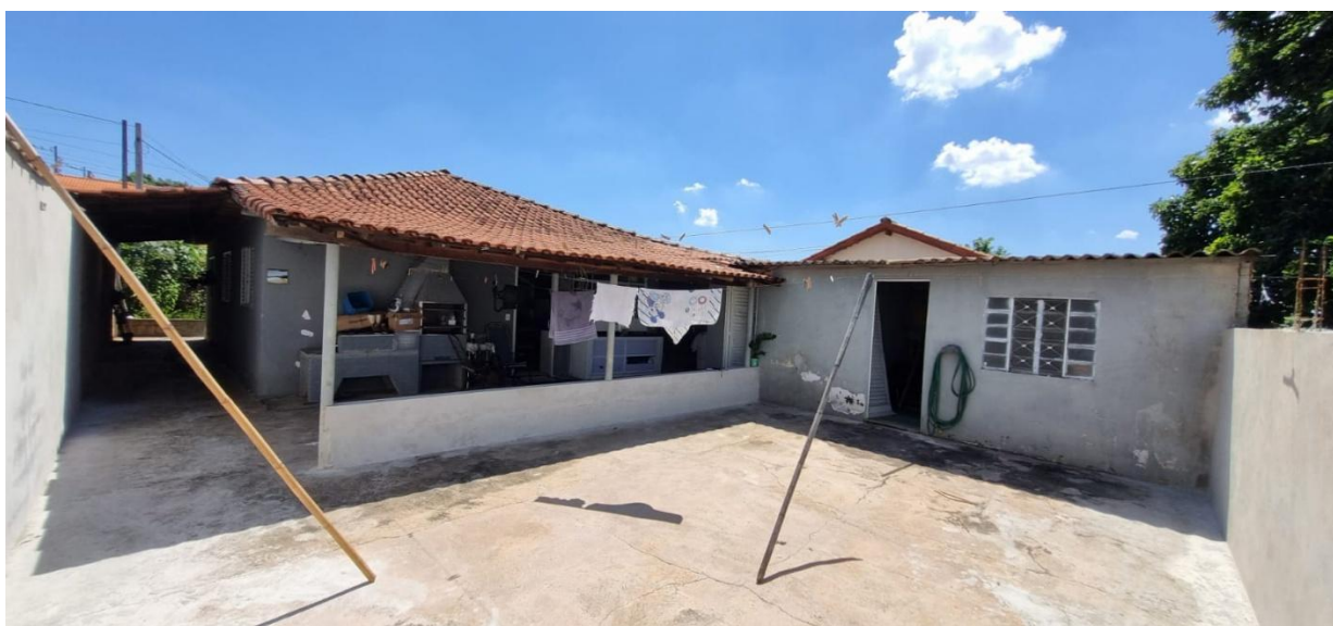
Foto11: Vista para área e a direita depósito, localizado ao fundo do Imóvel
