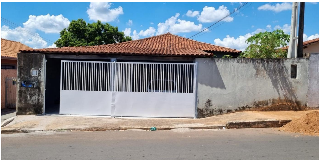
Imagem 1: Fachada do imóvel avaliando
