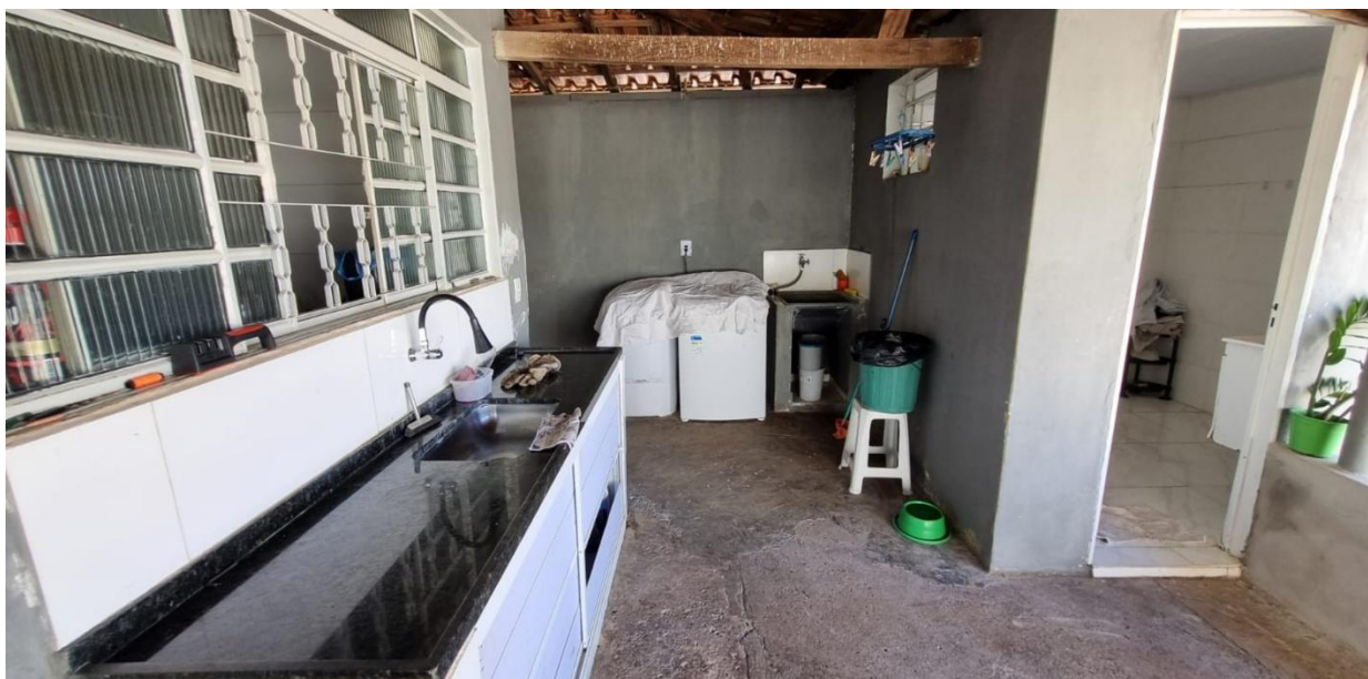
Foto 8: Lavanderia e a direita porta de entrada do banheiro localizado ao fundo do Imóvel
