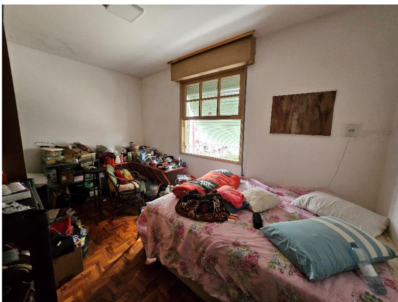
Imagem 6 - Vista do dormitório II da unidade privativa 32, imóvel avaliando, apresentando as seguintes características construtivas: piso em tacos de madeira, paredes e teto em pintura látex PVA sobre massa corrida; esquadrias da porta e janela em madeira.
