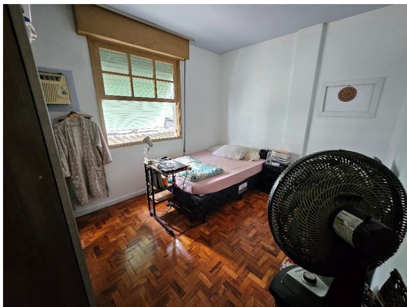
Imagem 4 - Vista do dormitório I da unidade privativa 32, imóvel avaliando, apresentando as seguintes características construtivas: piso em tacos de madeira, paredes e teto em pintura látex PVA sobre massa corrida; esquadrias da porta e janela em madeira.
