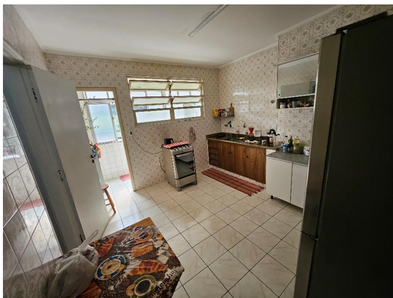
Imagem 10 - Vista da cozinha da unidade privativa 32, imóvel avaliando, apresentando as seguintes características construtivas: piso e paredes em revestimento cerâmico e teto em pintura látex sobre massa corrida com molduras em gesso; esquadrias das portas e janela em madeira.
