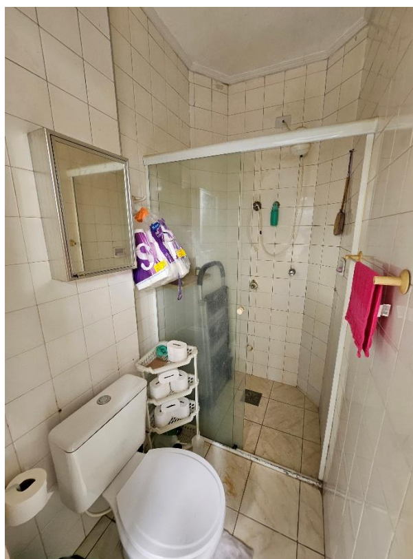
Imagem 17 - Vista do "W.C. de empregada" da unidade privativa 32, imóvel avaliando, apresentando as seguintes características construtivas: piso e paredes em revestimento cerâmico e teto em pintura látex sobre massa corrida com molduras em gesso; esquadrias da porta em madeira.
