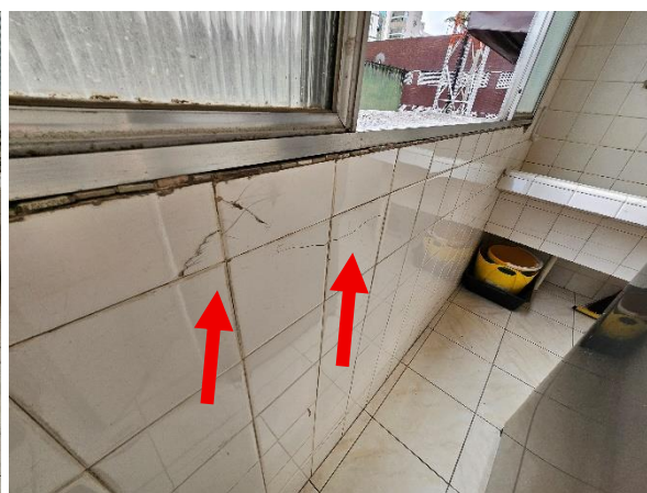
Imagens 15 e 16 - Detalhe aproximado para trincas e danos em revestimentos cerâmicos da parede da área de serviço.
