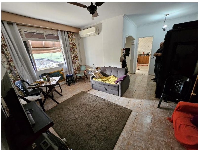
Imagem 8 - Vista da sala da unidade privativa 32, imóvel avaliando, apresentando as seguintes características construtivas: piso em revestimento cerâmico, paredes e teto em pintura látex PVA sobre massa corrida com molduras em gesso; esquadrias da porta em madeira e da janela em alumínio.
