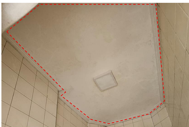
Imagem 18 – Detalhe aproximado para manchas de umidade no teto do "W.C. de empregada".
