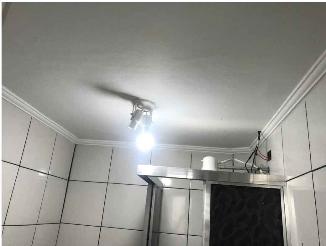
Fotos 22 e 23 - Vista do banheiro; azulejo até o teto, gesso e box de alumínio
