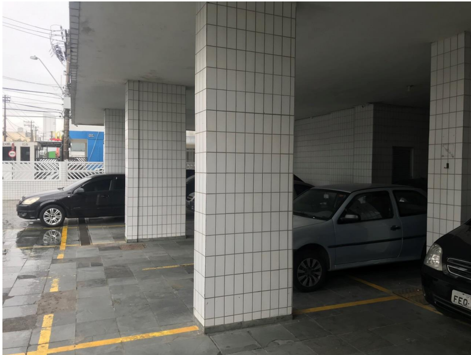
Foto 8 - Parte das vagas de garagem no térreo, lado esquerdo de quem da rua olha
