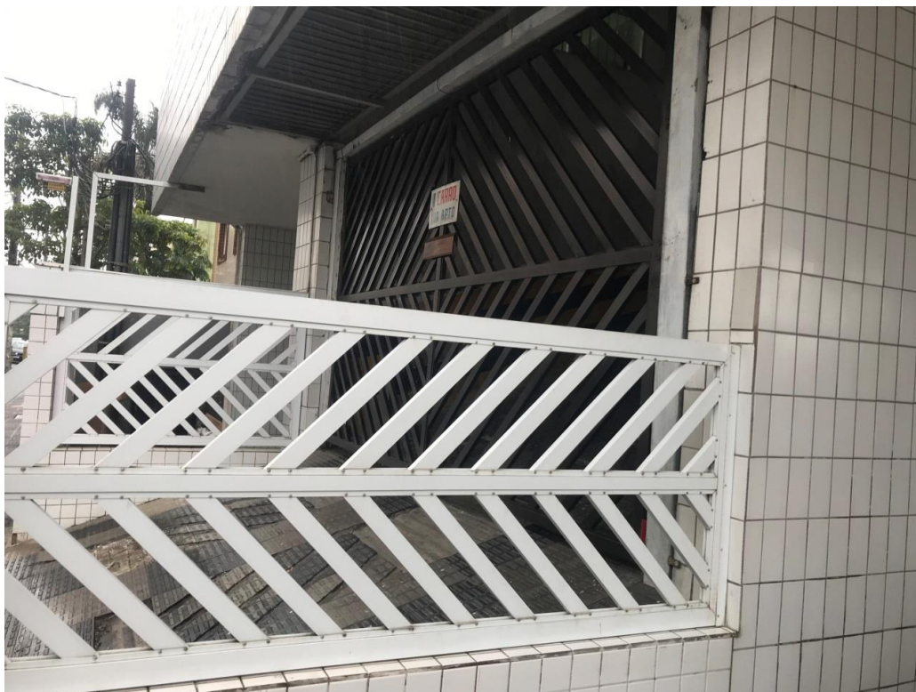
Foto 9 - Acesso as vagas de garagem no mezanino pela rua lateral
