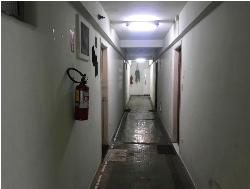
Foto 14 - Corredor de acesso no 8º andar
