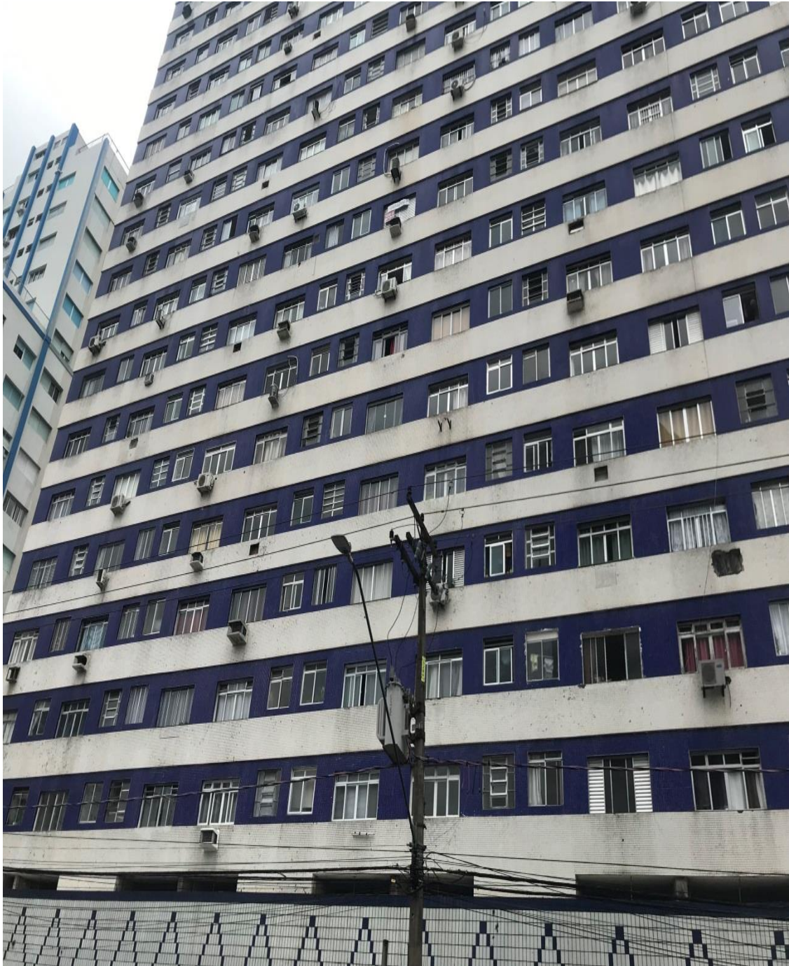
Foto 1 - Fachada do Edifício PRESIDENTE, onde se localiza a unidade avalianda
