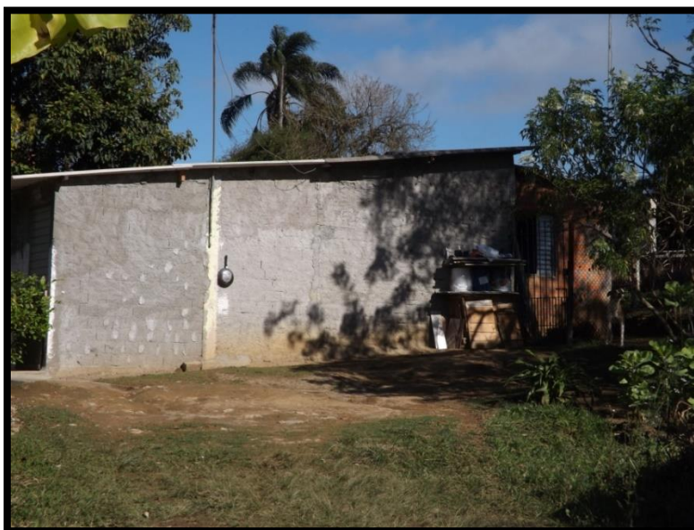
FOTO 08: Mostra uma edificação construída sobre o imóvel avaliando que se encontra ocupada pela Sra. Jovelina Rosa da Silva.
