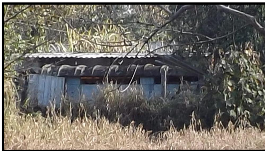
FOTO 09: Mostra uma terceira edificação que é ocupada pelo morador que apenas se identificou como Alfredo. Sendo que durante a vistoria este morador não teve a compreensão do trabalho que estava sendo feito por este perito e não permitiu o acesso ao interior do seu imóvel. Por já constar no cadastro do imóvel, a área e o padrão construtivo das benfeitorias, este perito deu continuidade aos trabalhos.
