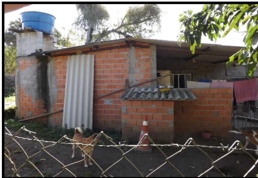
FOTO 08: Mostra outra edificação construída sobre o imóvel avaliando e que se encontra ocupada por Alexandre Silva da Costa e Paula Lourenço Azevedo.
