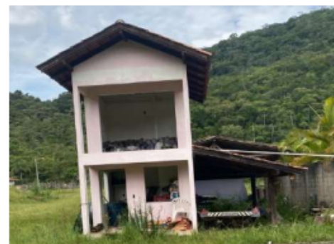
Edificação 03 – Casa de alvenaria
