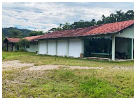
Edificação 01 – Salão de festas (fundos)
