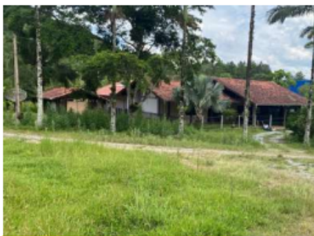
Edificação 02 – Casa de alvenaria
