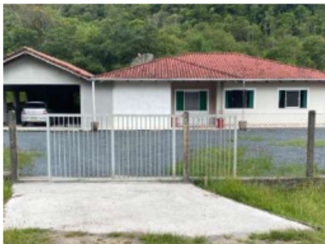
Edificação 05 – Casa de alvenaria
