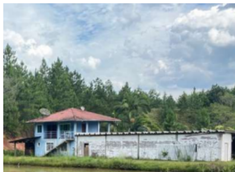
Edificação 04 – Casa de alvenaria
