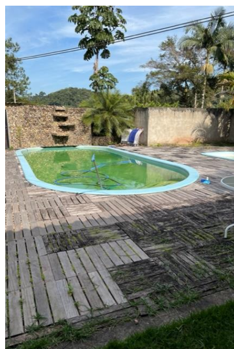
(detalhe do piso de madeira da piscina)
