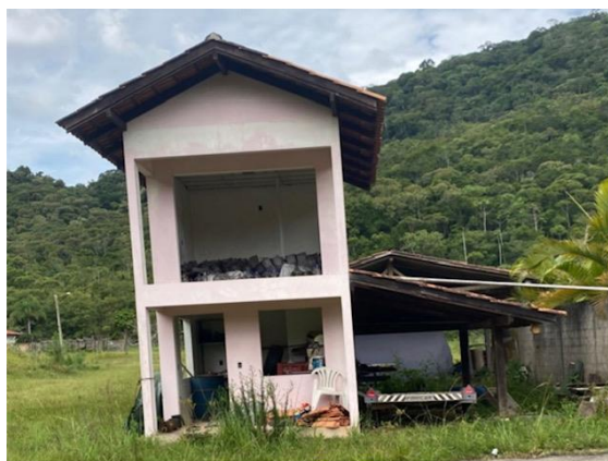
(vista da edificação inacabada)
