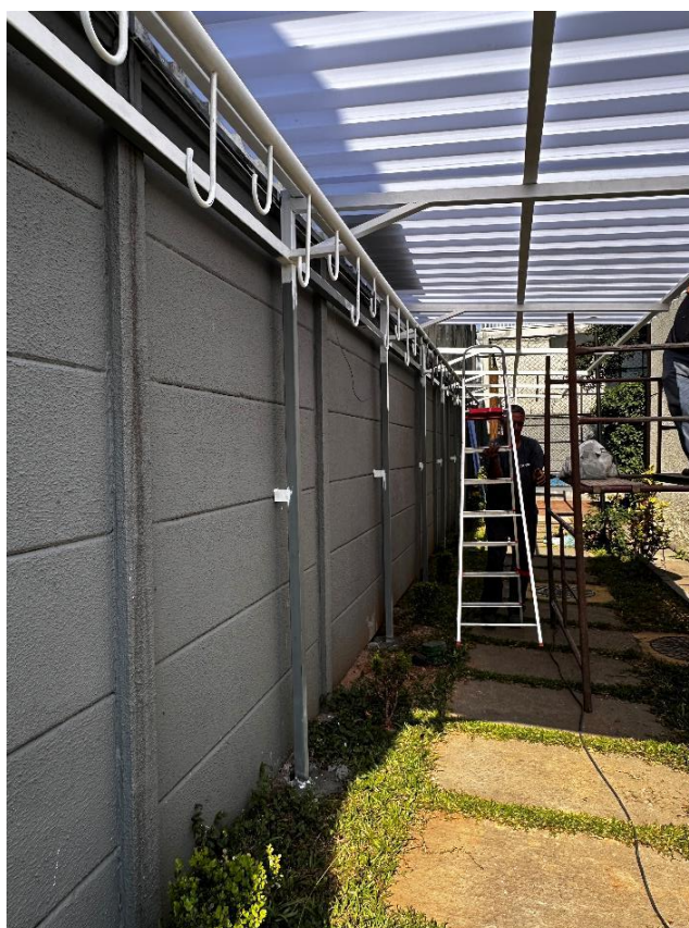
Foto 33: Bicicletário em construção
