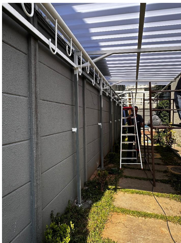
Foto 33: Bicicletário em construção
