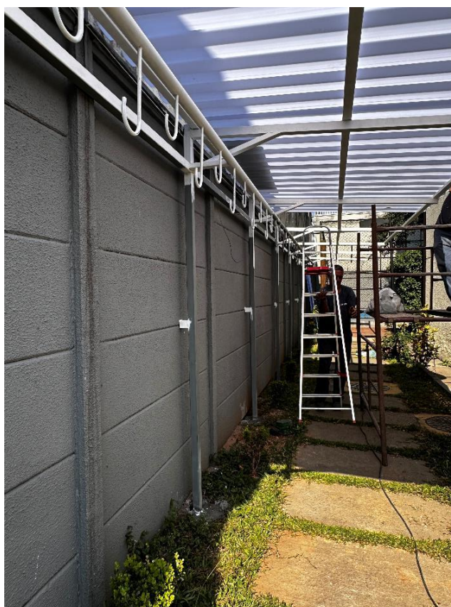
Foto 33: Bicicletário em construção
