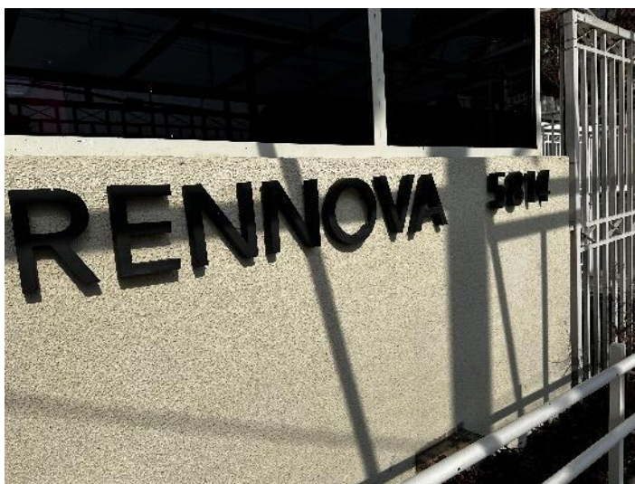
Foto 1: Vista geral – Identificação do condomínio
