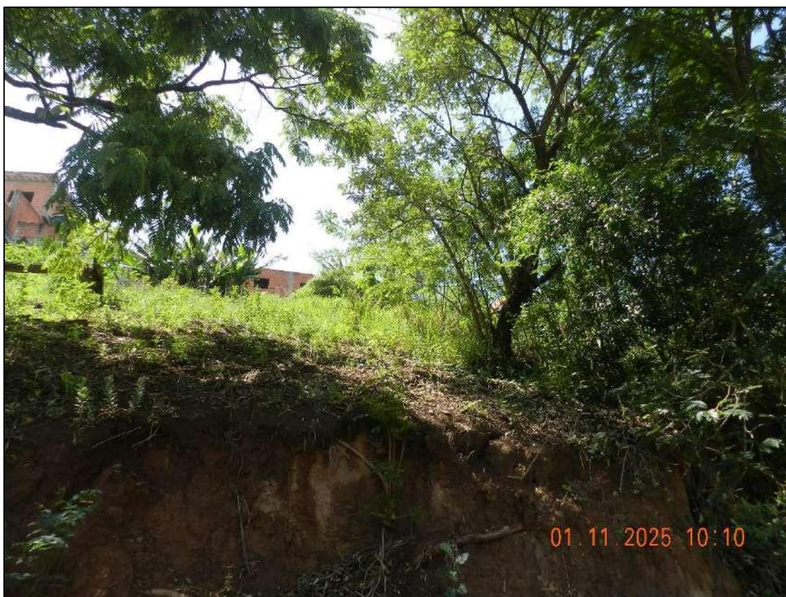
FOTOGRAFIA N° 07: Detalhe para a topografia em active em relação à via.
