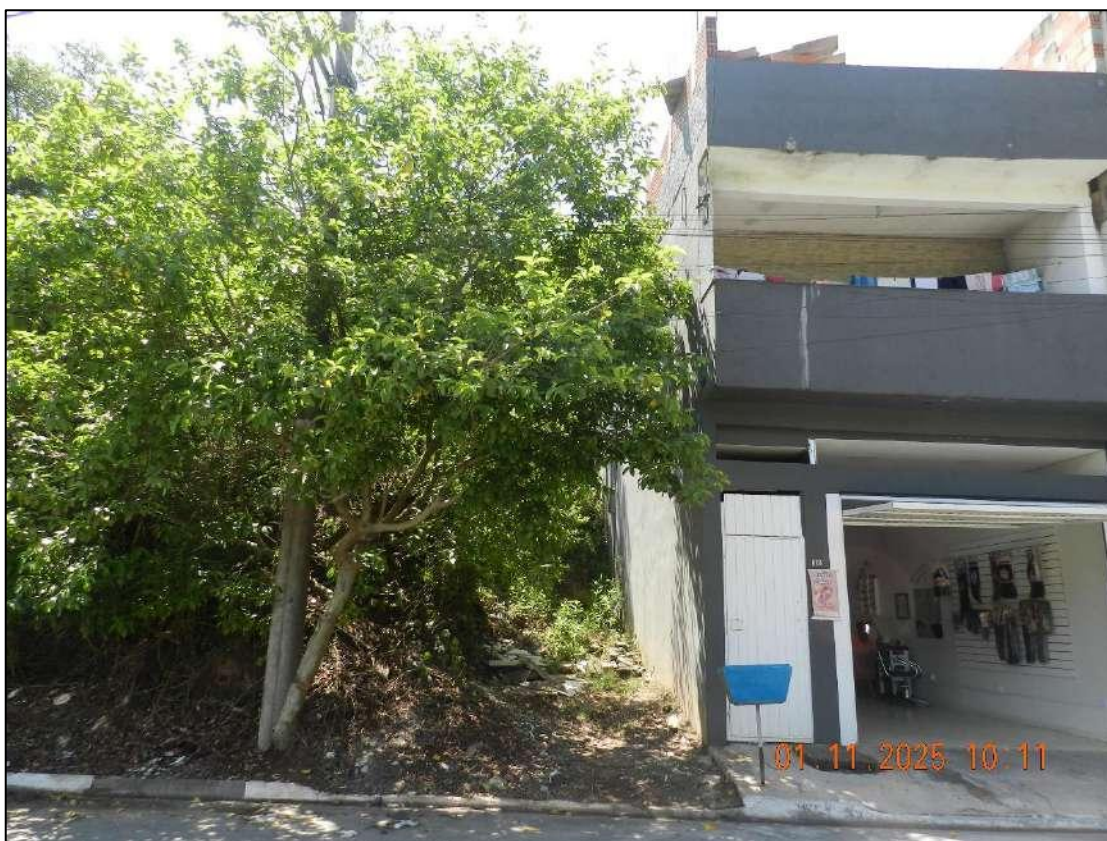
FOTOGRAFIA N° 04: Vista frontal do imóvel objeto.
