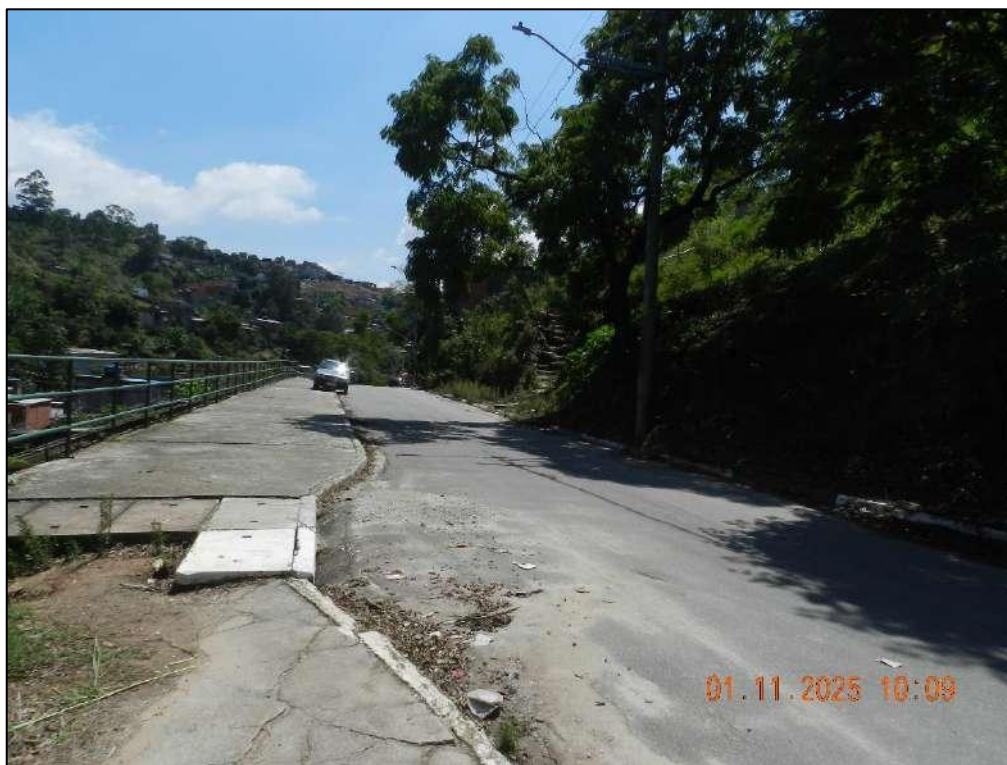
FOTOGRAFIA N° 01: Vista da Rua Clementino Pedroso de Siqueira, no trecho considerado.
