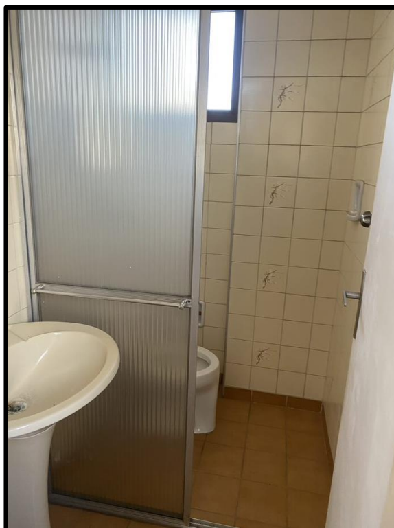
Foto 28: Banheiro de Serviço
