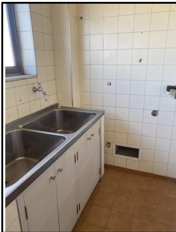
Foto 24: Área de Serviço
