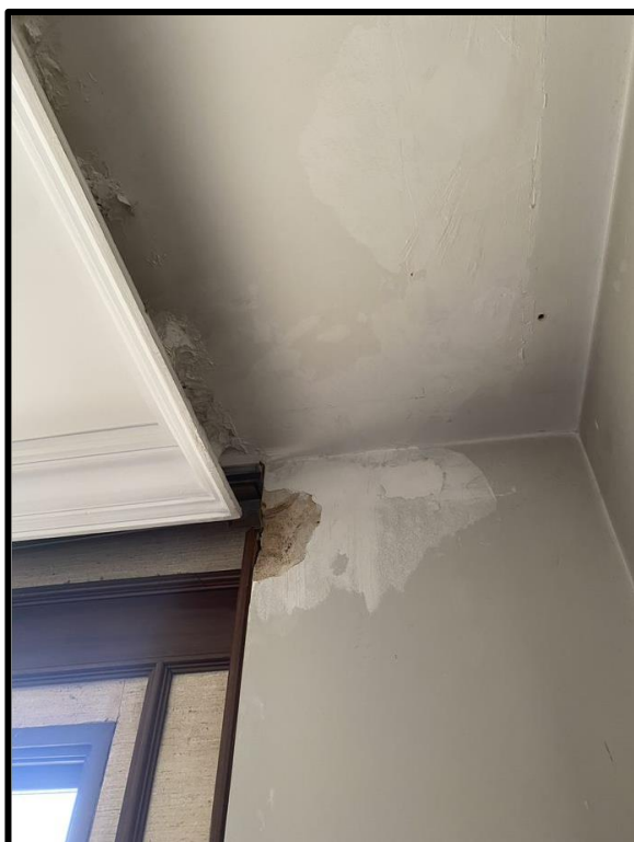
Foto 22: Detalhe infiltração escritório
