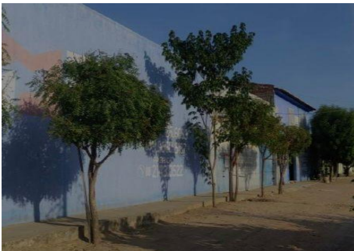
Foto 03 - Vista do imóvel avaliando (Galpão)
