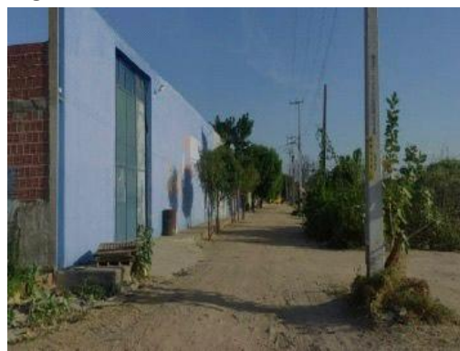
Foto 2 - Fachada do Galpão Avaliando
