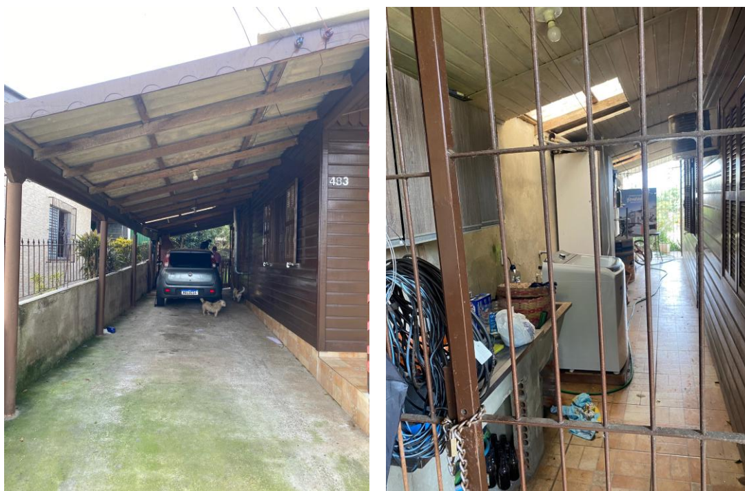
FOTOS 06 e 07: Vista área garagem (vista frente a fundos) ao lado esquerdo da casa (vista frontal da casa pela rua) e área lateral oposta à direita onde há lavanderia (vista fundos a frente)
