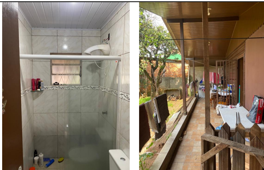
FOTOS 04 e 05: Vista parcial banheiro e varanda fundos
