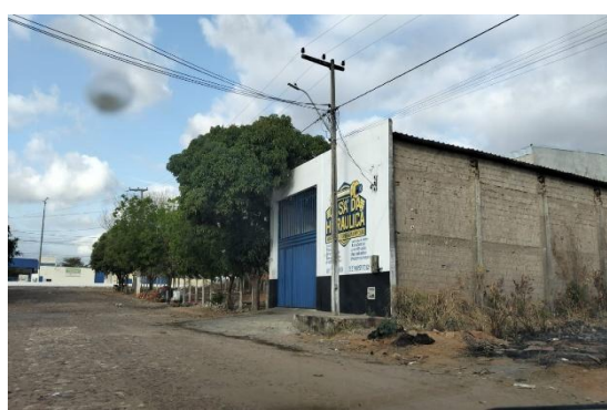
Foto 6 - Vista do Imóvel (Galpão) Avaliando
