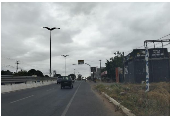
Foto 1 - Av Leão Sampaio - Rod CE060 acesso p/ Rua das Porteiras
