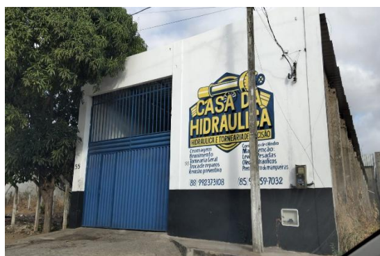
Foto 4 - Fachada frontal do Galpão Avaliando
