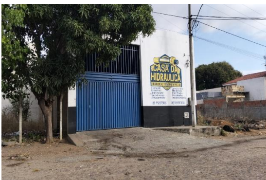
Foto 5 - Vista do Imóvel (Galpão) Avaliando
