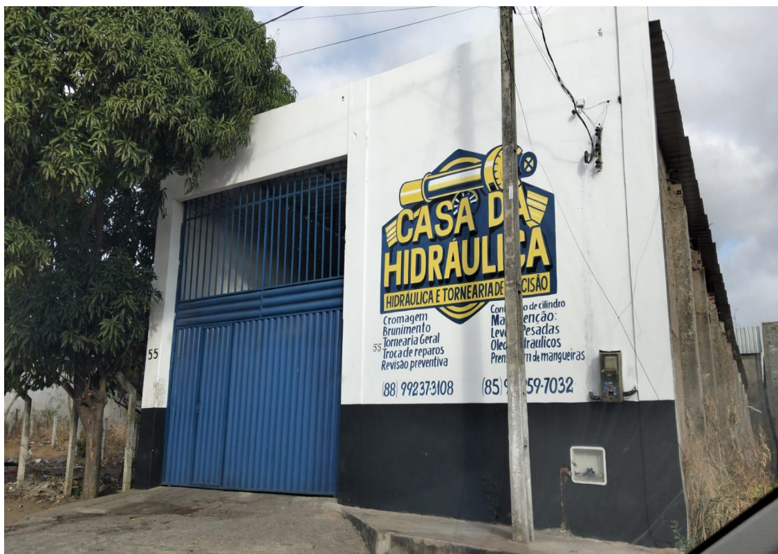
Foto 09 - Vista frontal do imóvel (Galpão) avaliando situado na Rua das Porteiras, nº 55
