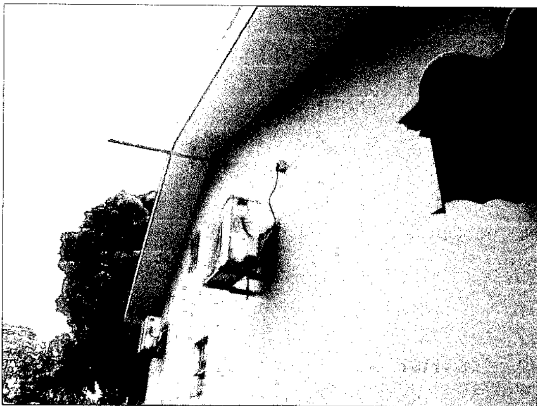
FOTO Nº 08 – LATERAL ESQUERDA DA SEDE
