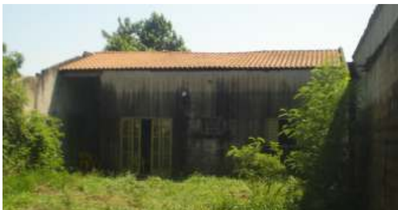
FOTO 02 – Vista da construção existente nos fundos do terreno.
