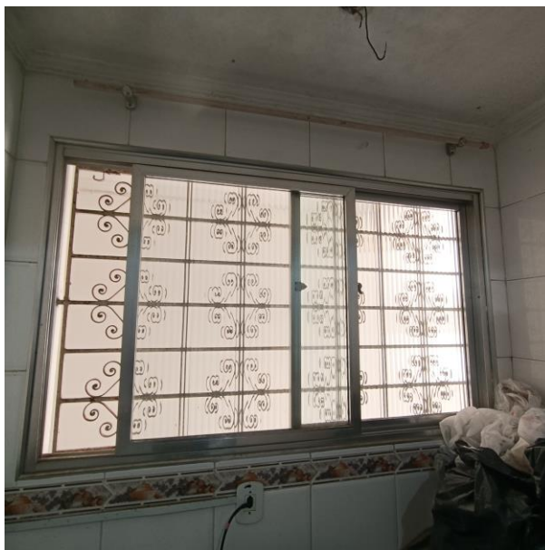
Foto 10 - JANELA ÁREA DE SERVIÇO
