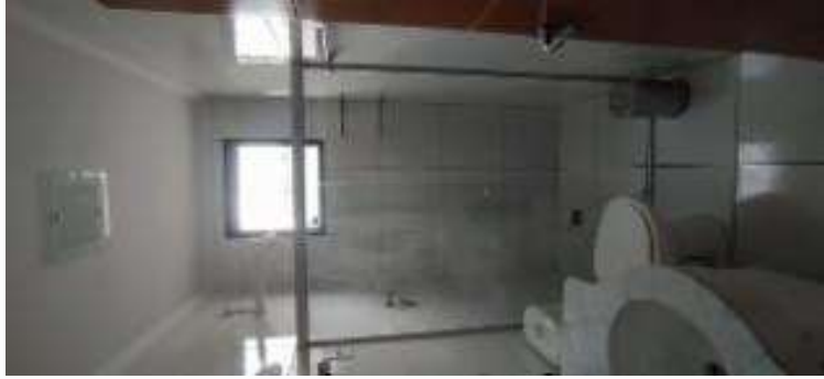
Banheiro Social - Vista 02
