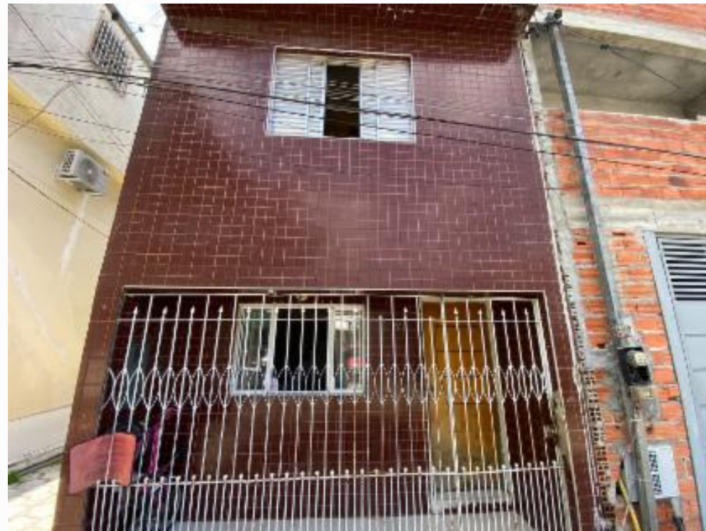
Fachada do imóvel - vista 3
