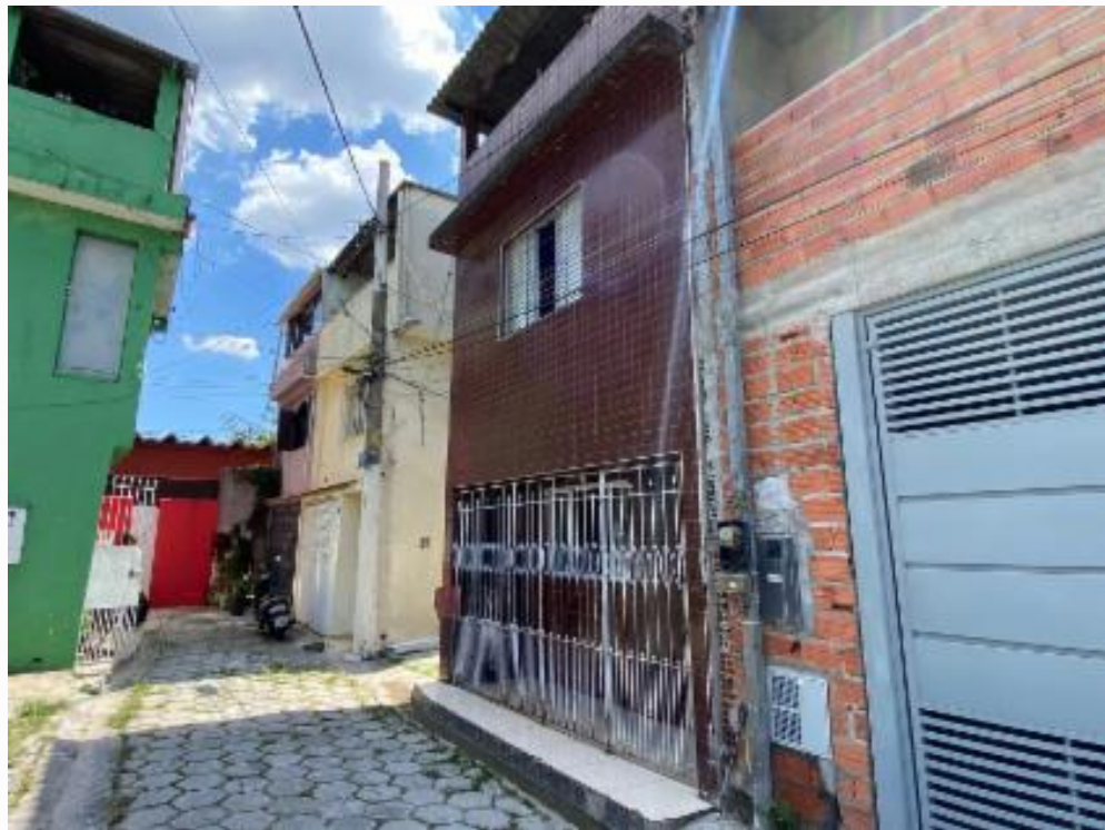
Fachada do imóvel - vista 2
