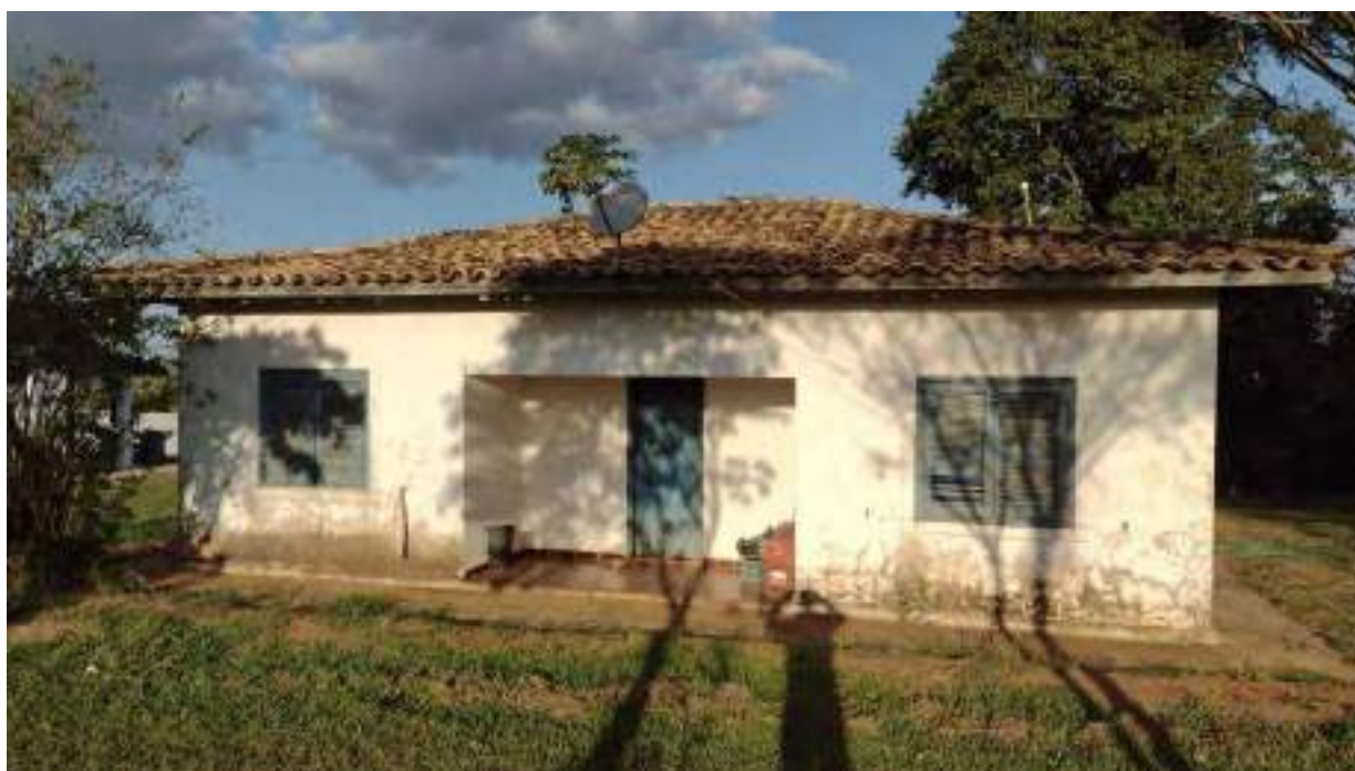
Foto 94 - Vista da fachada da casa 6 da colônia de baixo
