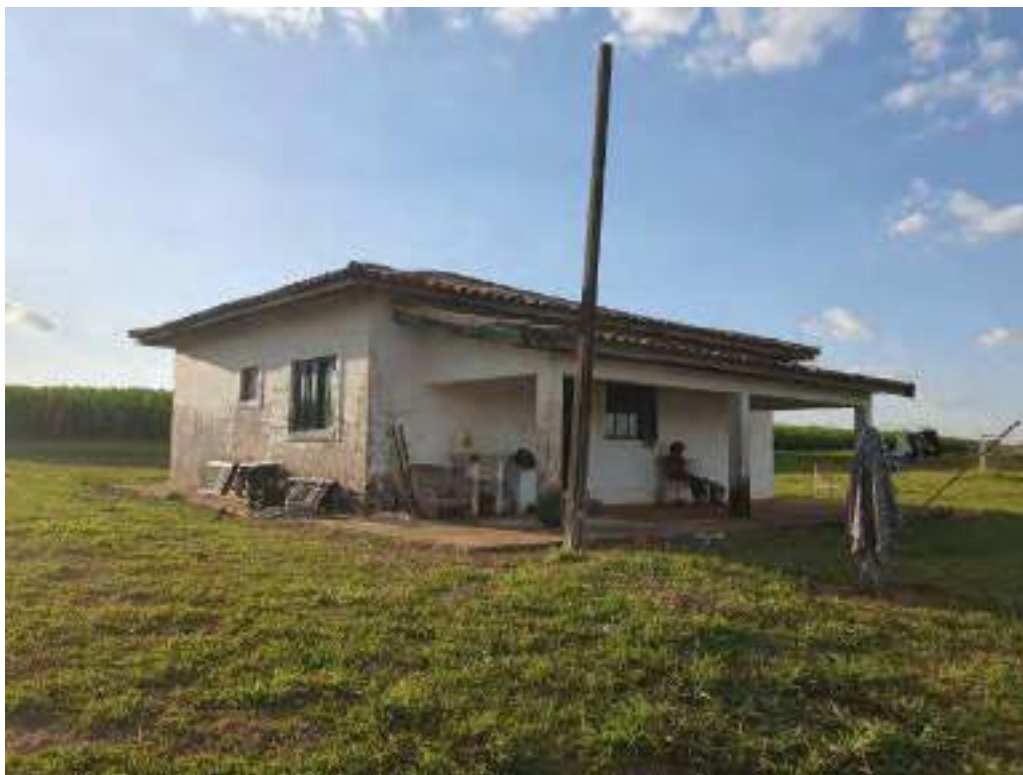
Foto 107 - Vista da fachada lateral e fundos da casa 9 da colônia de baixo
