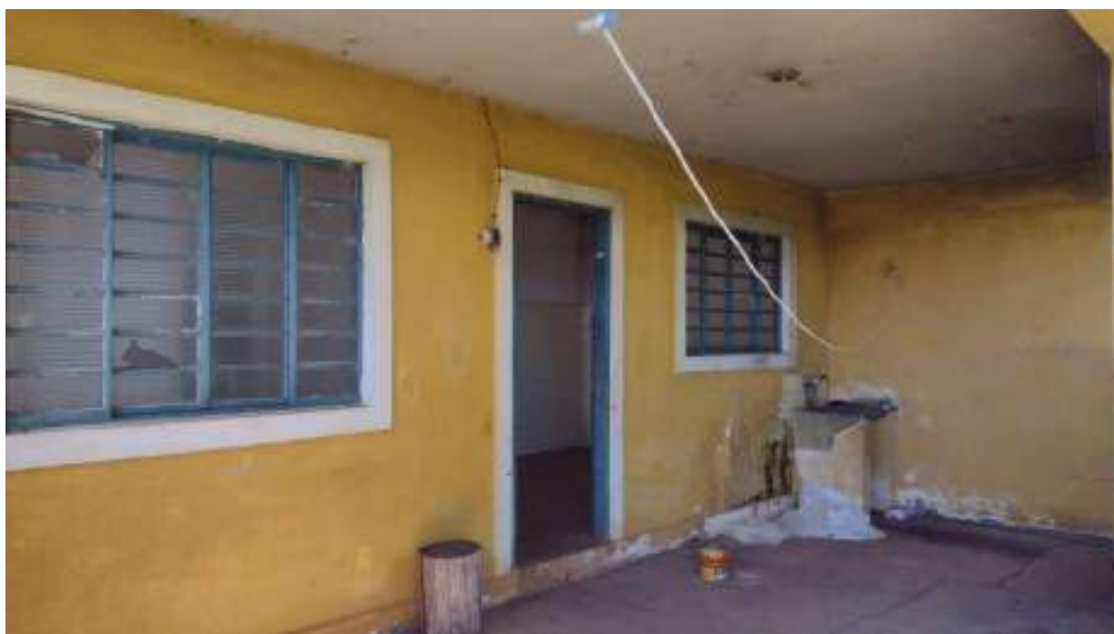
Foto 27 - Vista da varanda da casa de caseiro
