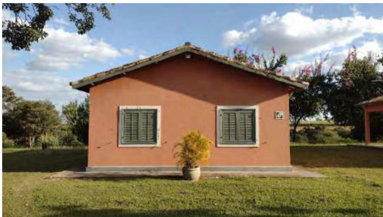
Foto 216 - Vista da fachada da casa 5 da colônia de visitas
