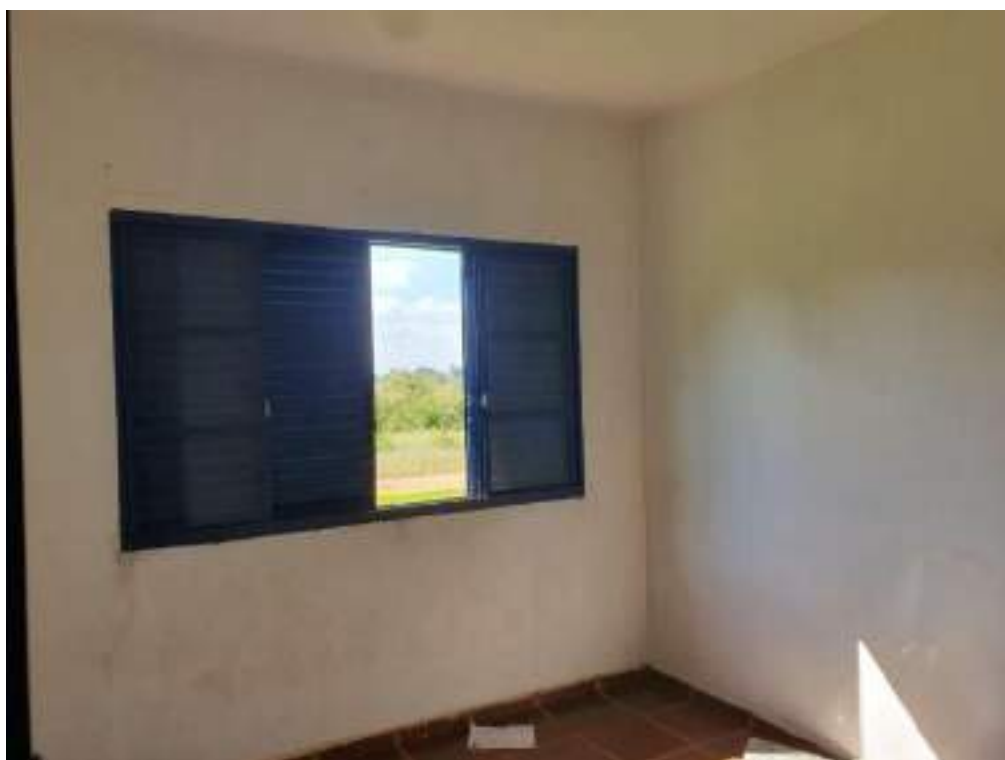
Foto 147 - Vista do dormitório 1 da casa 3 da colônia de cima
