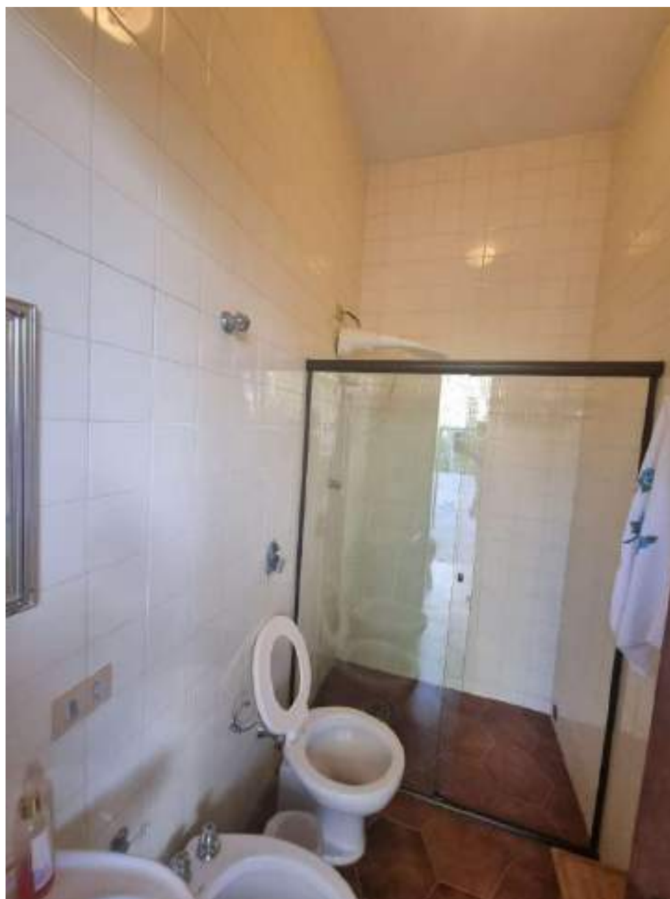
Foto 378 - Vista do banheiro externo 1 da casa sede
