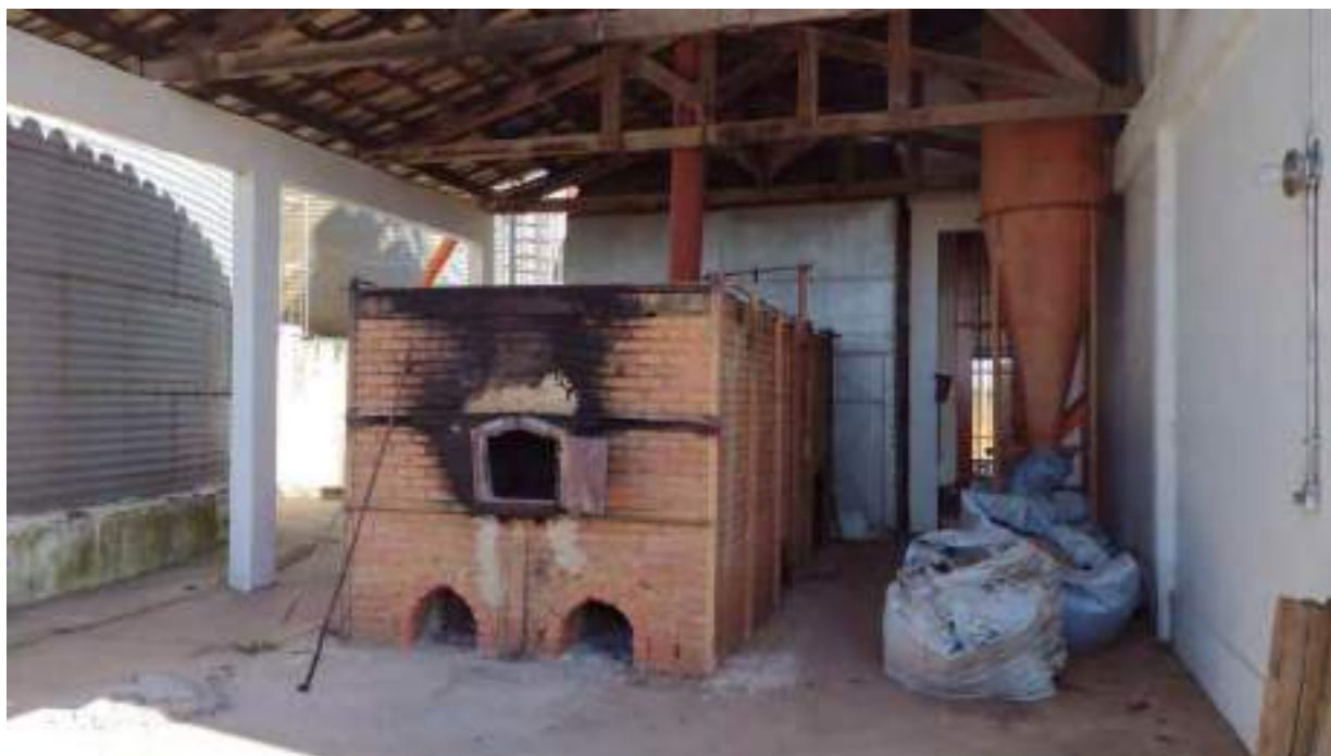
Foto 62 - Vista da fornalha do galpão 4 junto ao silos
