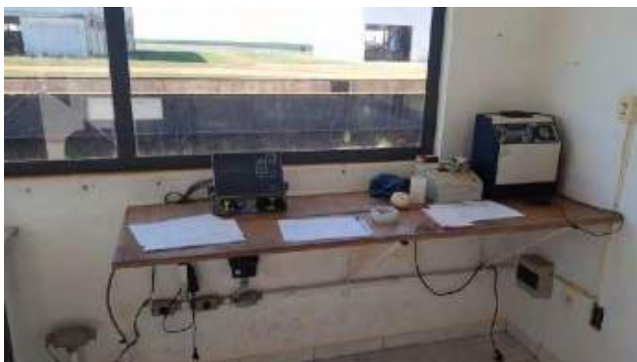
44 – Vista Geral – Equipamentos da Cabine de Recepção e Balança Rodoviária
