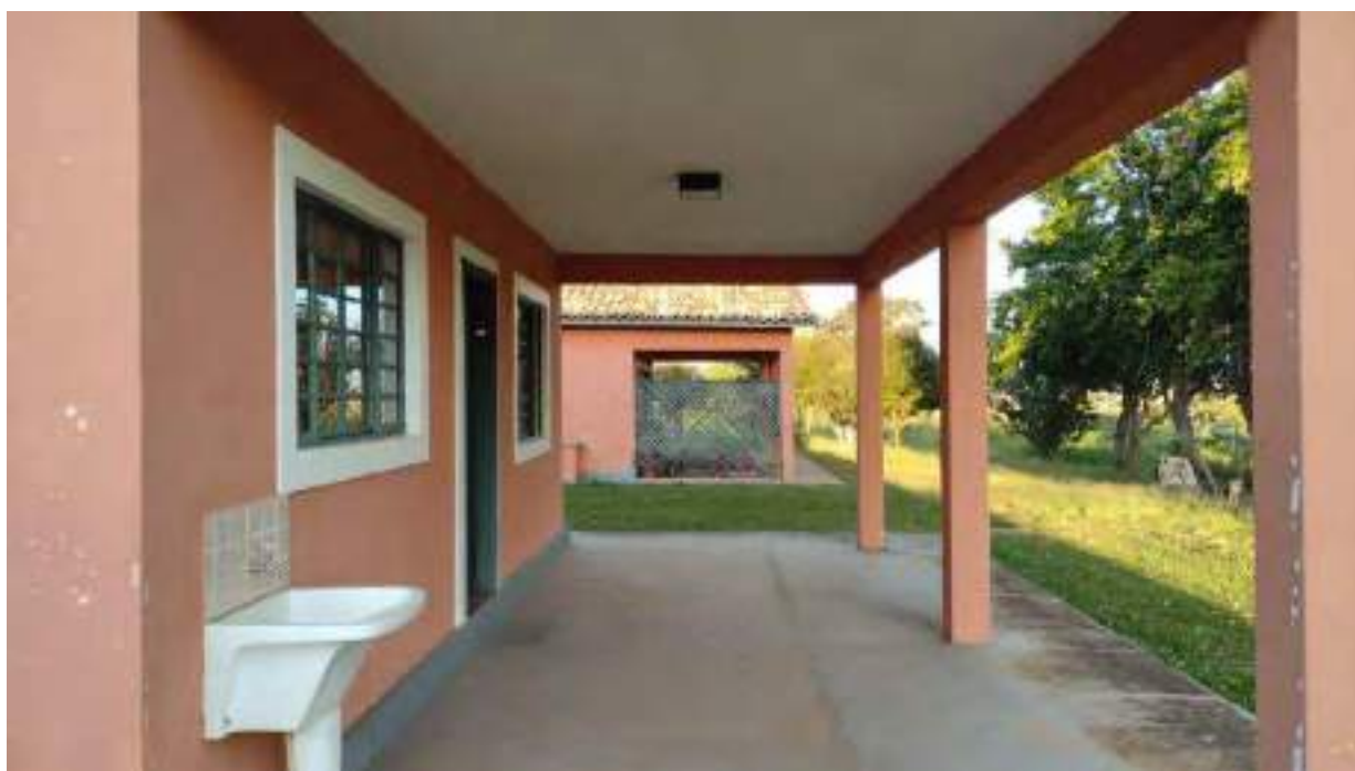
Foto 208 - Vista da varanda dos fundos da casa 4 da colônia de visitas
