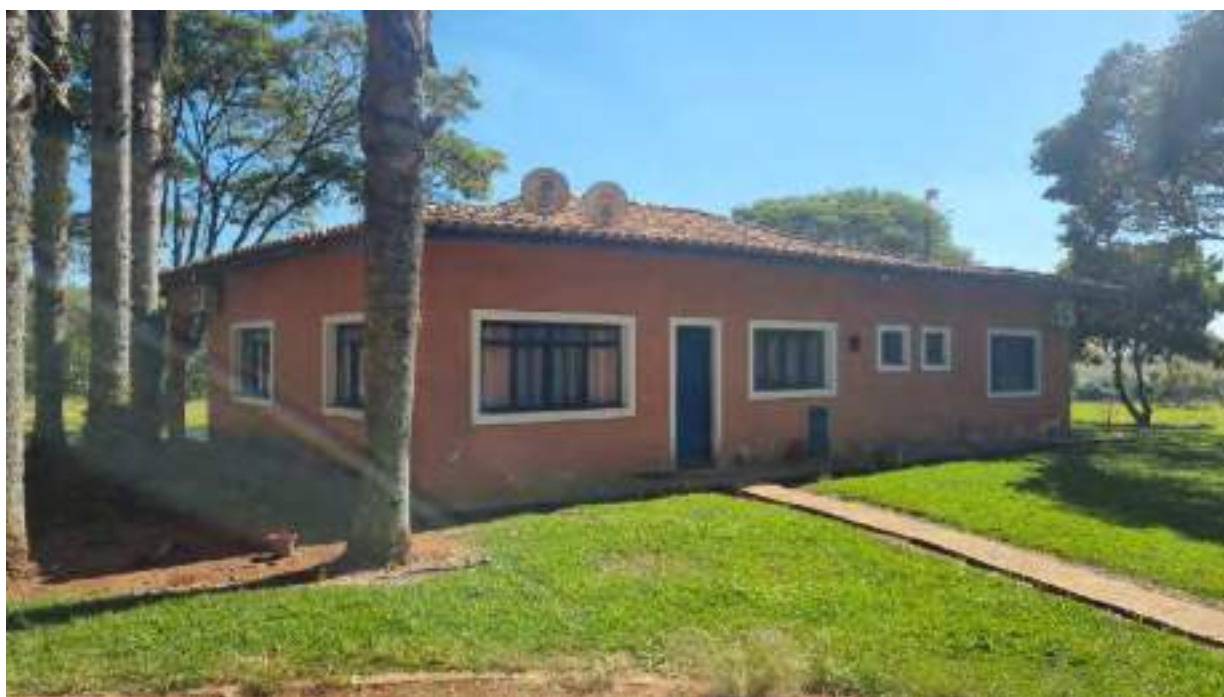
Foto 246 - Vista da fachada do prédio 6, casa do encarregado
