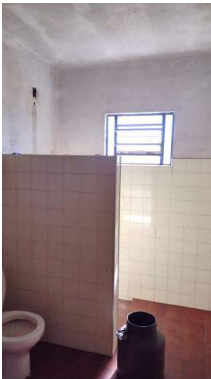
Foto 31 - Vista do banheiro da casa de caseiro
