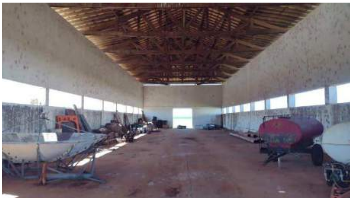
Foto 53 – Outra vista geral interna do galpão 3
