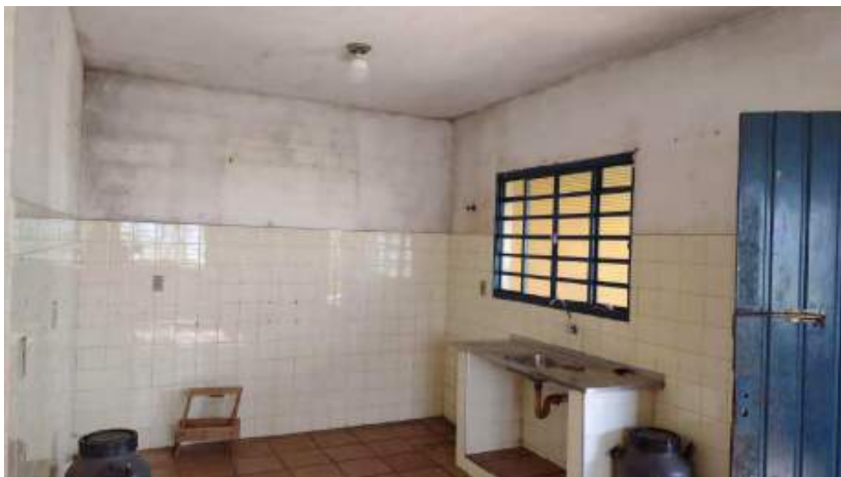
Foto 28 - Vista da cozinha da casa de caseiro
