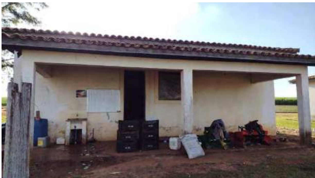
Foto 80 - Vista da fachada dos fundos da casa 1 da colônia de baixo
