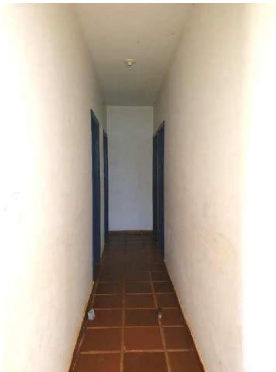
Foto 146 - Vista do corredor de distribuição dos dormitórios da casa 3 da colônia de cima
