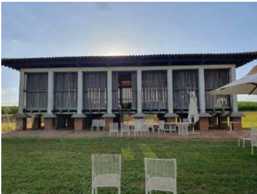
Foto 113 – Outra vista da fachada do barracão de semente
