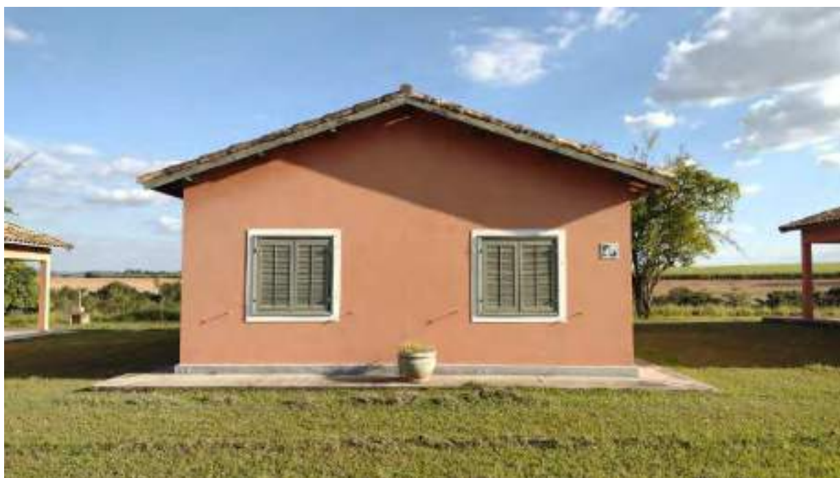
Foto 202 - Vista da fachada da casa 2 da colônia de visitas
