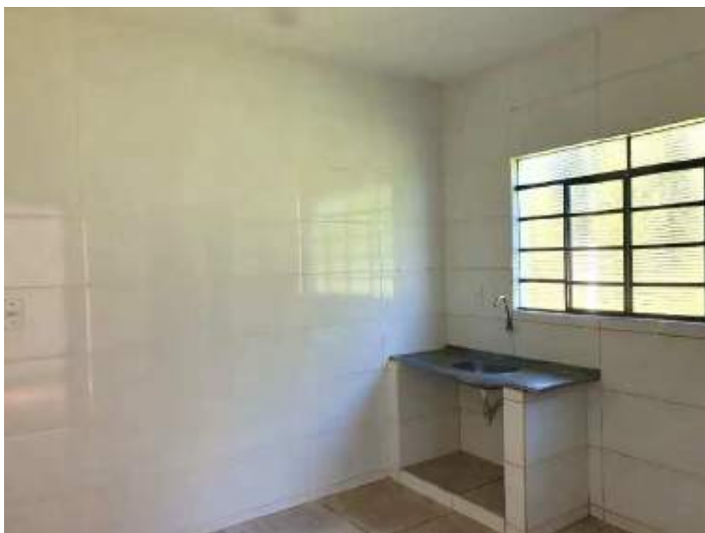
Foto 143 - Vista da cozinha da casa 3 da colônia de cima
