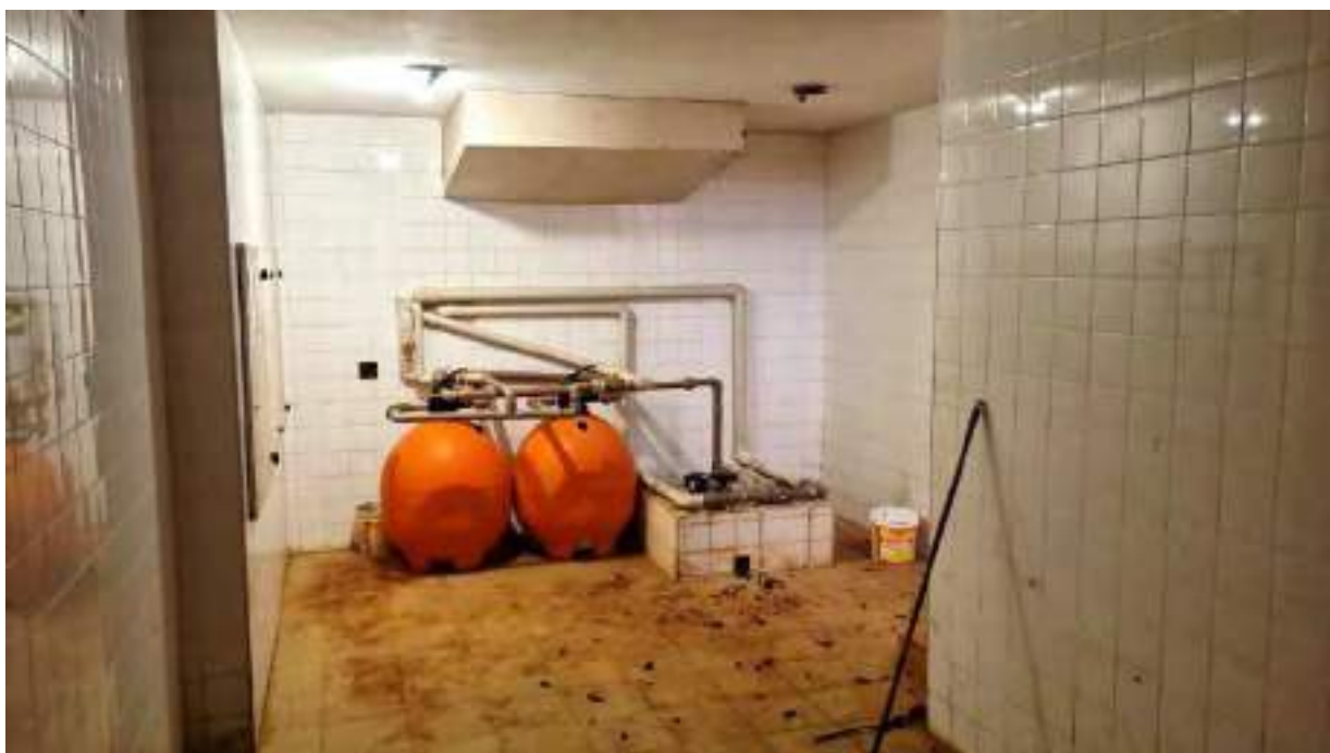
Foto 354 - Vista da casa de comando da piscina
