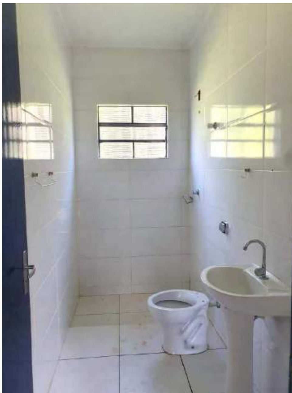
Foto 144 - Vista do banheiro casa 3 da colônia de cima
