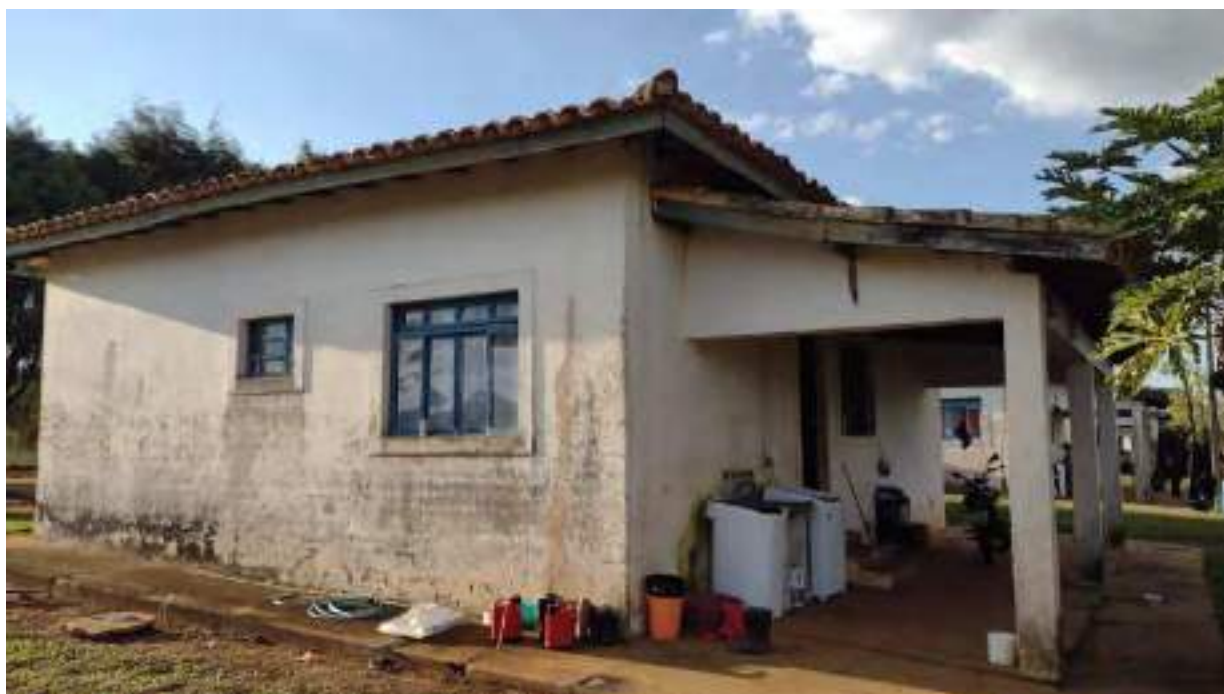
Foto 89 - Vista da fachada dos fundos da casa 3 da colônia de baixo
