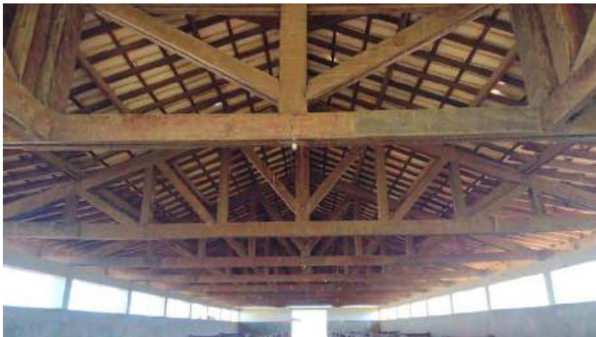
Foto 49 - Vista da cobertura do galpão 2
