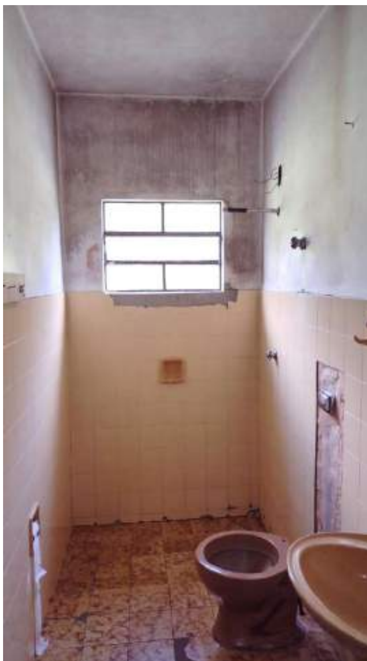
Foto 154 - Vista do banheiro da casa 4 da colônia de cima
