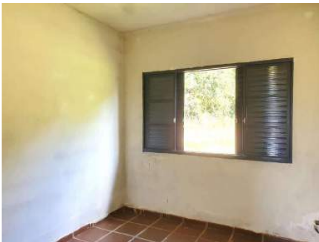
Foto 190 - Vista do dormitório 3 da casa 8 da colônia de cima
