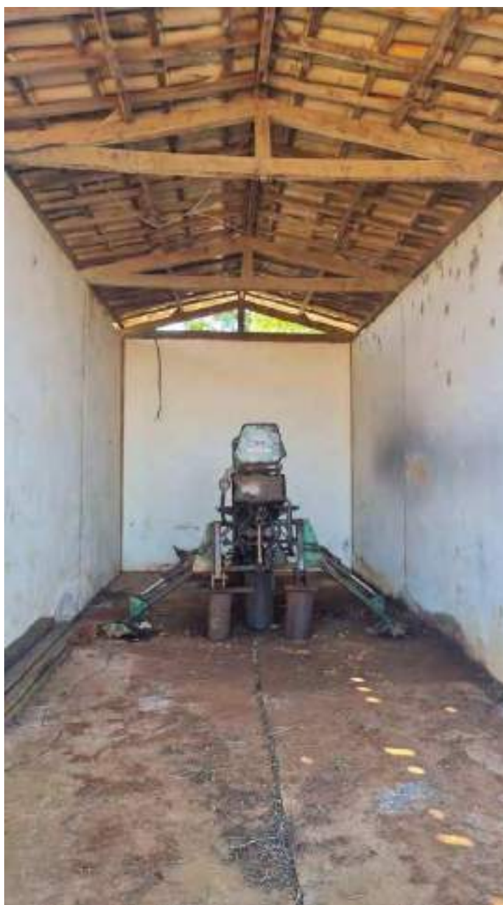
Foto 259 - Vista interna do prédio 8
