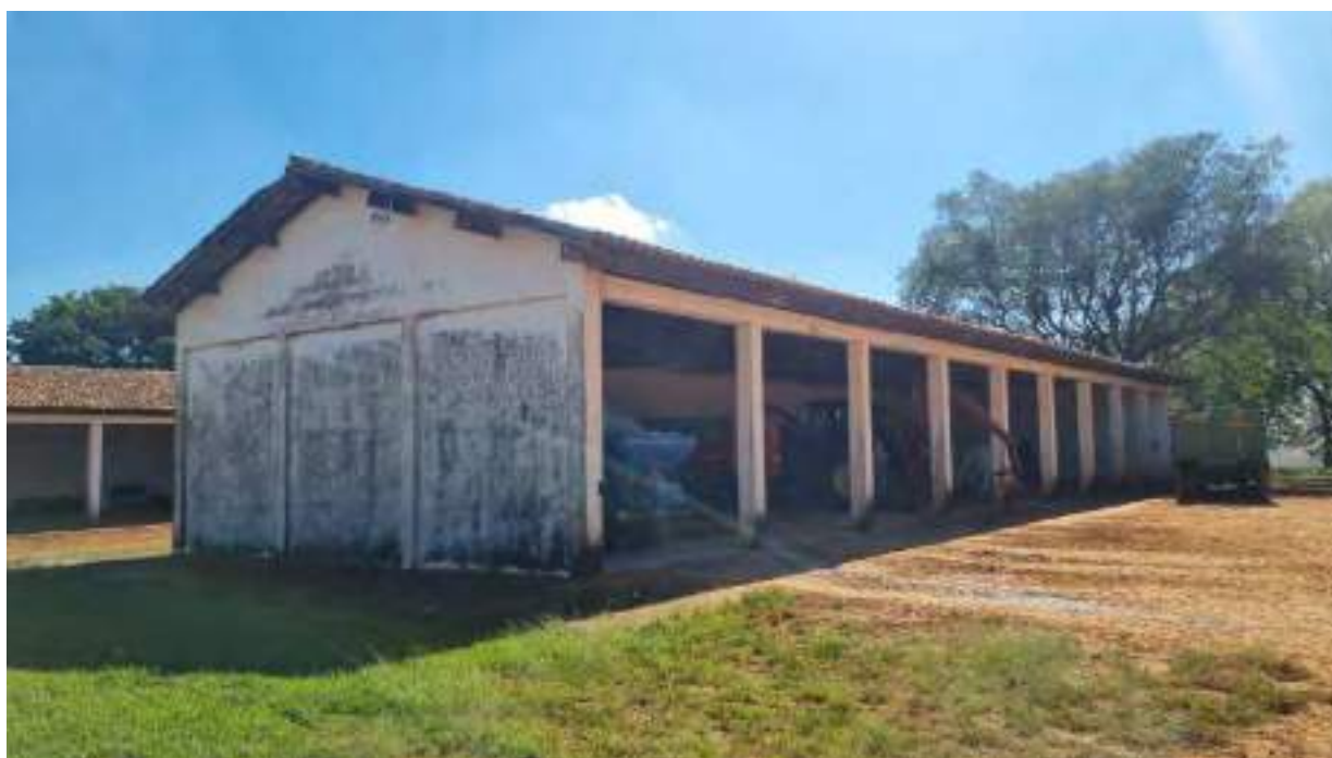
Foto 229 - Vista da fachada do prédio 3
