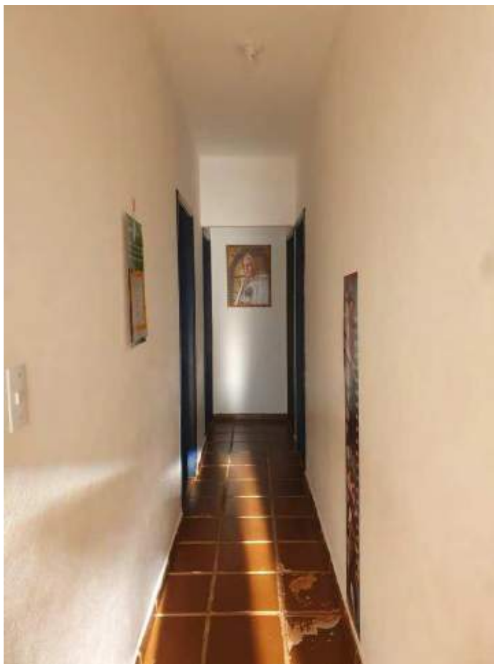
Foto 178 - Vista do corredor de distribuição dos dormitórios da casa 7 da colônia de cima
