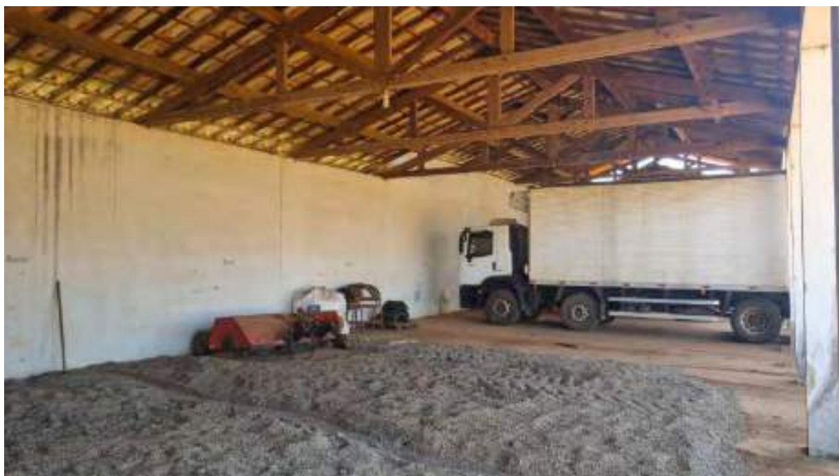
Foto 235 – Outra vista interna do prédio 4
