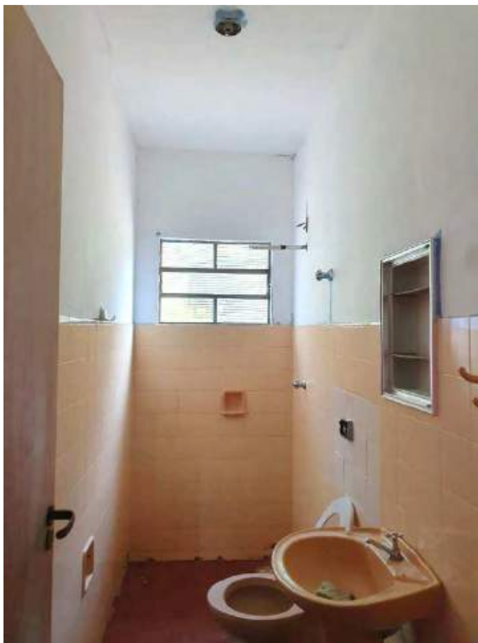
Foto 194 - Vista do banheiro da casa 9 da colônia de cima
