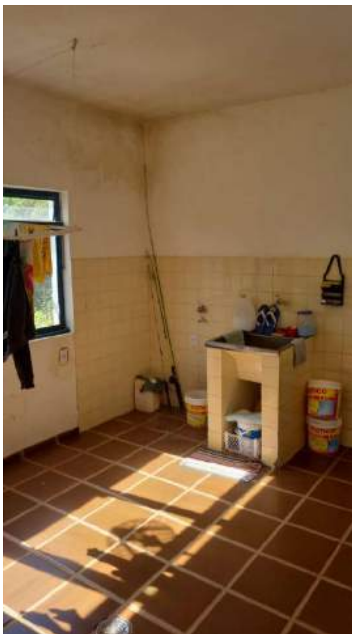
Foto 240 - Vista da área de serviço do prédio 5, administrativo
