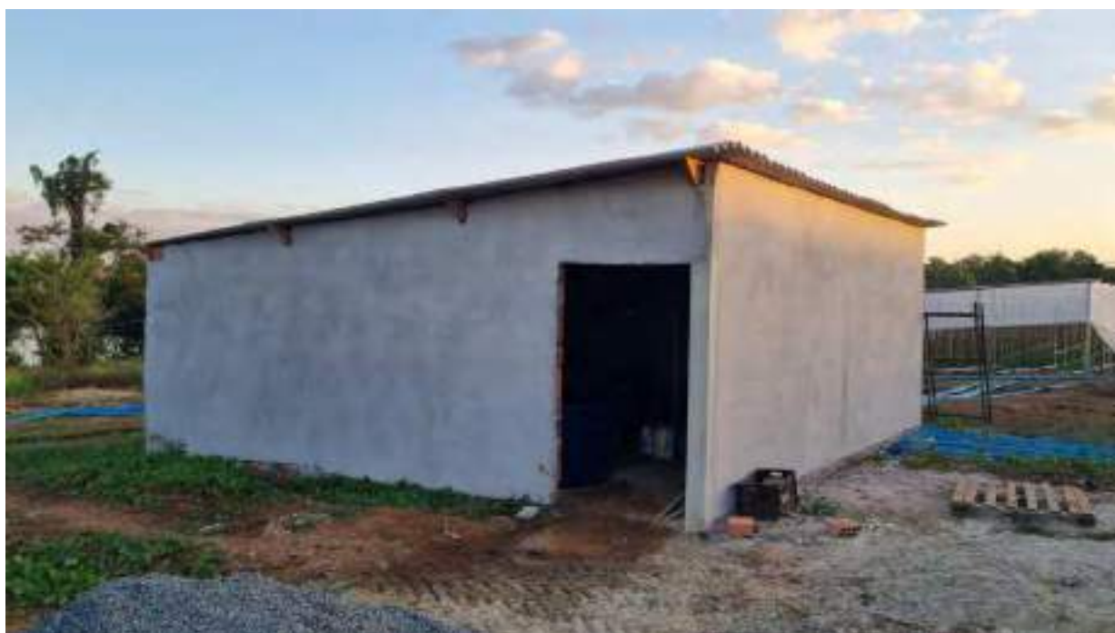
Foto 120 – Vista do galpão novo, abrigo de caixas d'água
