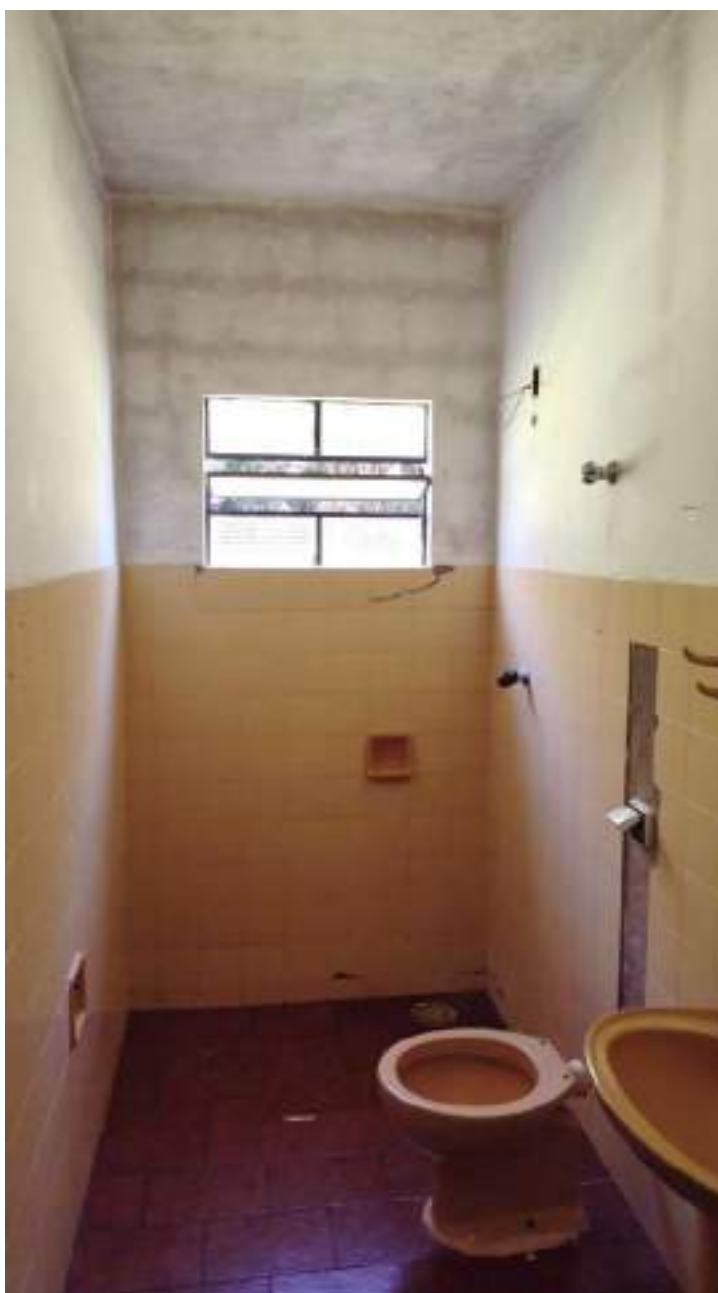
Foto 135 - Vista do banheiro da casa 2 da colônia de cima
