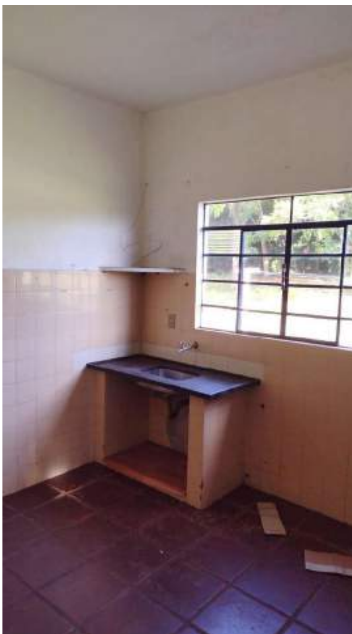
Foto 125 - Vista da cozinha da casa 1 da colônia de cima
