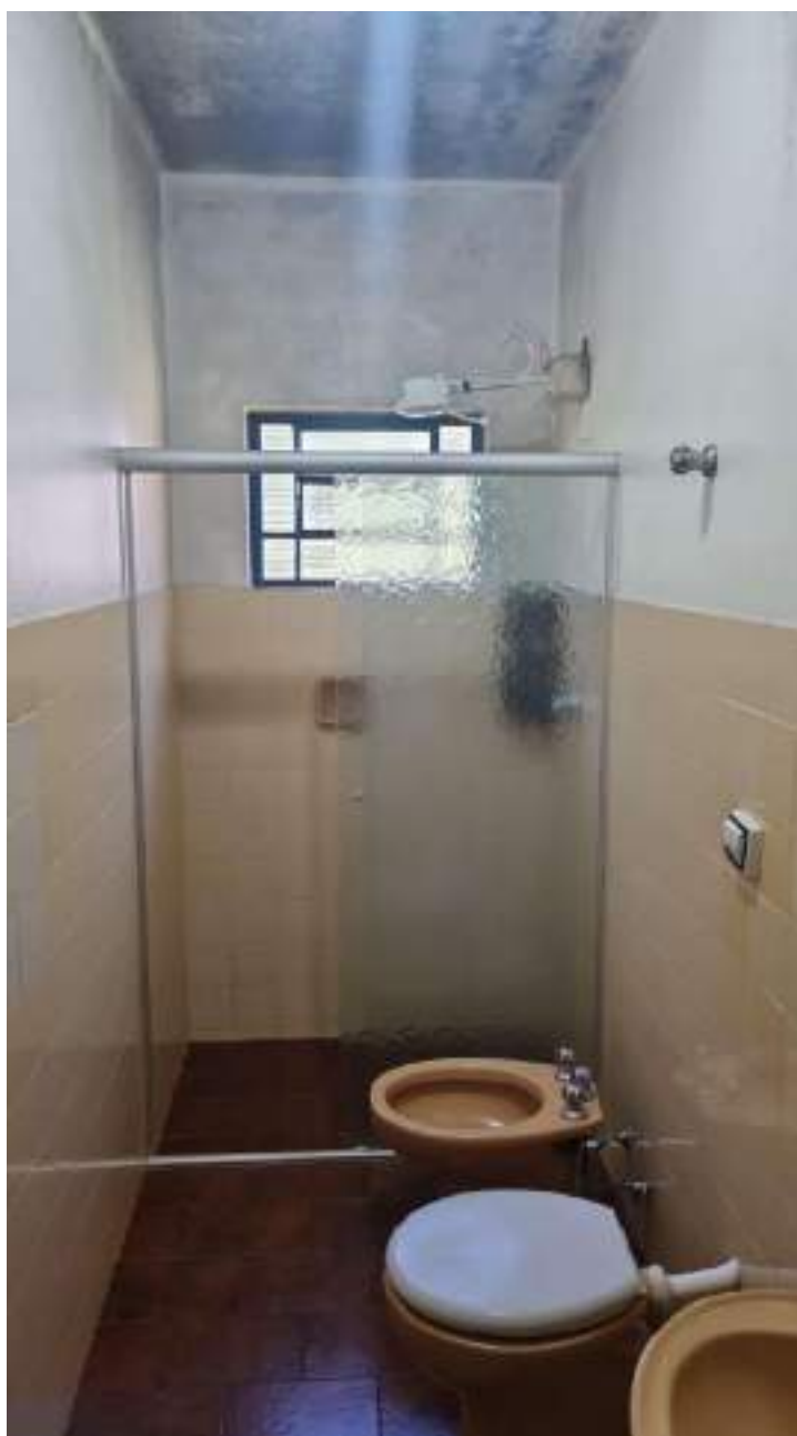
Foto 253 - Vista do banheiro geral 2 do prédio 6, casa do encarregado
