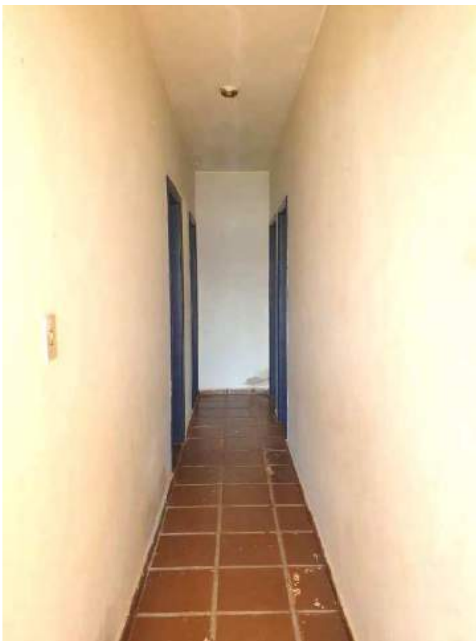
Foto 187 - Vista do corredor de distribuição dos dormitórios da casa 8 da colônia de cima
