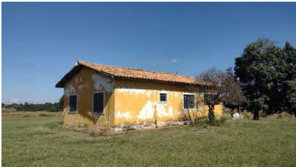
Foto 24 - Vista da fachada da casa de caseiro
