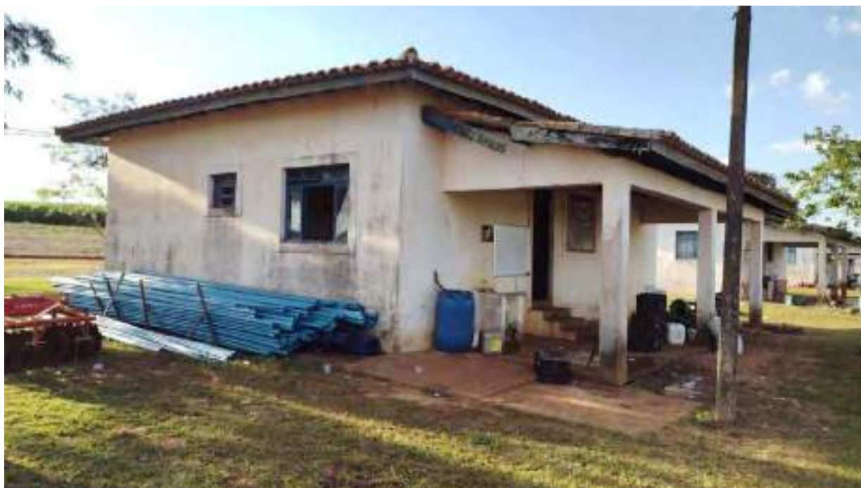
Foto 79 - Vista da fachada dos fundos da casa 1 da colônia de baixo
