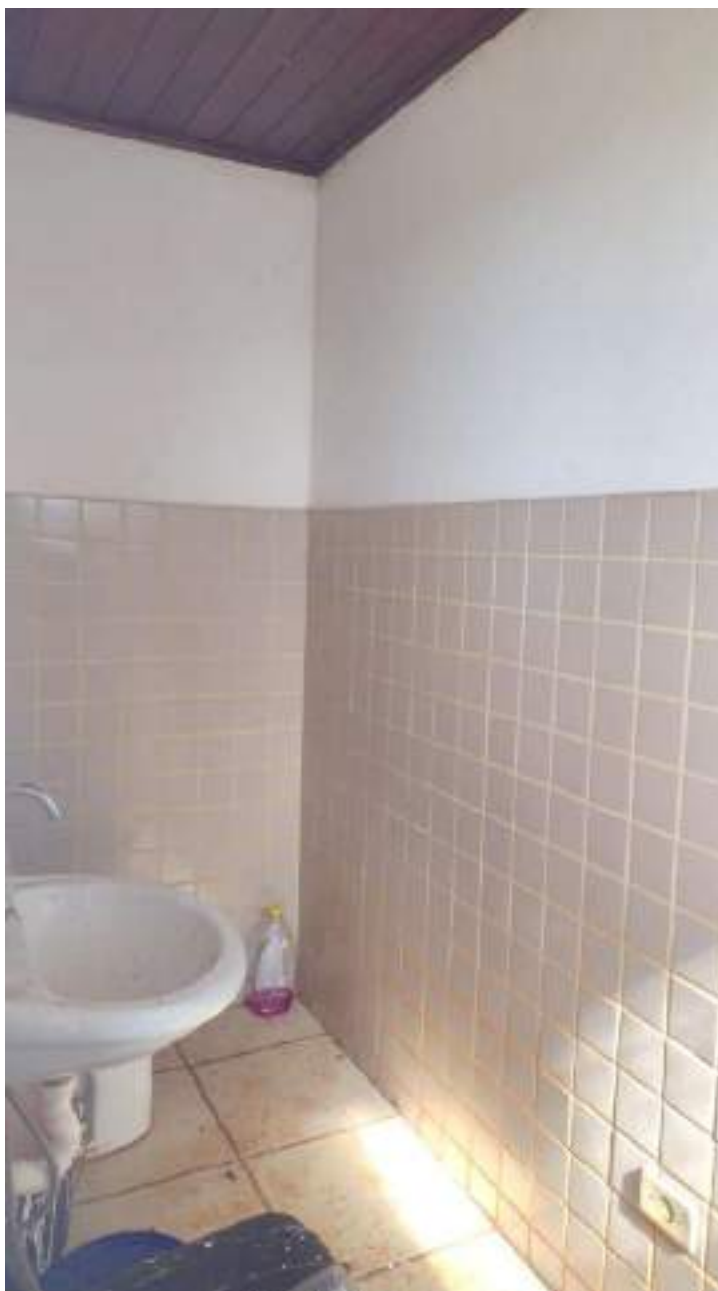
Foto 11 - Vista do banheiro da portaria
