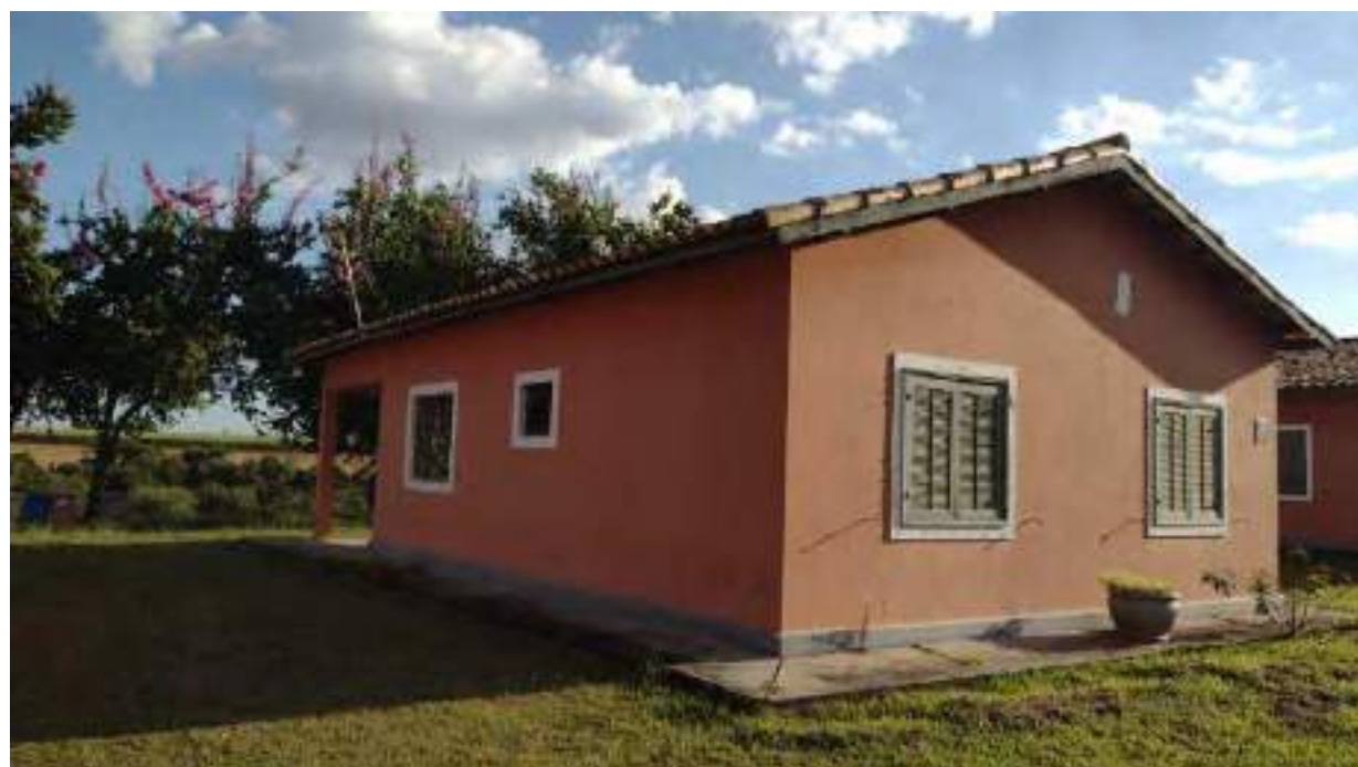
Foto 217 - Vista da fachada e lateral da casa 5 da colônia de visitas
