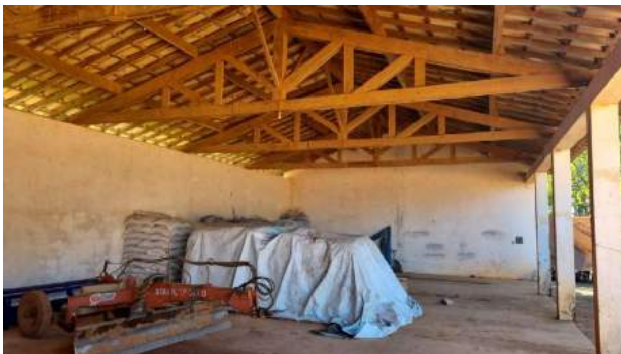
Foto 231 – Outra vista interna do prédio 3
