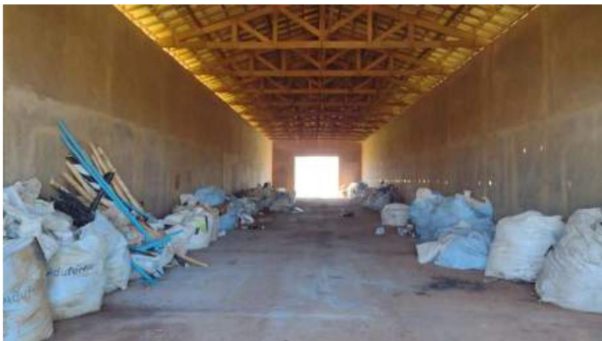
Foto 41 – Outra vista geral interna do galpão 1
