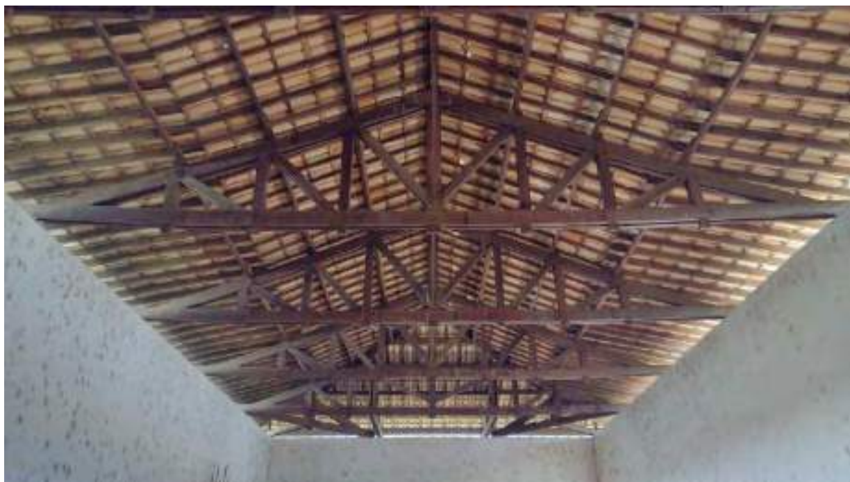
Foto 54 - Vista da cobertura do galpão 3
