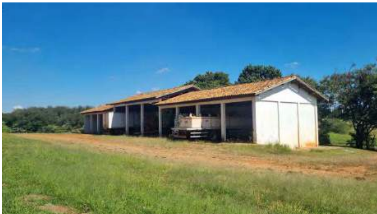
Foto 232 - Vista da fachada do prédio 4
