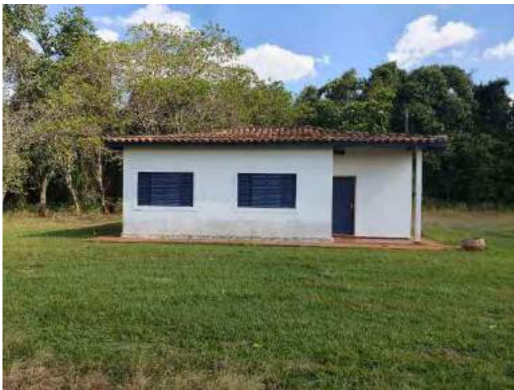
Foto 191 - Vista da fachada da casa 9 da colônia de cima
