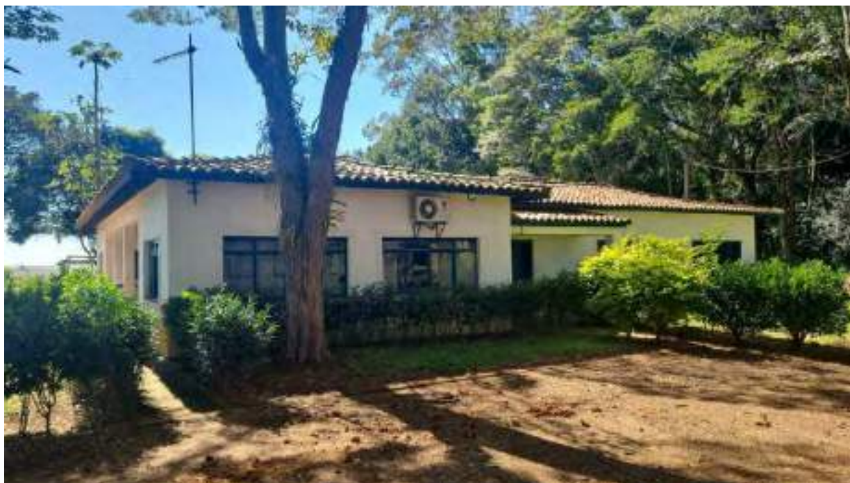
Foto 236 - Vista da fachada do prédio 5, administrativo
