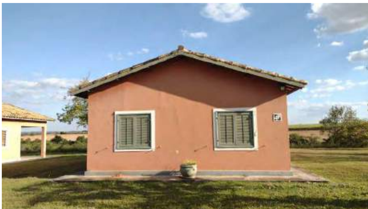
Foto 200 - Vista da fachada da casa 1 da colônia de visitas
