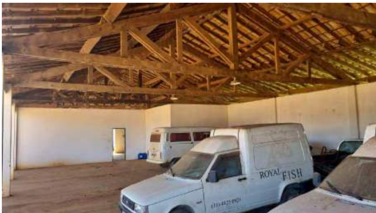
Foto 223 – Vista da garagem do prédio 1
