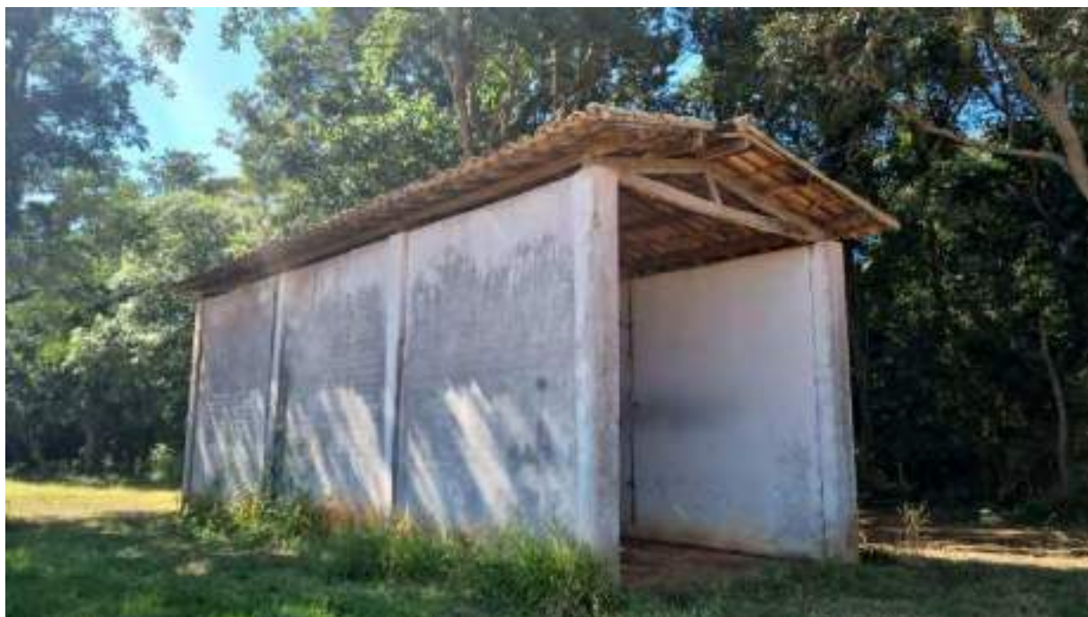
Foto 258 - Vista da fachada do prédio 8
