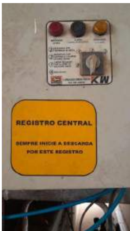
11 e 12 – Paineis de Controle eletropneumático
