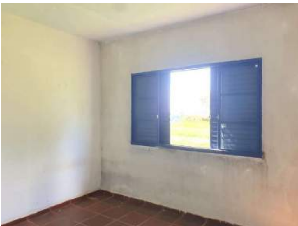
Foto 188 - Vista do dormitório 1 da casa 8 da colônia de cima
