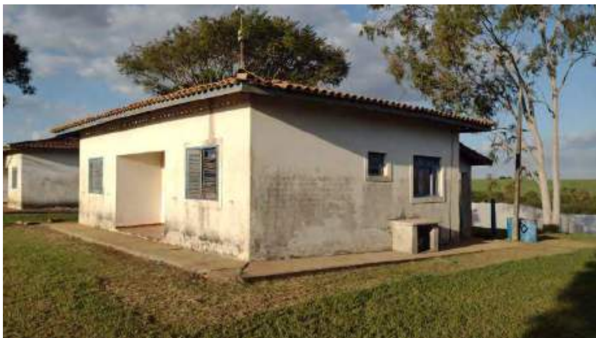
Foto 91 - Vista da fachada lateral e fundos da casa 4 da colônia de baixo
