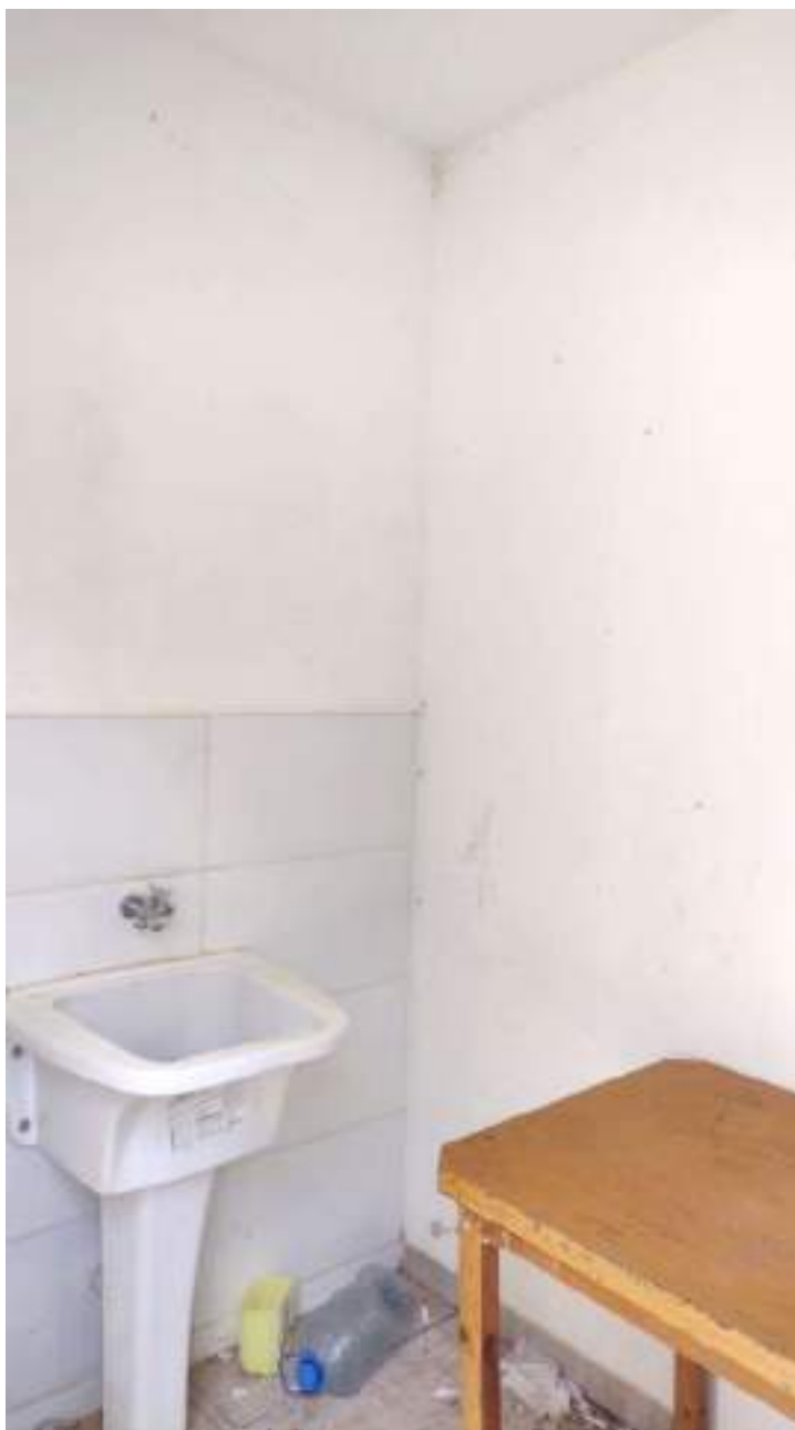
Foto 165 - Vista da área de serviço da casa 5 da colônia de cima
