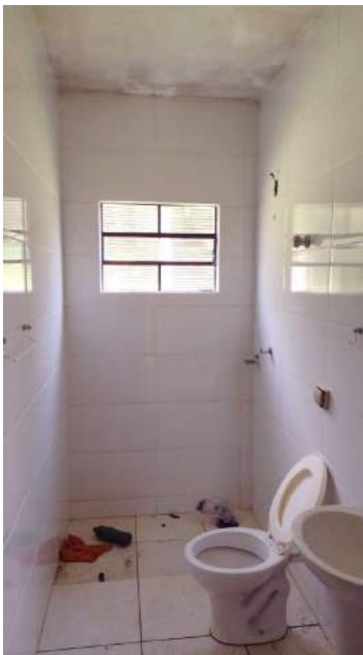
Foto 164 - Vista do banheiro da casa 5 da colônia de cima
