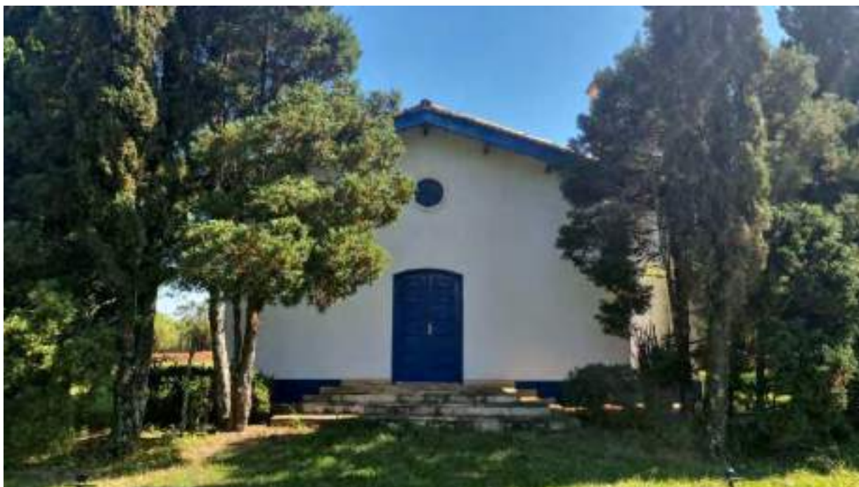
Foto 285 - Vista da fachada da capela
