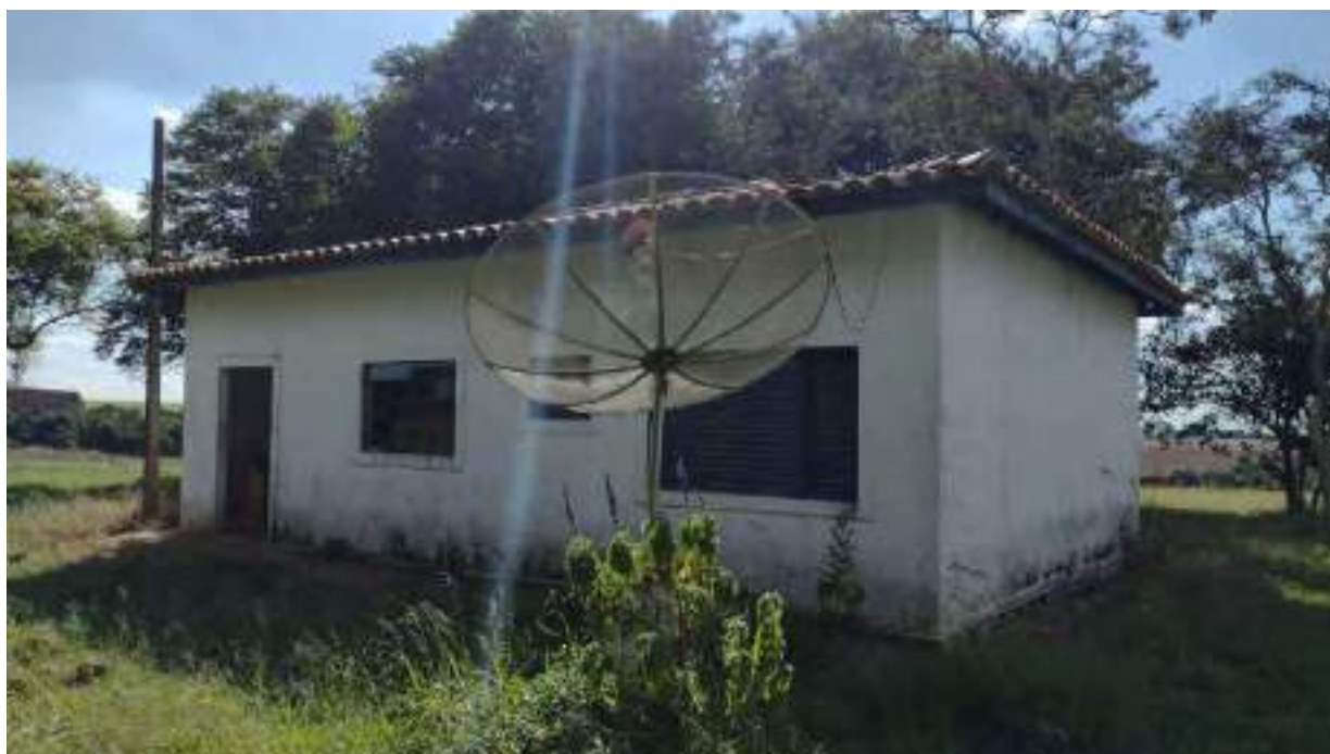
Foto 123 - Vista da fachada dos fundos da casa 1 da colônia de cima
