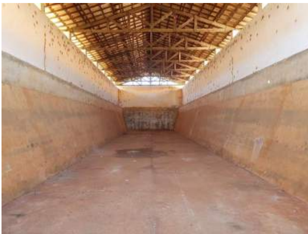
Foto 70 - Outra vista geral interna do galpão 2 em frente ao silos
