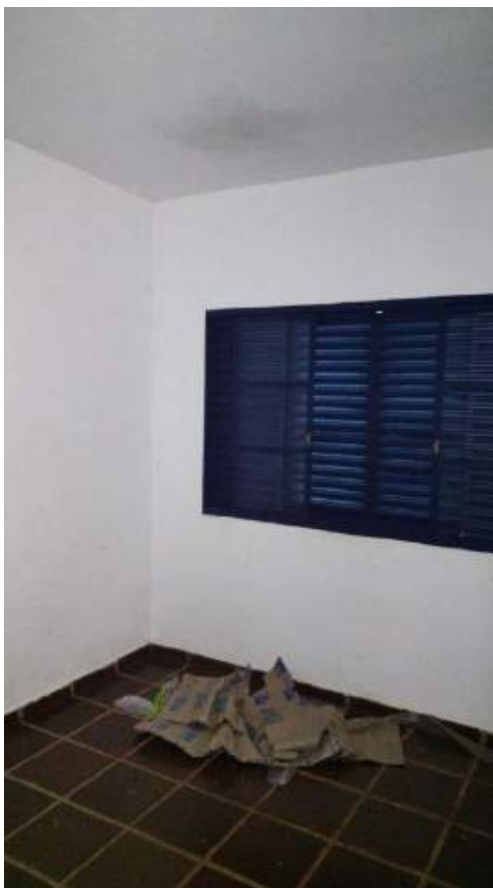
Foto 169 - Vista do dormitório 3 da casa 5 da colônia de cima
