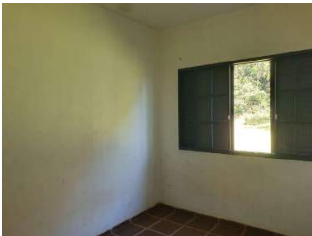
Foto 148 - Vista do dormitório 2 da casa 3 da colônia de cima
