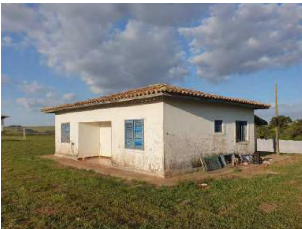
Foto 105 - Vista da fachada lateral e fundos da casa 8 da colônia de baixo
