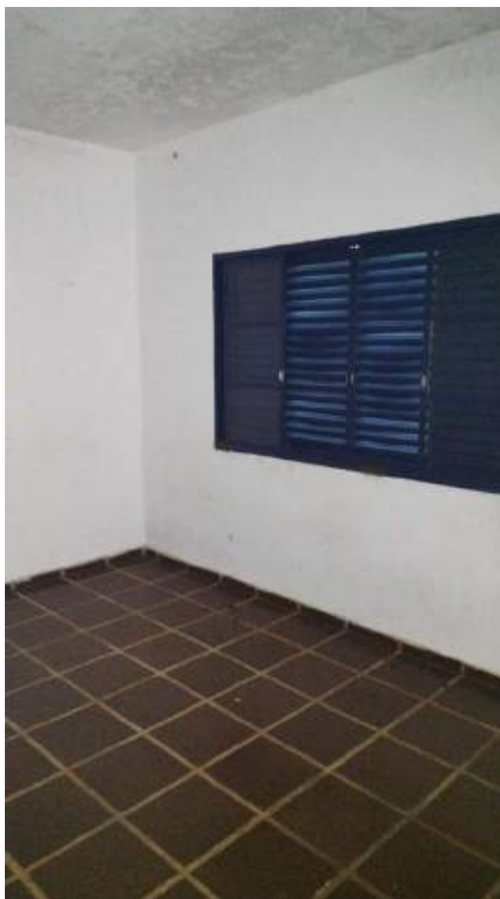
Foto 129 - Vista do dormitório 1 da casa 1 da colônia de cima
