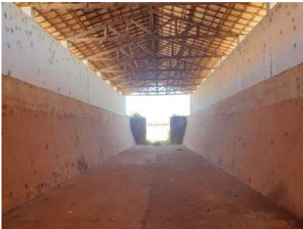
Foto 66 - Vista geral interna do galpão 1 em frente aos silos
