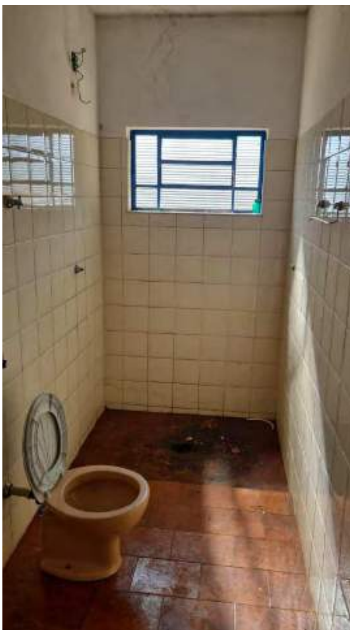
Foto 279 - Vista do banheiro da casa frontal
