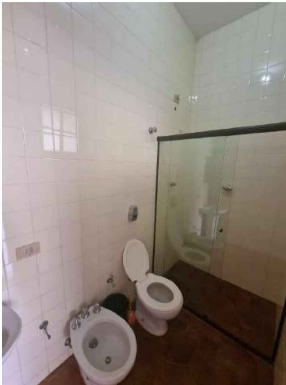
Foto 379 - Vista do banheiro externo 2 da casa sede
