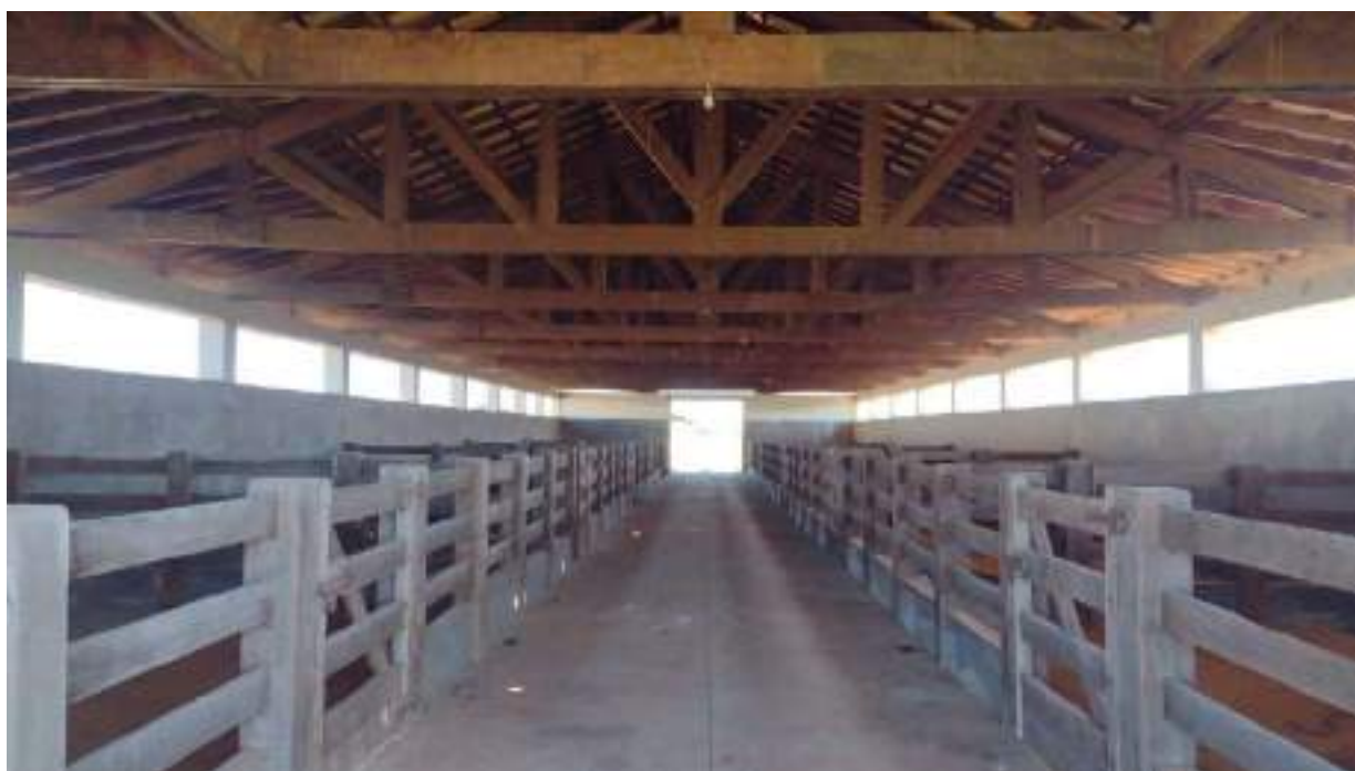
Foto 46 - Vista geral interna do galpão 2
