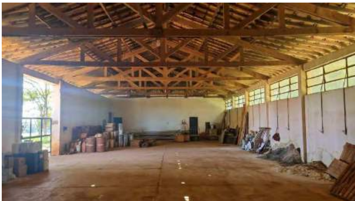
Foto 228 - Vista interna do prédio 2
