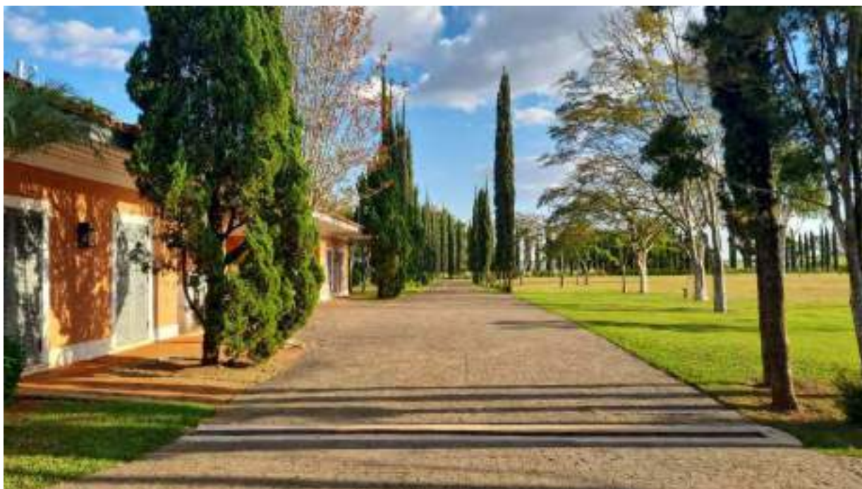
Foto 370 - Vista geral da área de circulação
