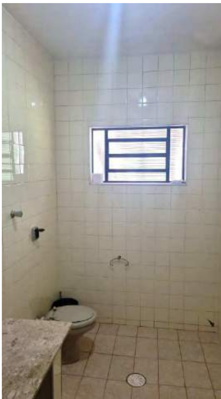
Foto 242 - Vista do banheiro do prédio 5, administrativo
