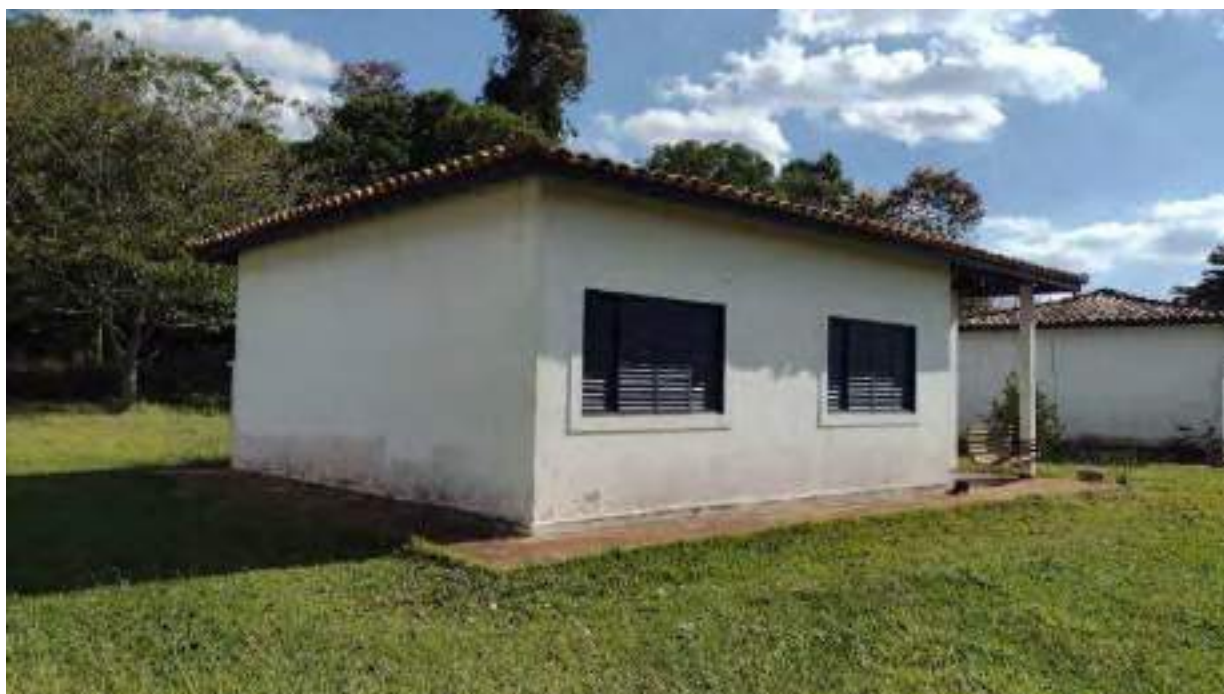
Foto 173 - Vista da fachada dos fundos da casa 7 da colônia de cima
