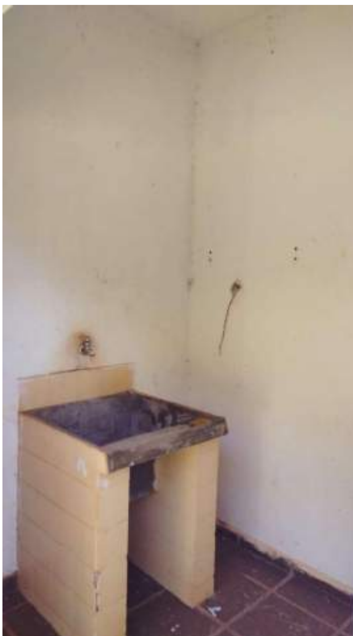
Foto 127 - Vista da área de serviço da casa 1 da colônia de cima
