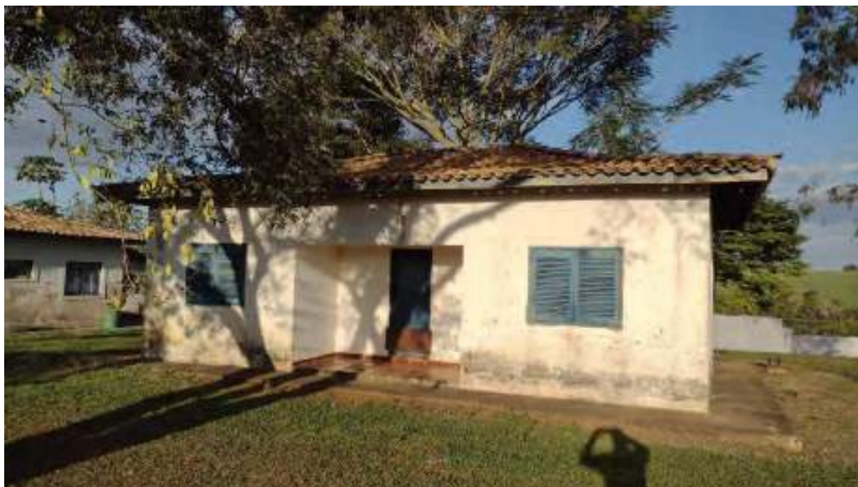
Foto 92 - Vista da fachada da casa 5 da colônia de baixo
