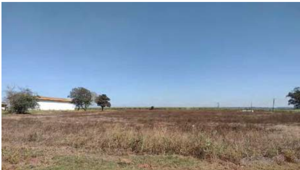
Foto 15 - Outra vista geral da circulação interna
