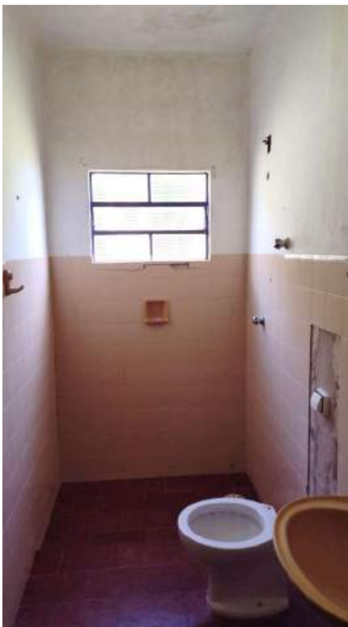
Foto 126 - Vista do banheiro da casa 1 da colônia de cima
