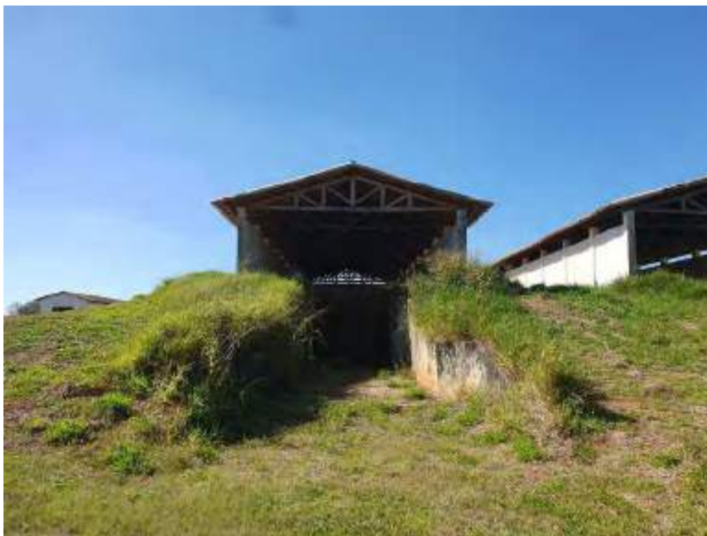
Foto 63 - Vista da fachada do galpão 1 em frente ao silos
