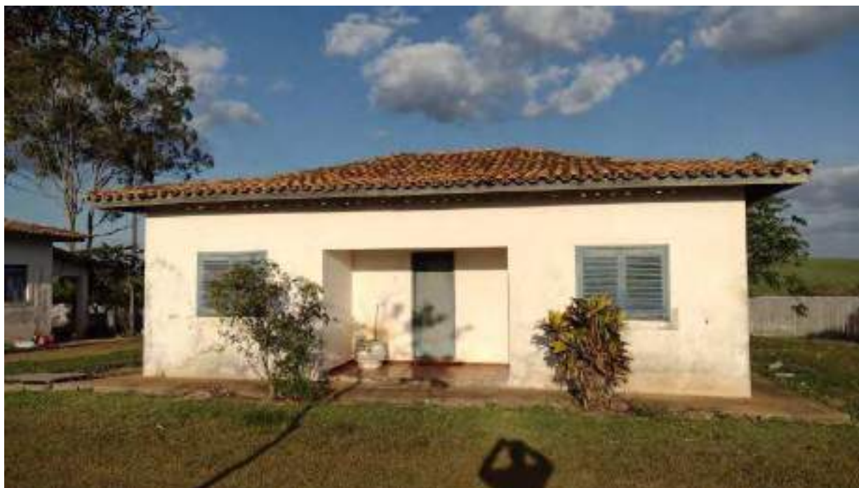
Foto 86 - Vista da fachada da casa 2 da colônia de baixo
