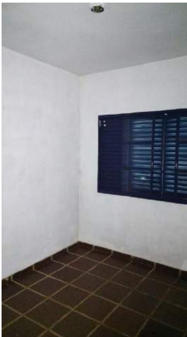
Foto 159 - Vista do dormitório 3 da casa 4 da colônia de cima
