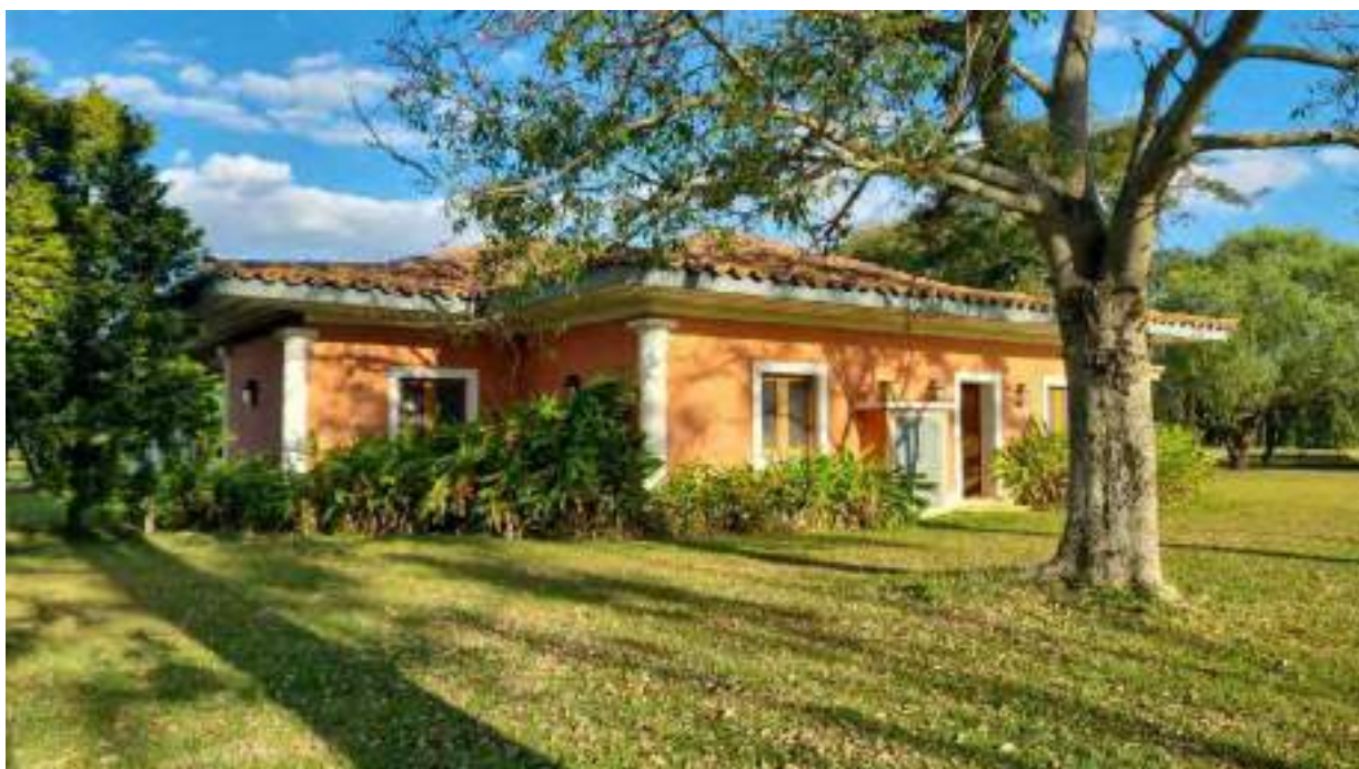
Foto 352 - Vista da fachada dos fundos do salão de jogos
