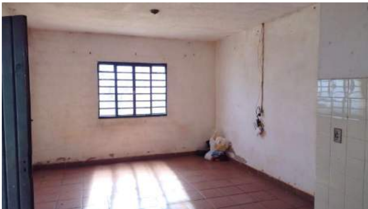
Foto 29 - Vista da sala de estar da casa de caseiro
