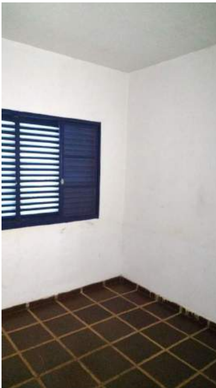
Foto 140 - Vista do dormitório 3 da casa 2 da colônia de cima
