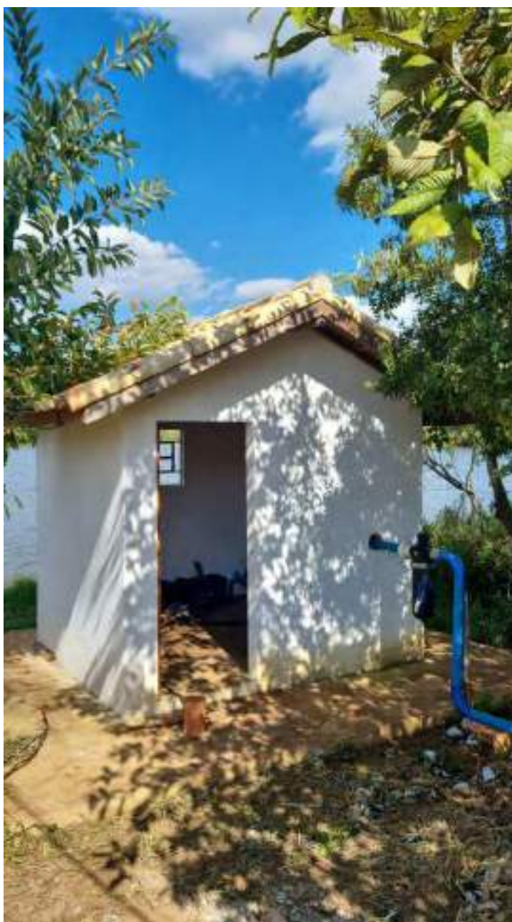
Foto 291 - Vista da casa de bomba e recalque
