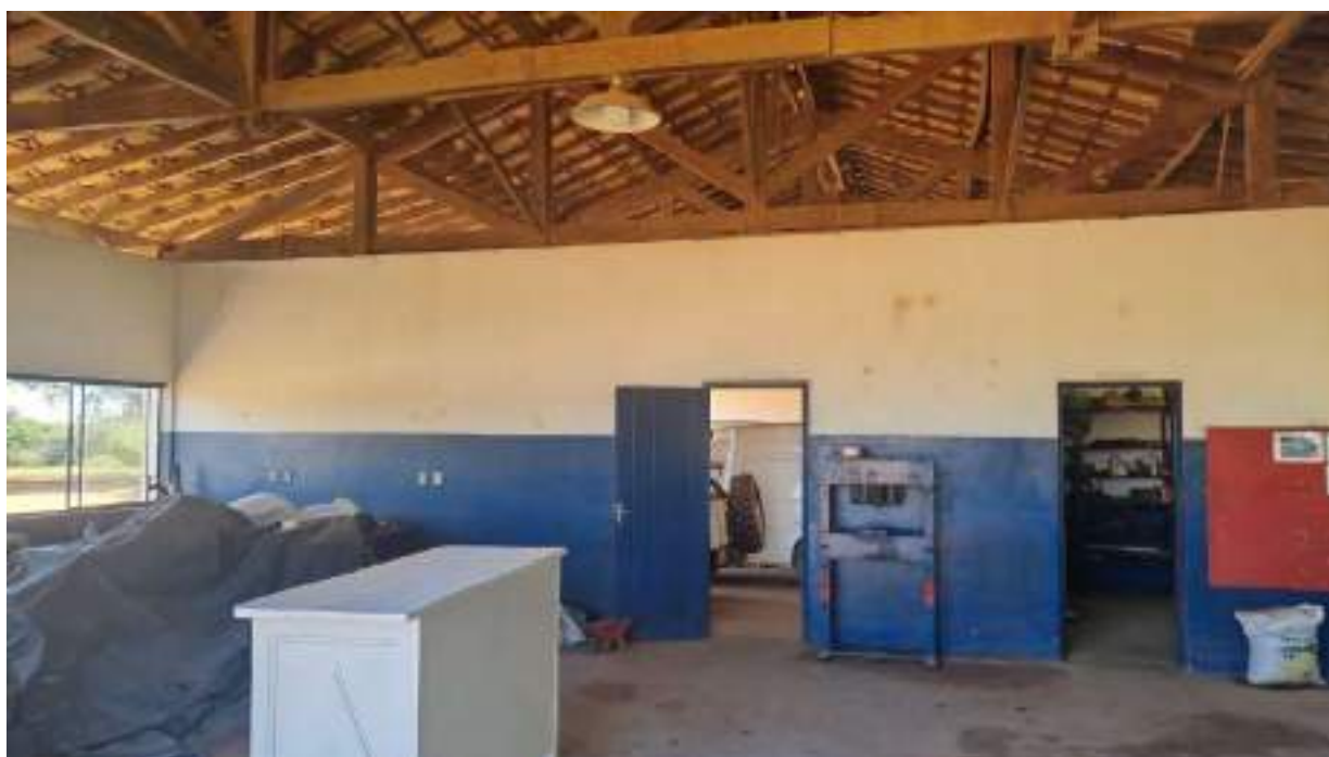
Foto 225 - Vista interna do prédio 1
