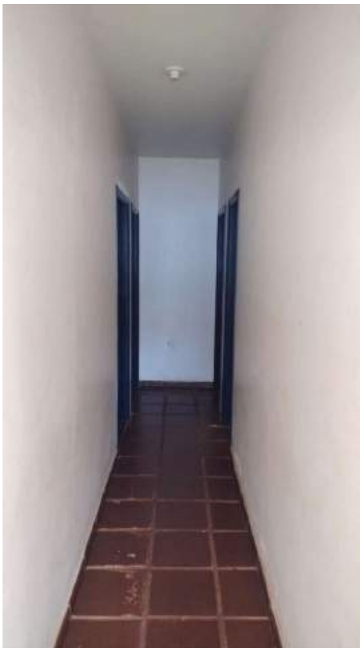
Foto 137 - Vista do corredor de distribuição dos dormitórios da casa 2 da colônia de cima
