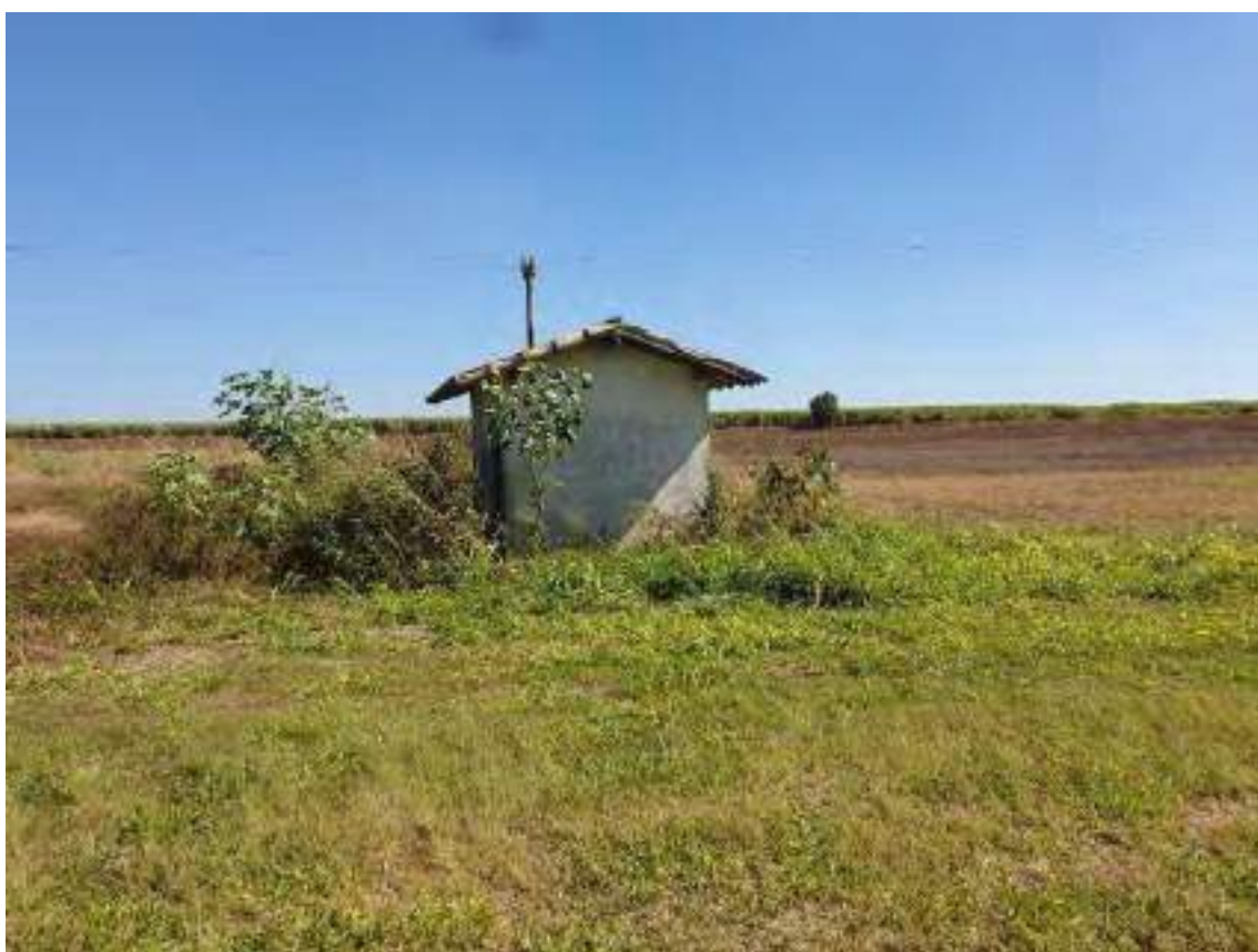
Foto 36 – Vista da casa de bombas
