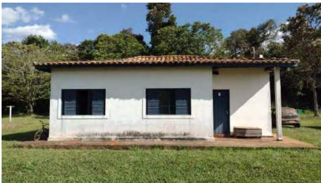
Foto 170 - Vista da fachada da casa 6 da colônia de cima
