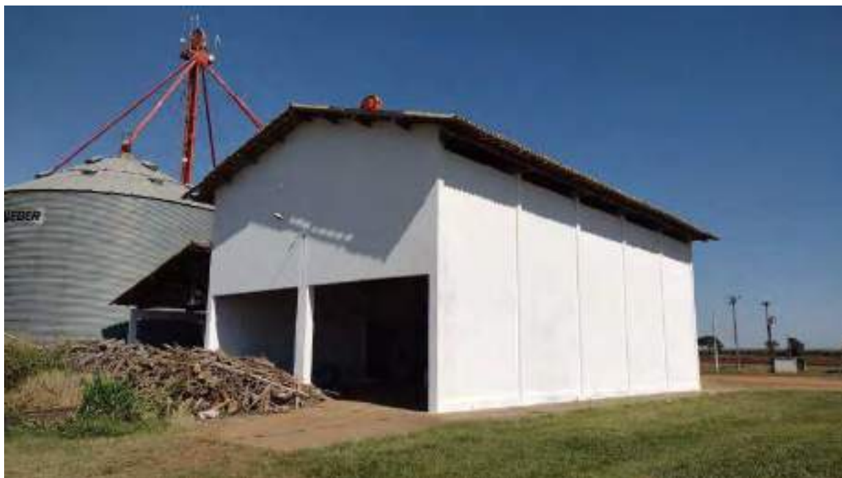
Foto 56 – Outra vista da fachada do galpão 4 junto ao silos
