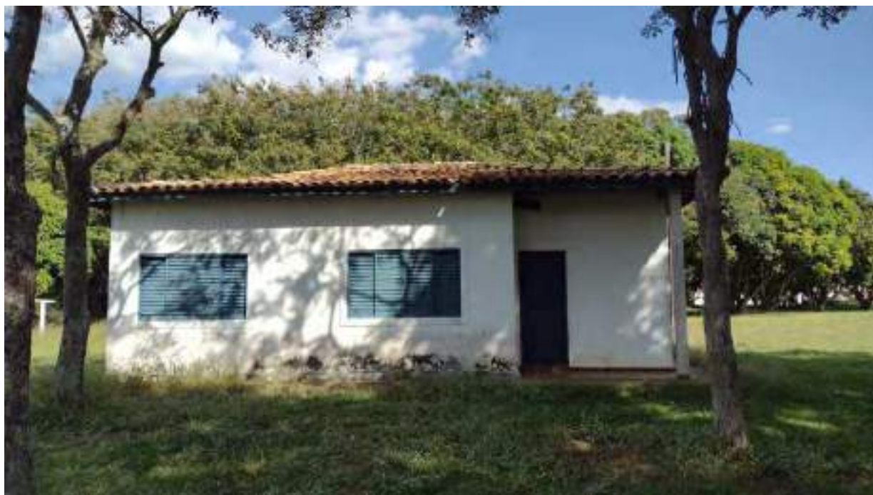
Foto 122 - Vista da fachada da casa 1 da colônia de cima
