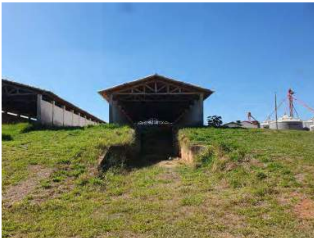
Foto 71 - Vista da fachada do galpão 3 em frente aos silos
