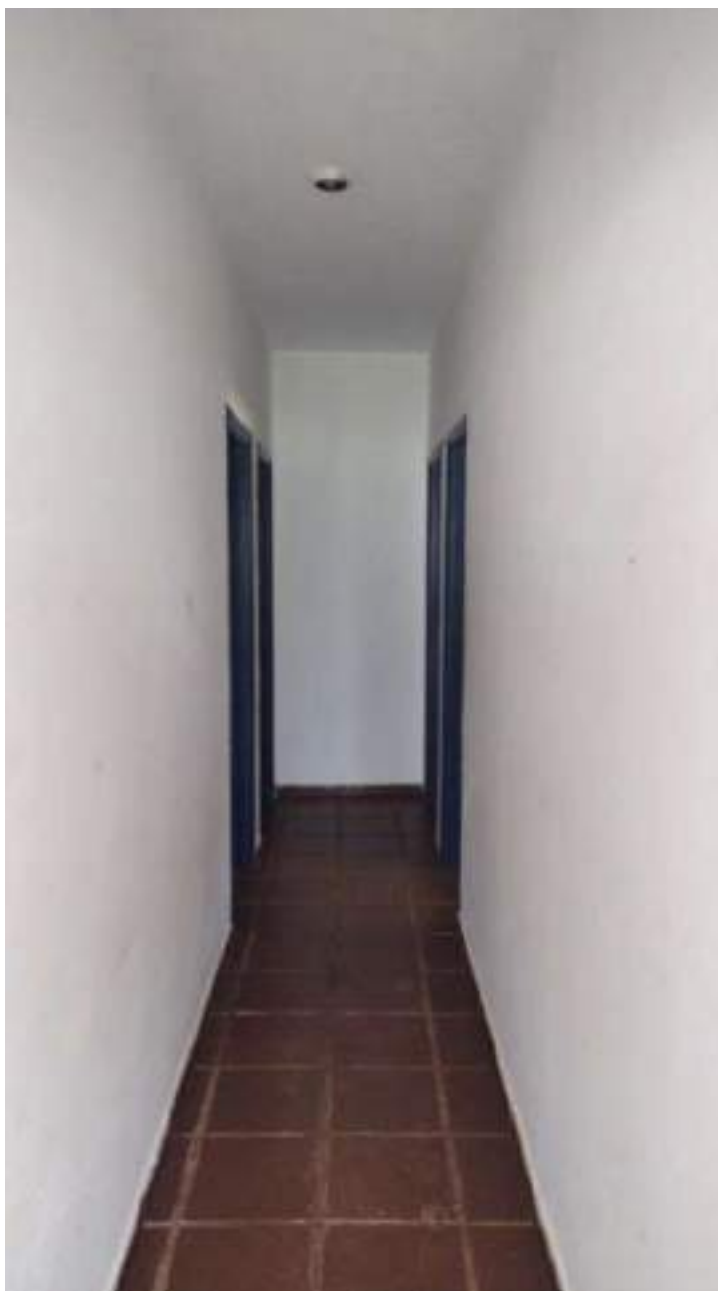
Foto 128 - Vista do corredor de distribuição dos dormitórios da casa 1 da colônia de cima
