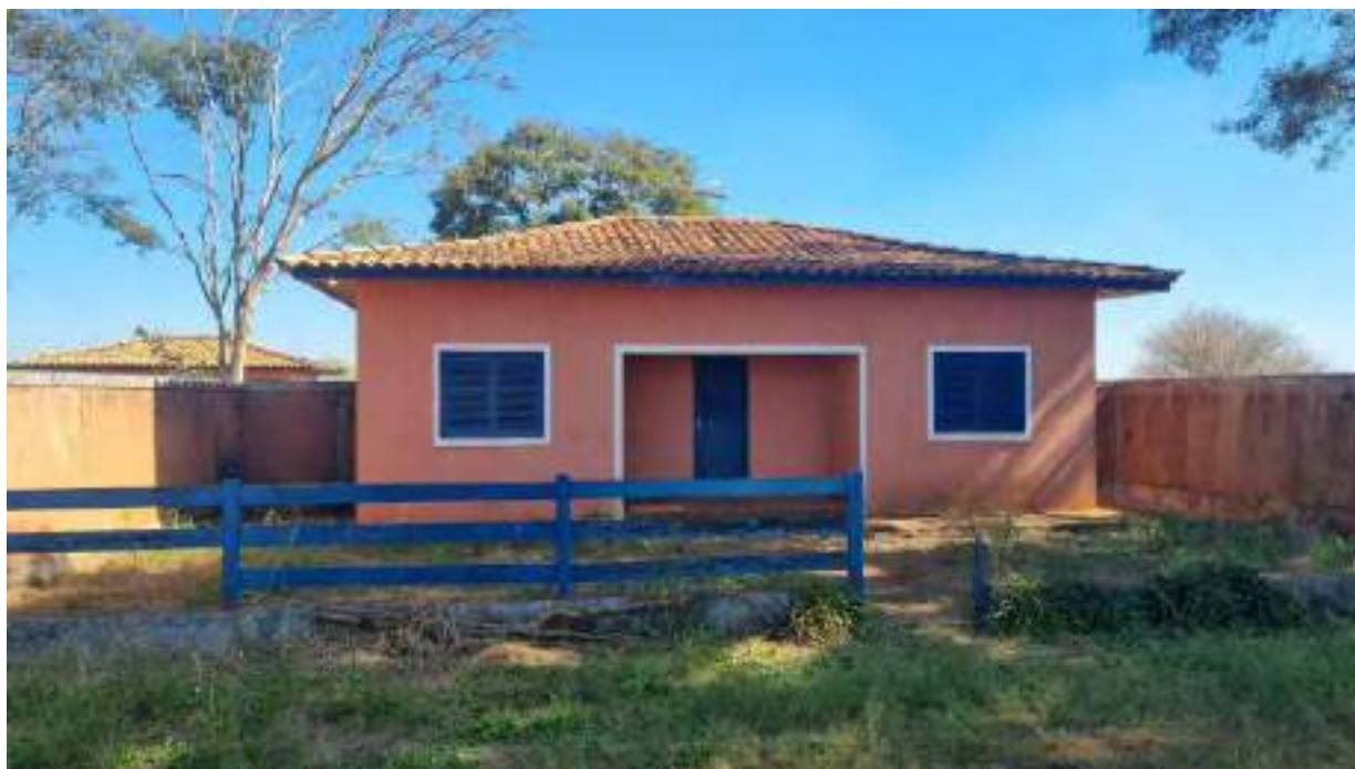
Foto 274 - Vista da fachada da casa frontal
