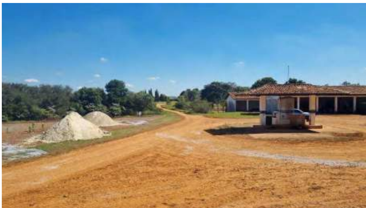
Foto 261 - Vista geral da circulação interna
