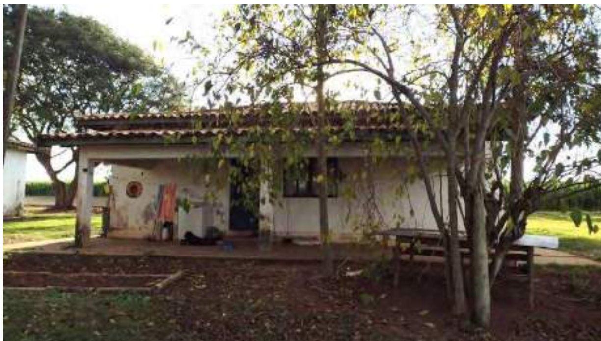
Foto 95 - Vista da fachada dos fundos da casa 6 da colônia de baixo
