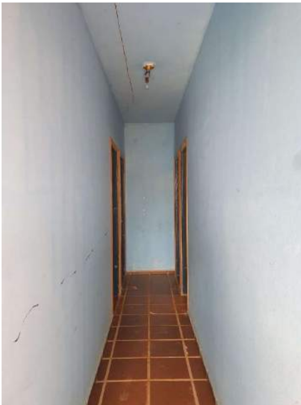
Foto 196 - Vista do corredor de distribuição dos dormitórios da casa 9 da colônia de cima
