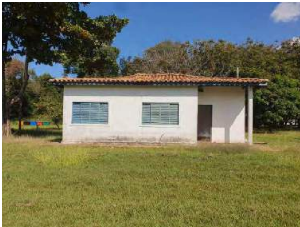
Foto 141 - Vista da fachada da casa 3 da colônia de cima
