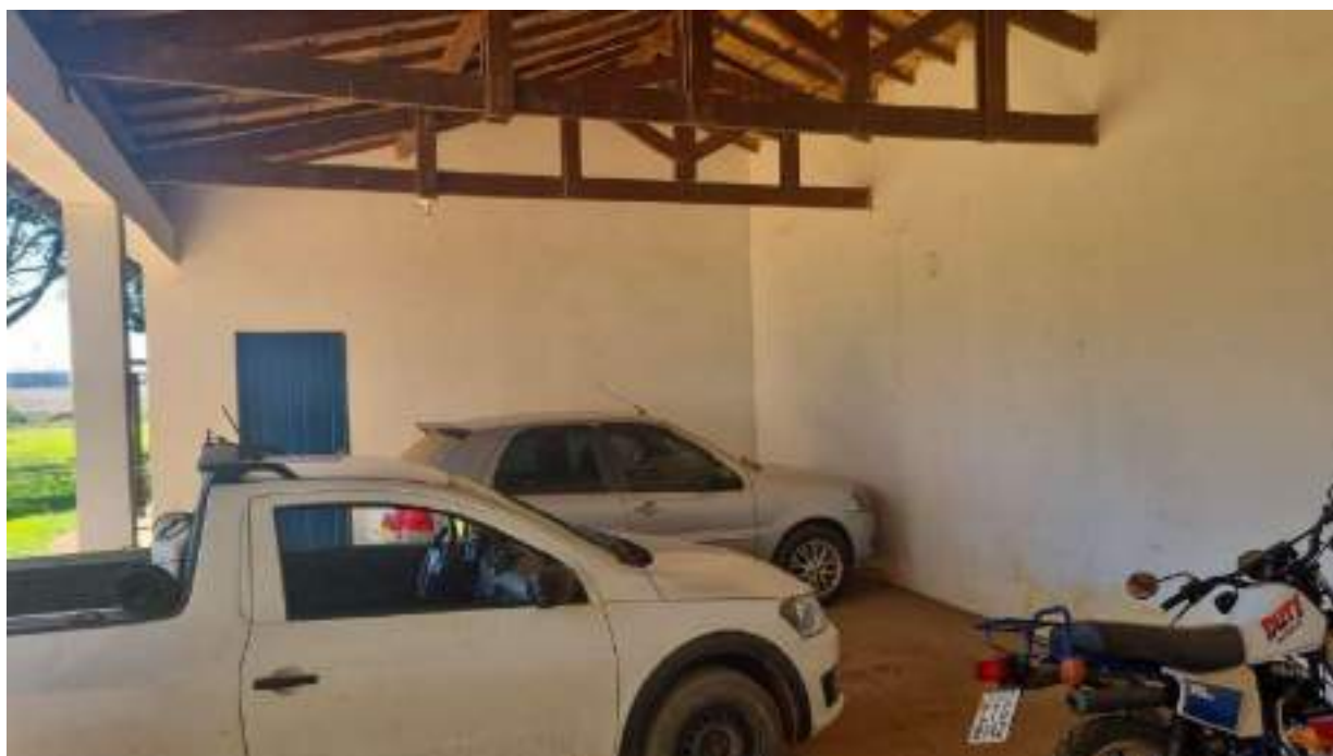
Foto 237 - Vista da garagem do prédio 5, administrativo
