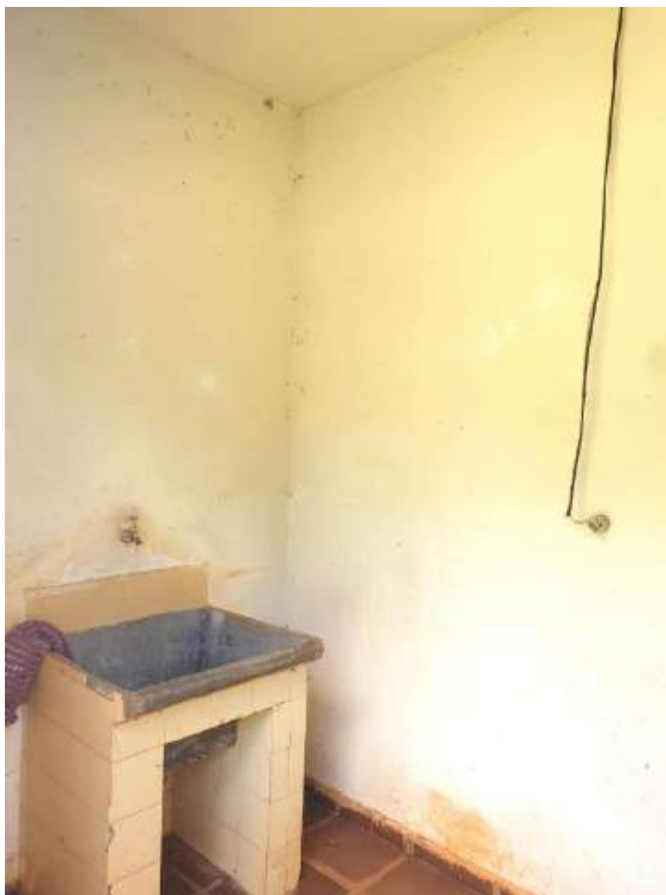
Foto 186 - Vista da área de serviço da casa 8 da colônia de cima
