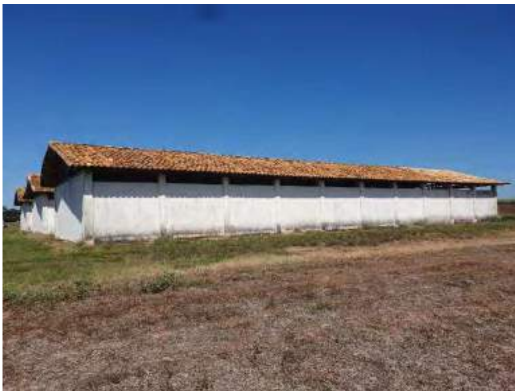
Foto 65 – Vista da fachada lateral do galpão 1 em frente aos silos
