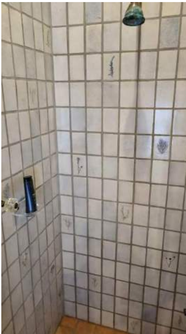
Foto 339 - Vista da ducha do vestiário masculino da área gourmet
