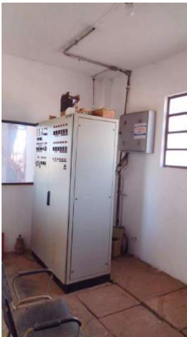
Foto 60 - Vista da área técnica do galpão 4 junto ao silos
