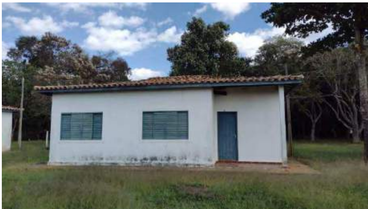
Foto 150 - Vista da fachada da casa 4 da colônia de cima
