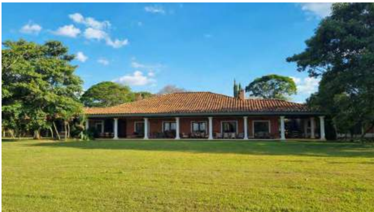
Foto 333 - Vista geral externa da fachada da casa sede
