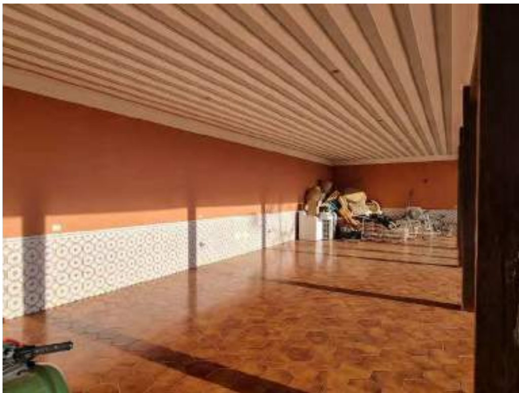
Foto 373 - Vista da garagem da casa de hospedes
