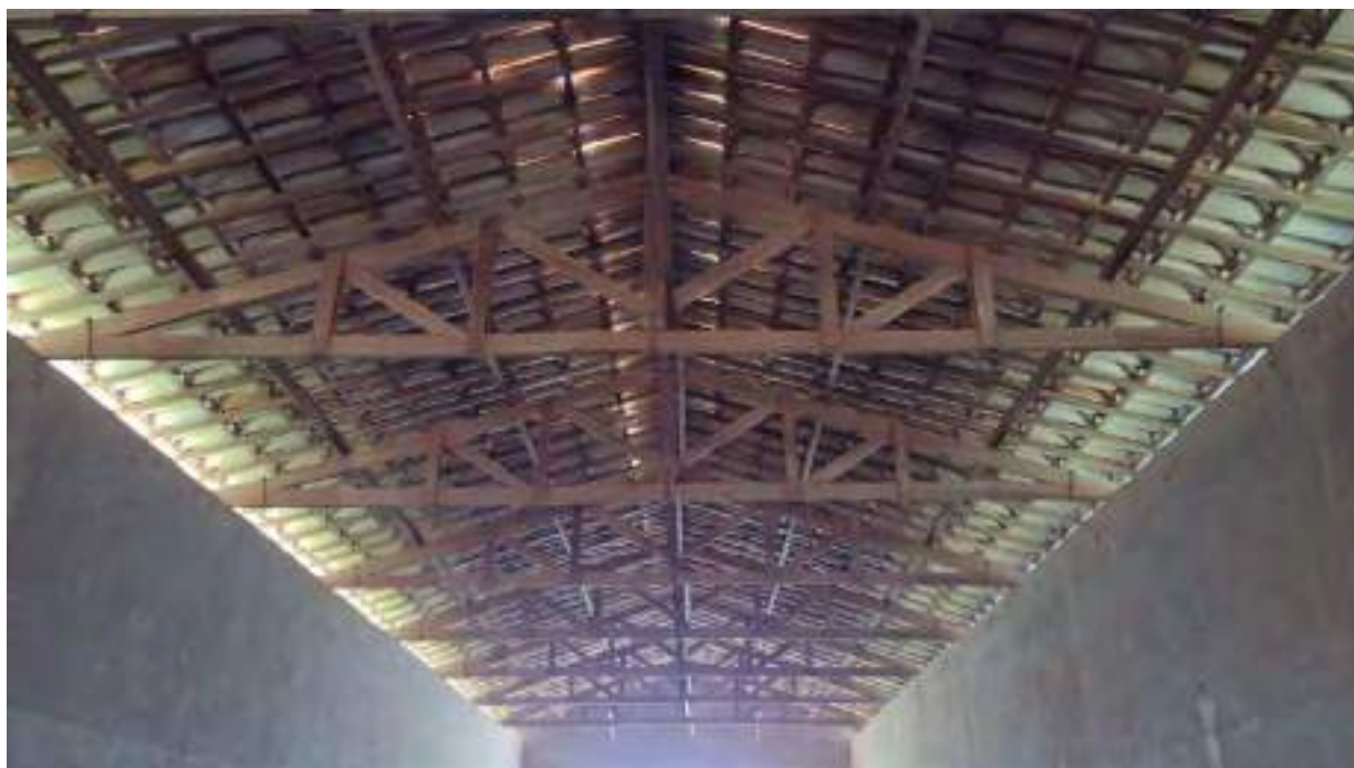
Foto 42 - Vista da cobertura do galpão 1
