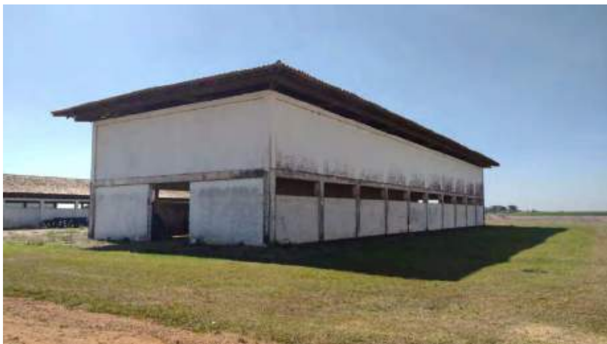
Foto 51 – Outra vista a fachada do galpão 3
