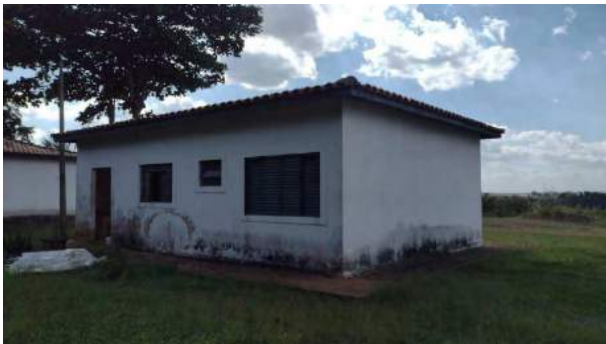
Foto 151 - Vista da fachada dos fundos da casa 4 da colônia de cima
