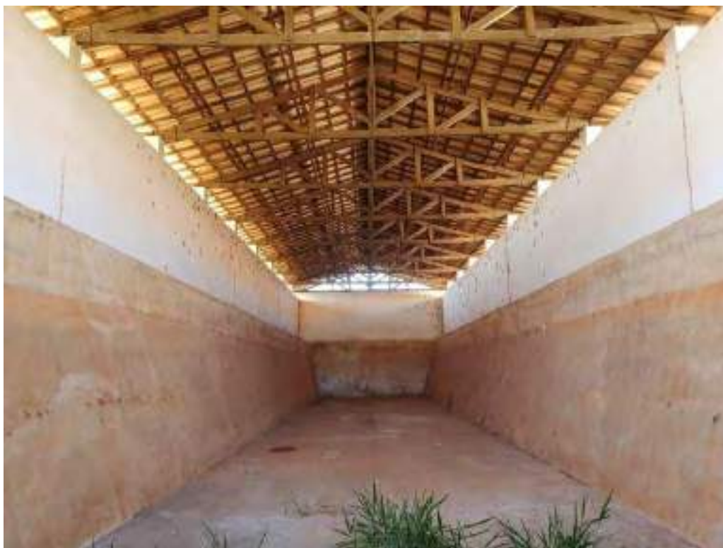
Foto 67 – Outra vista geral interna do galpão 1 em frente ao silos
