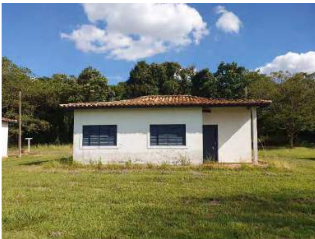
Foto 182 - Vista da fachada da casa 8 da colônia de cima
