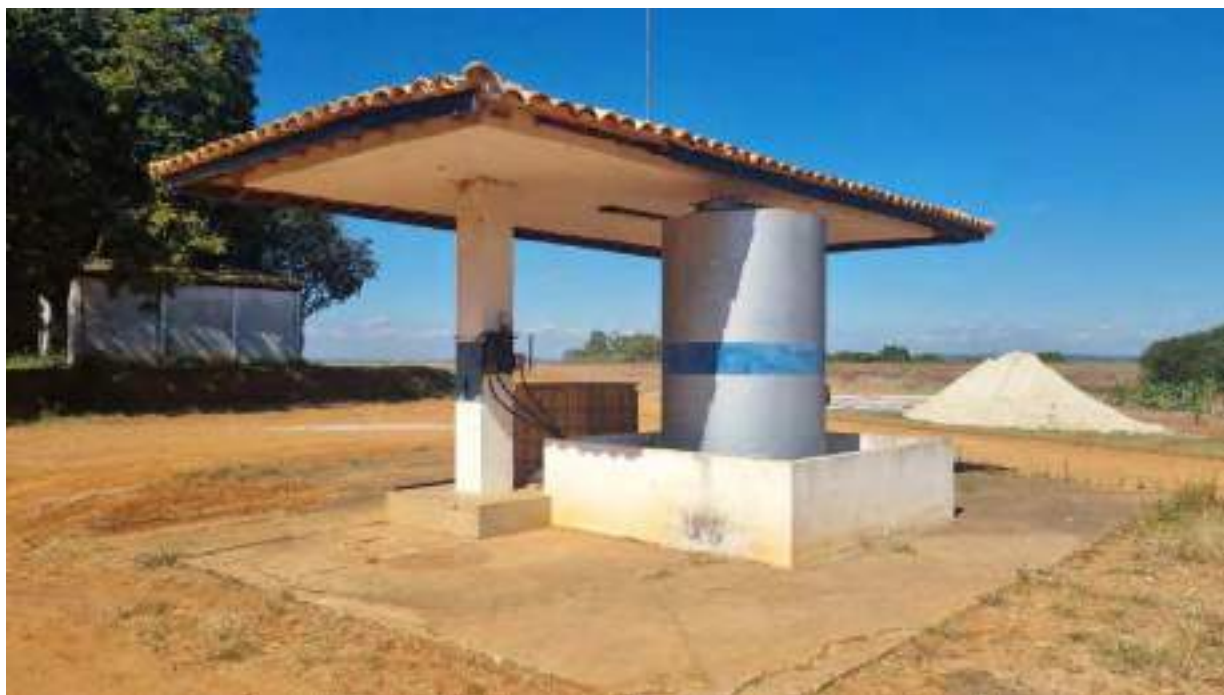
Foto 256 - Vista do posto de abastecimento
