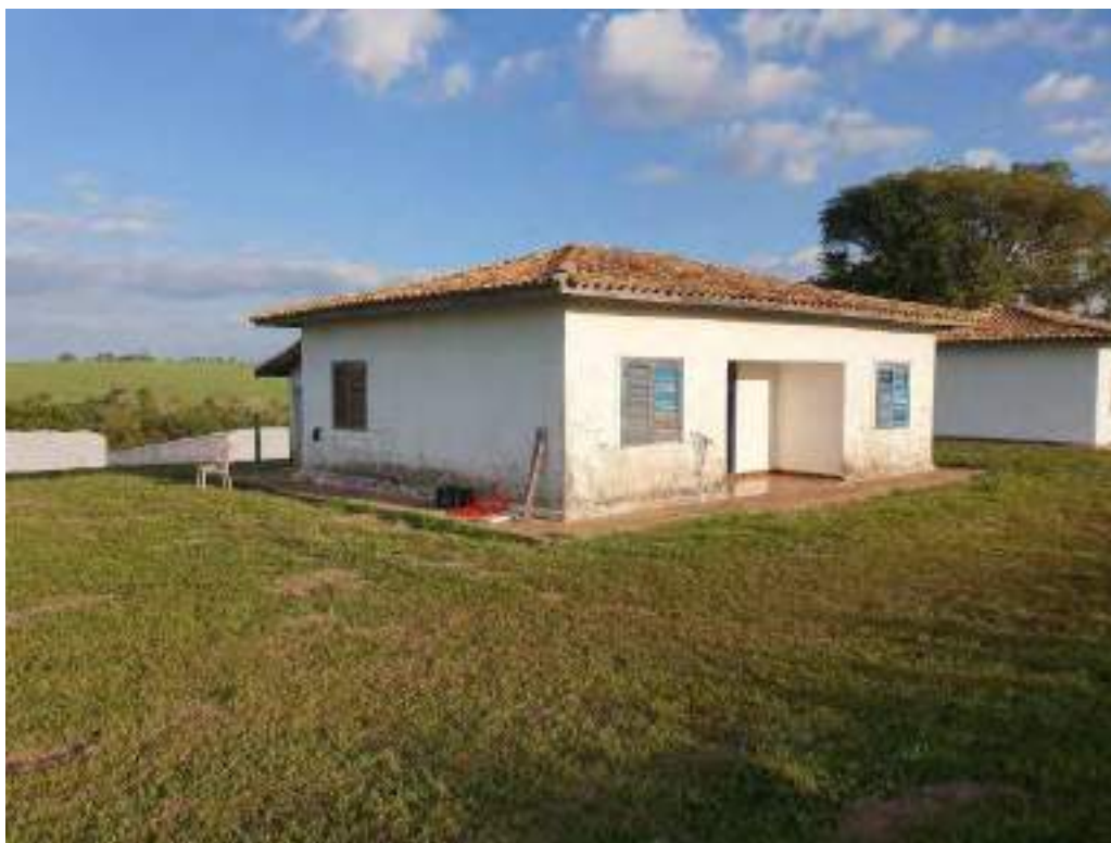
Foto 106 - Vista da fachada da casa 9 da colônia de baixo
