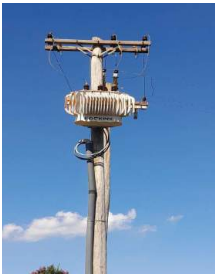
51 - Transformador Trifásico
