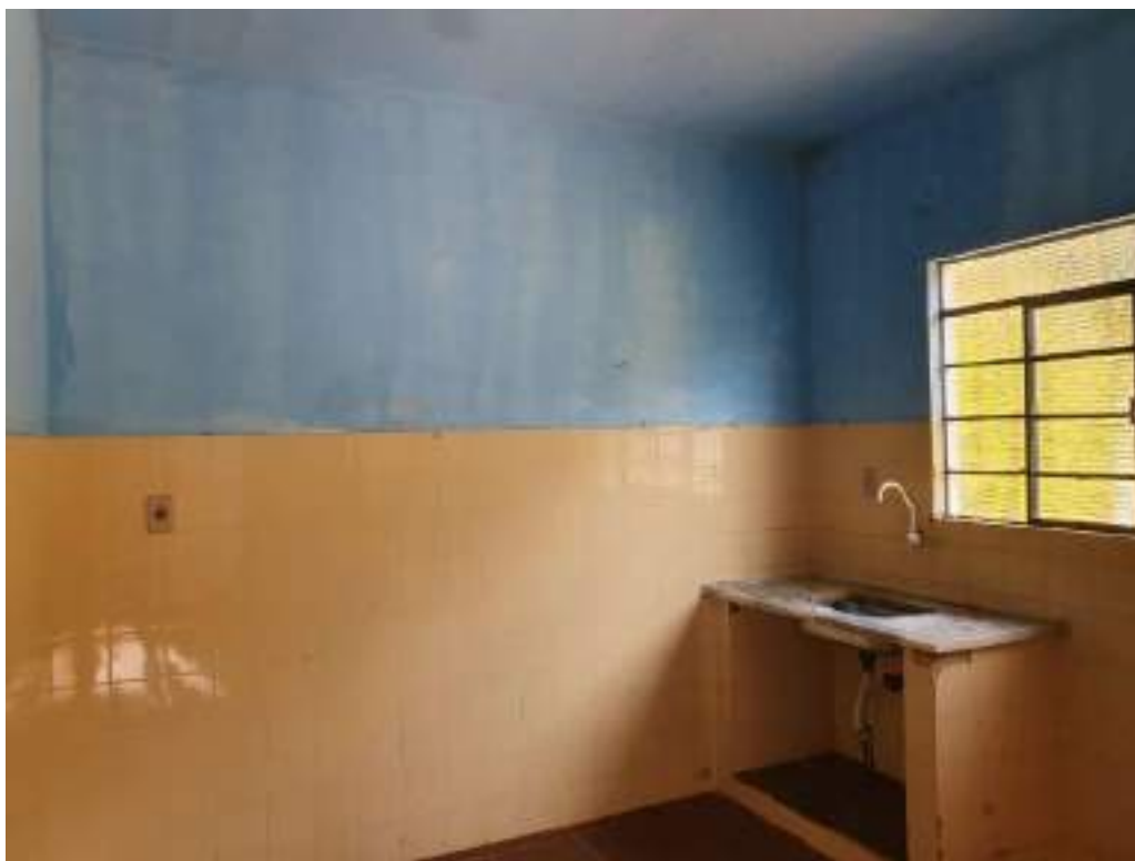
Foto 193 - Vista da cozinha da casa 9 da colônia de cima
