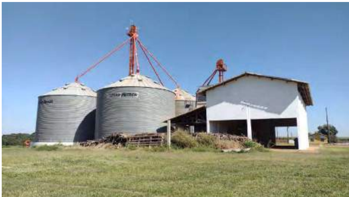
Foto 55 - Vista da fachada do galpão 4 junto aos silos
