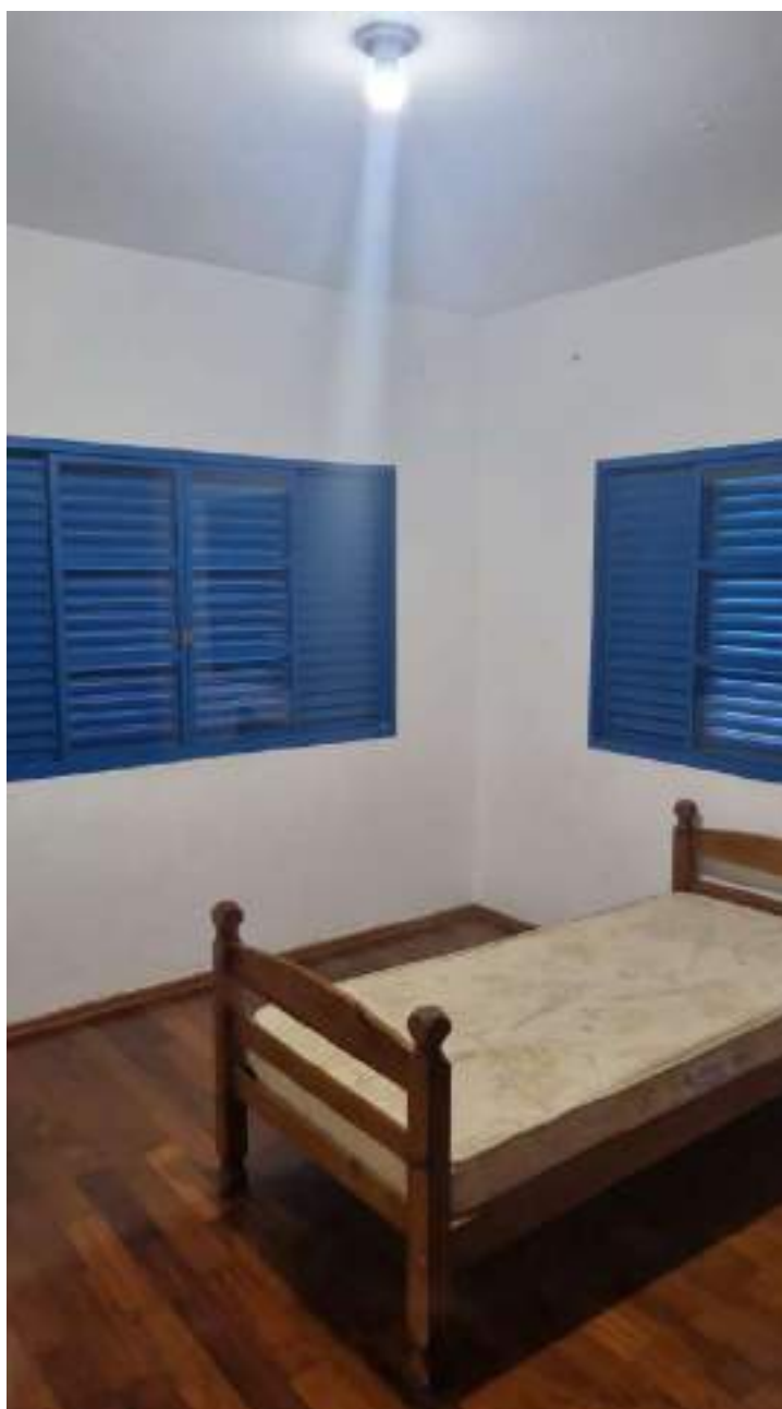
Foto 254 - Vista do dormitório 1 do prédio 6, casa do encarregado
