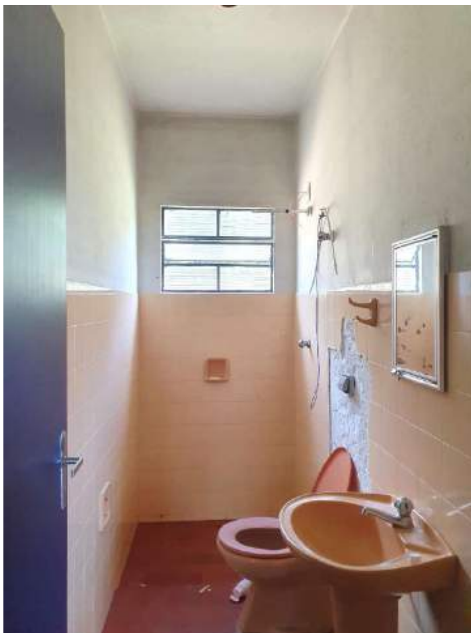
Foto 185 - Vista do banheiro da casa 8 da colônia de cima
