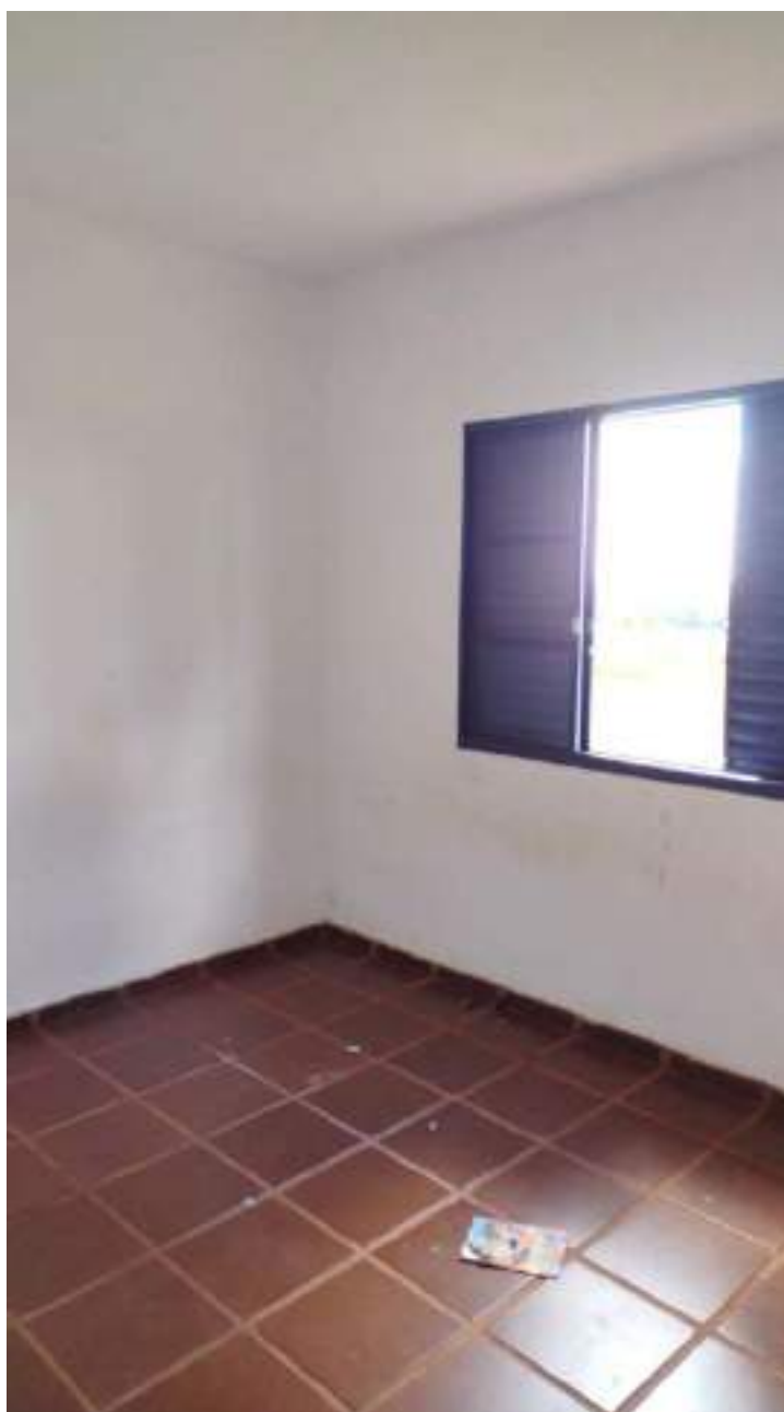
Foto 167 - Vista do dormitório 1 da casa 5 da colônia de cima
