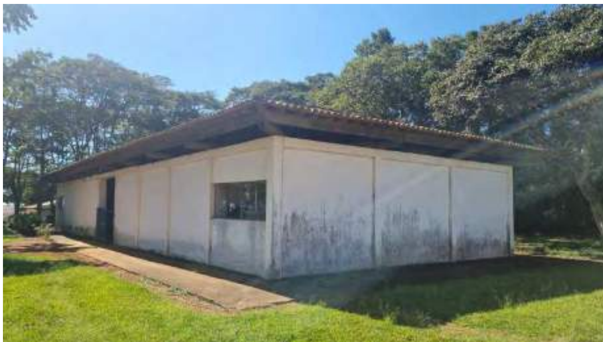
Foto 227 - Vista da fachada do prédio 2
