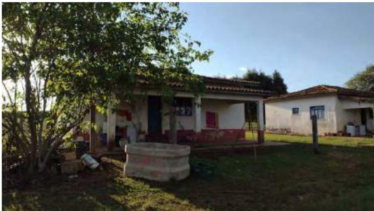
Foto 87 - Vista da fachada dos fundos da casa 2 da colônia de baixo
