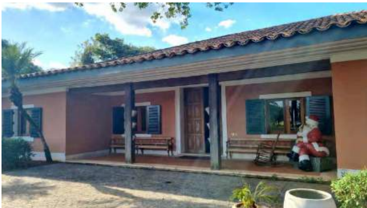
Foto 293 - Vista da fachada da casa sede
