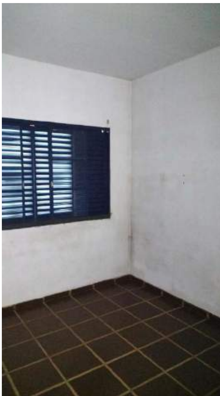
Foto 158 - Vista do dormitório 2 da casa 4 da colônia de cima
