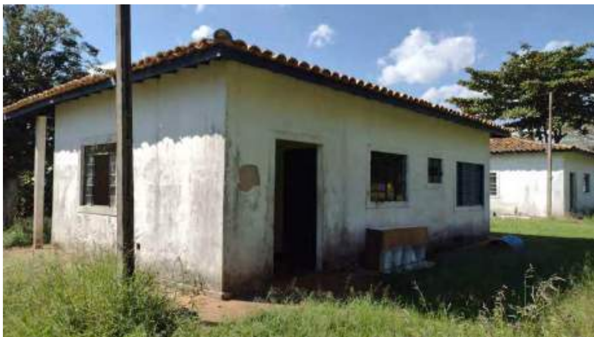
Foto 132 - Vista da fachada dos fundos da casa 2 da colônia de cima
