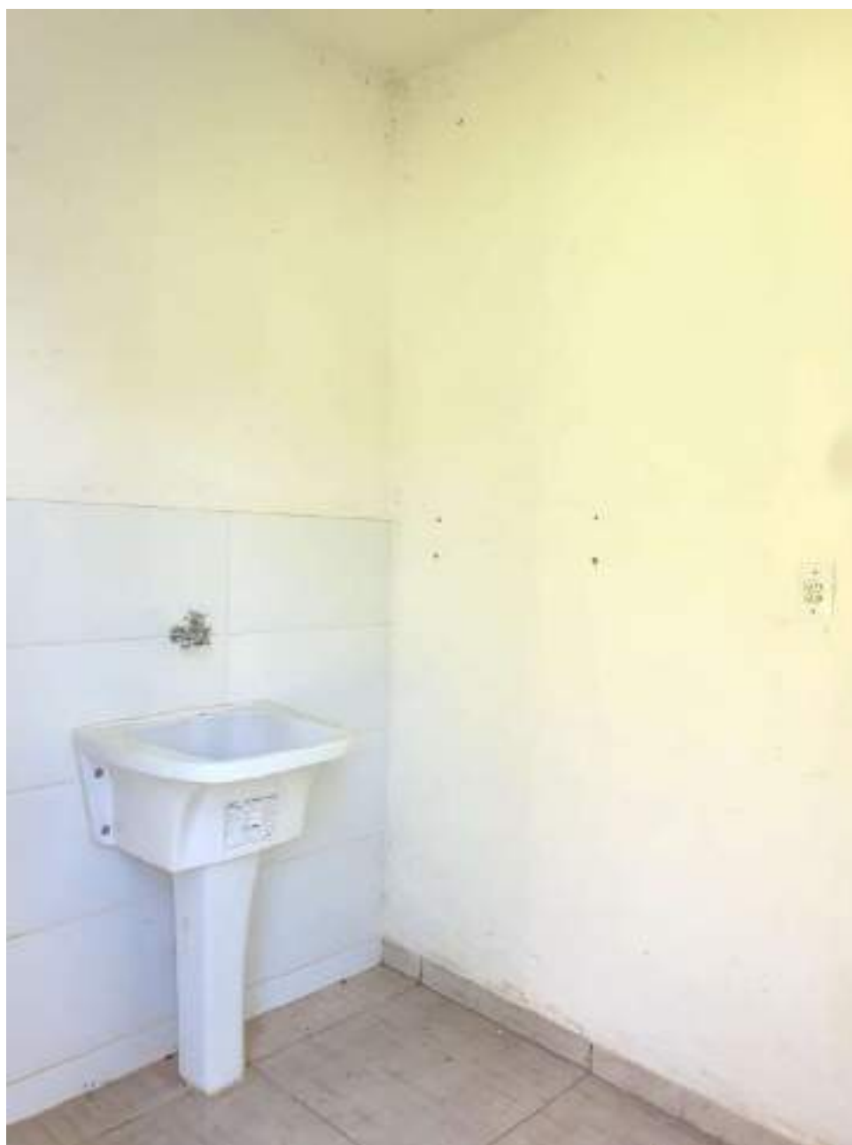
Foto 145 - Vista da área de serviço da casa 3 da colônia de cima
