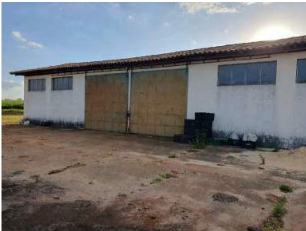
Foto 111 - Vista da fachada lateral do gapão junto a colônia de baixo
