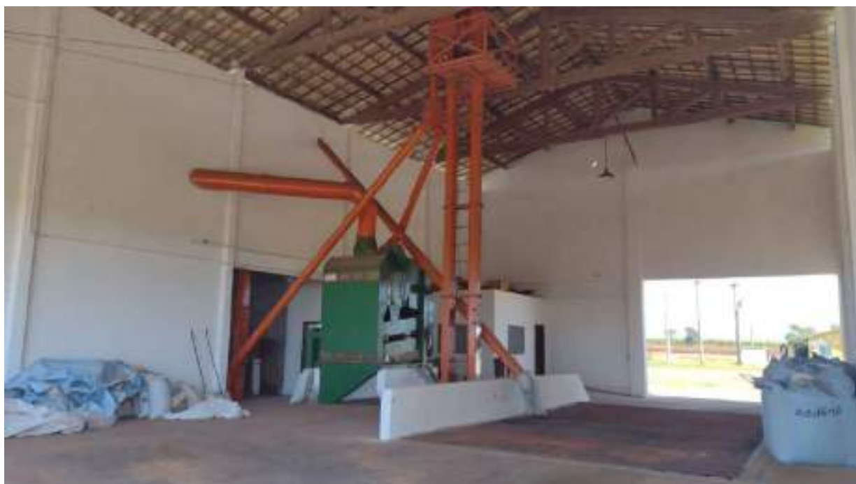
Foto 57 - Vista interna do galpão 4 junto ao silos
