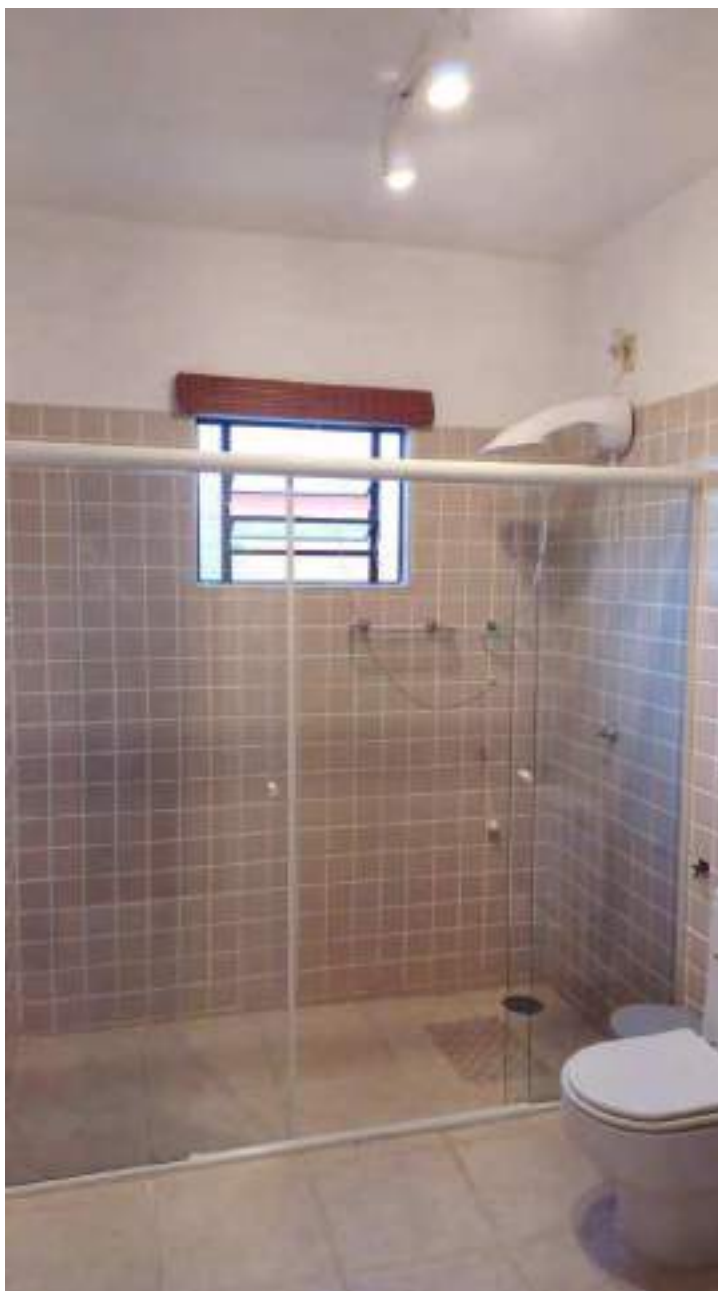
Foto 211 - Vista do banheiro da casa 4 da colônia de visitas
