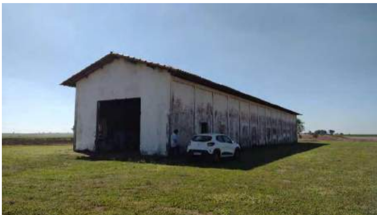
Foto 38 - Vista a fachada do galpão 1
