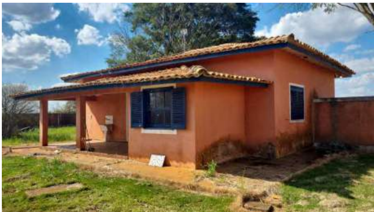
Foto 275 - Vista da fachada dos fundos da casa frontal
