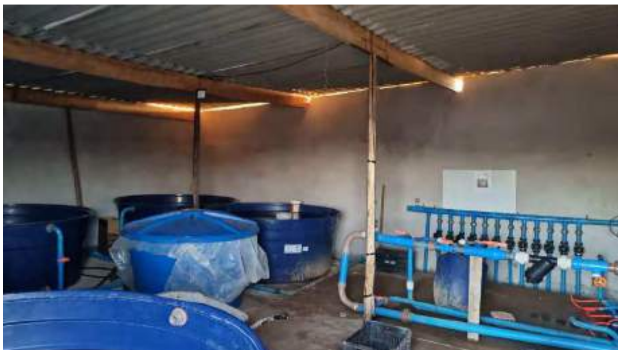
Foto 121 - Vista interna do galpão novo, abrigo de caixas d'água
