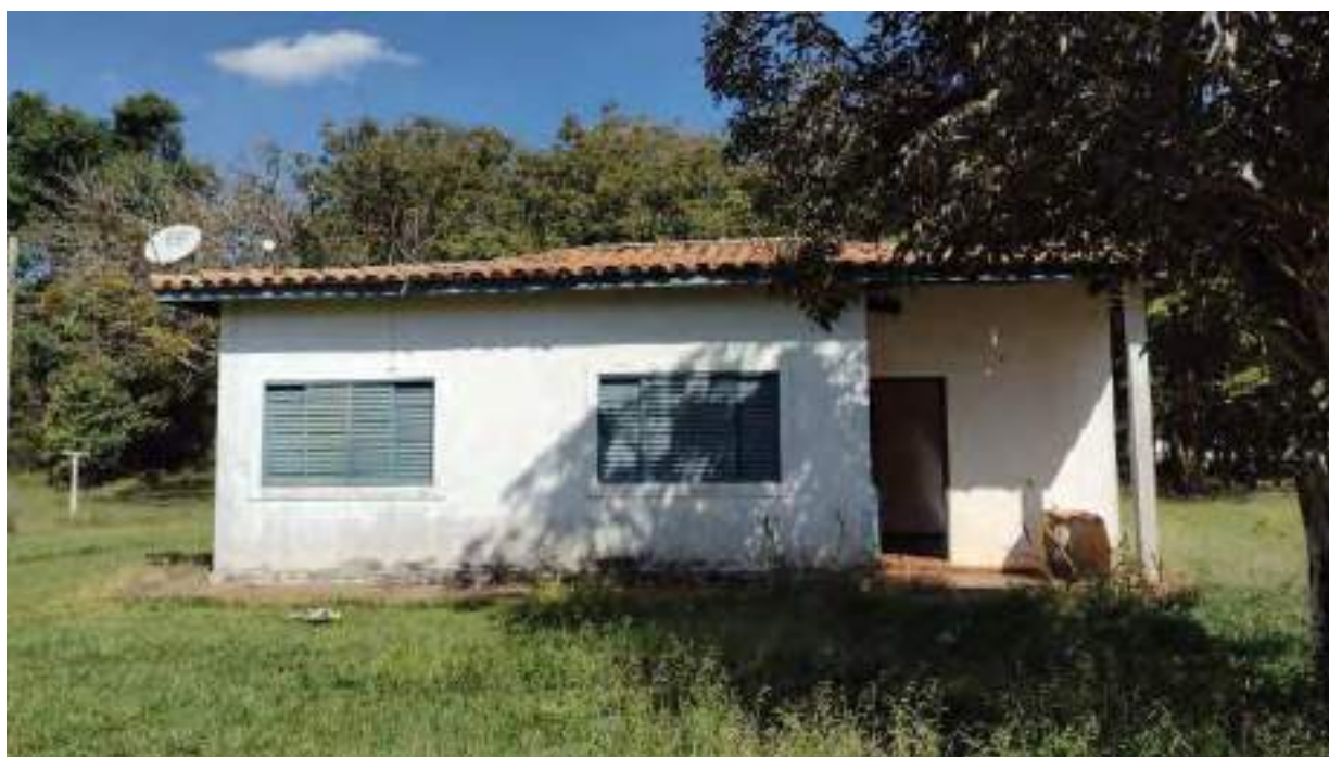
Foto 131 - Vista da fachada da casa 2 da colônia de cima
