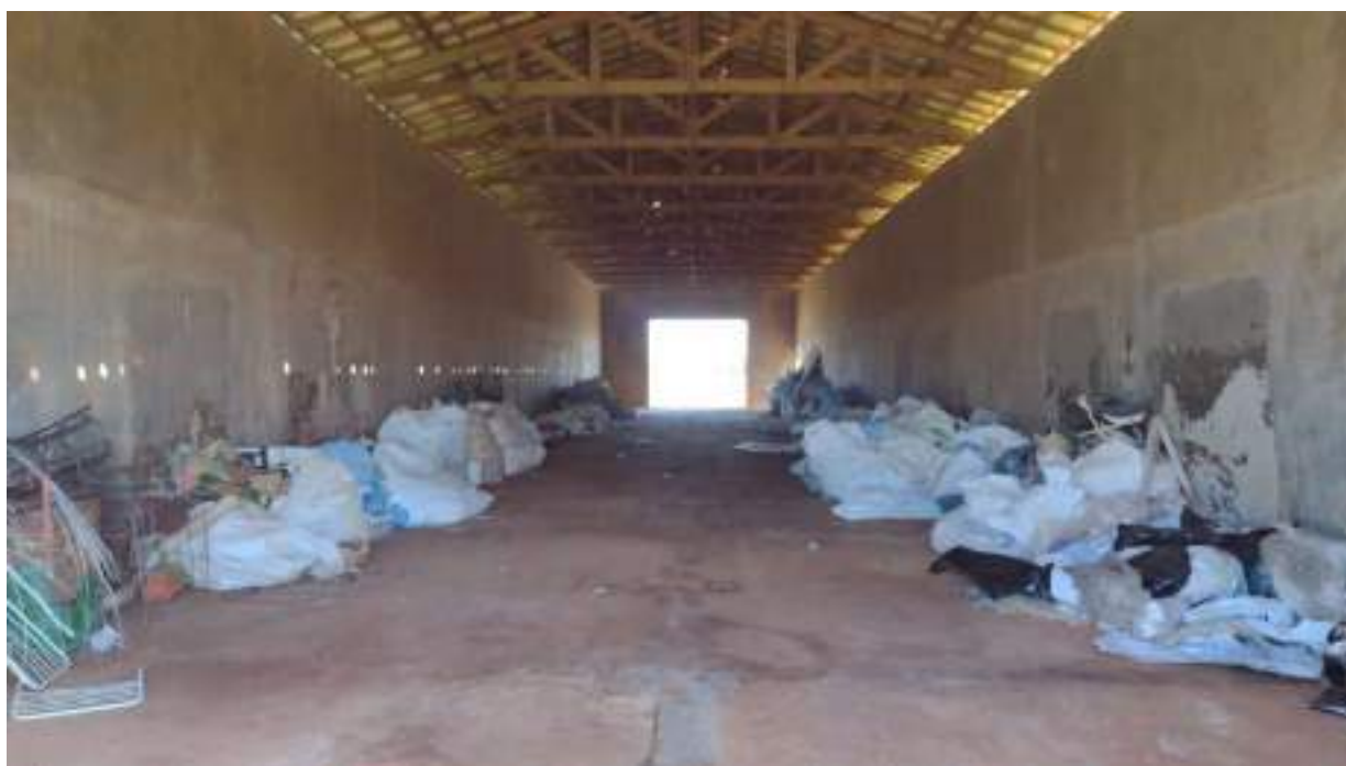
Foto 40 – Vista geral interna do galpão 1
