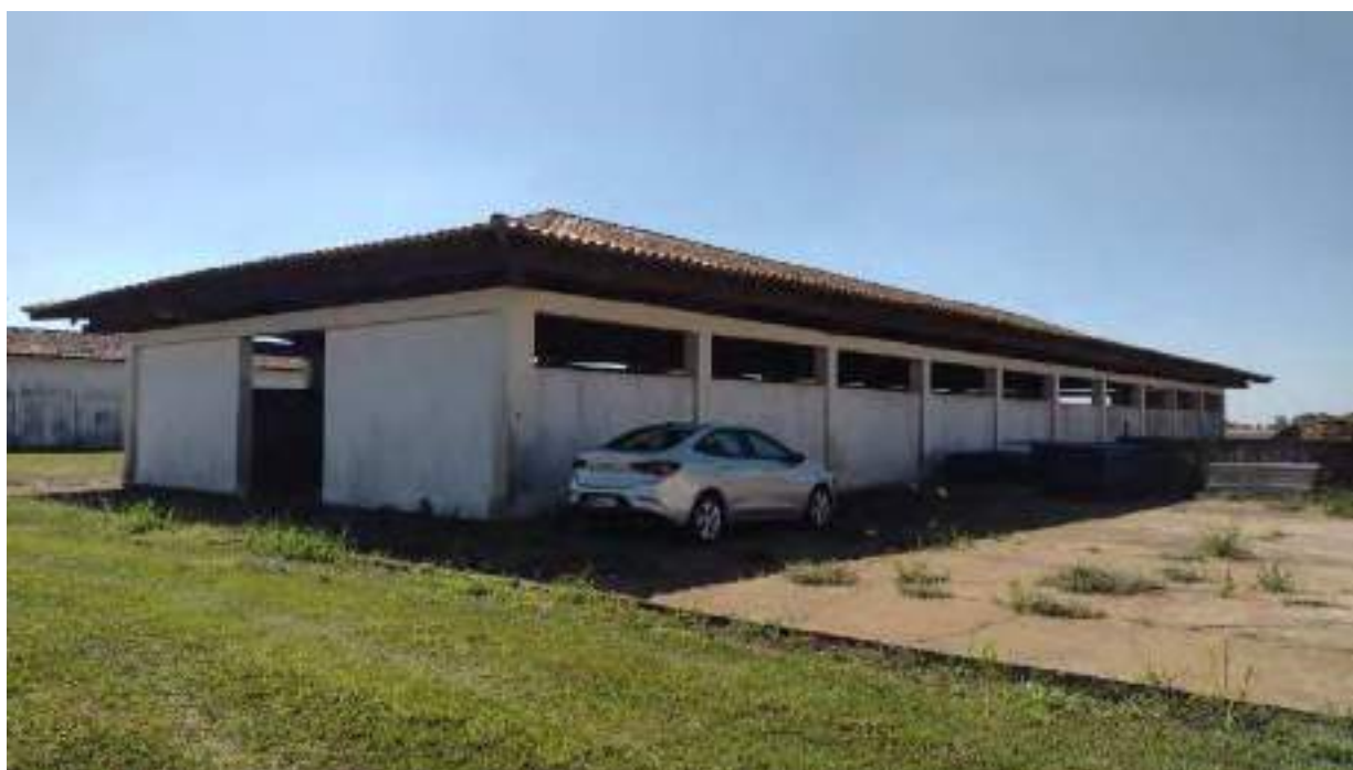
Foto 44 – Outra vista a fachada do galpão 2
