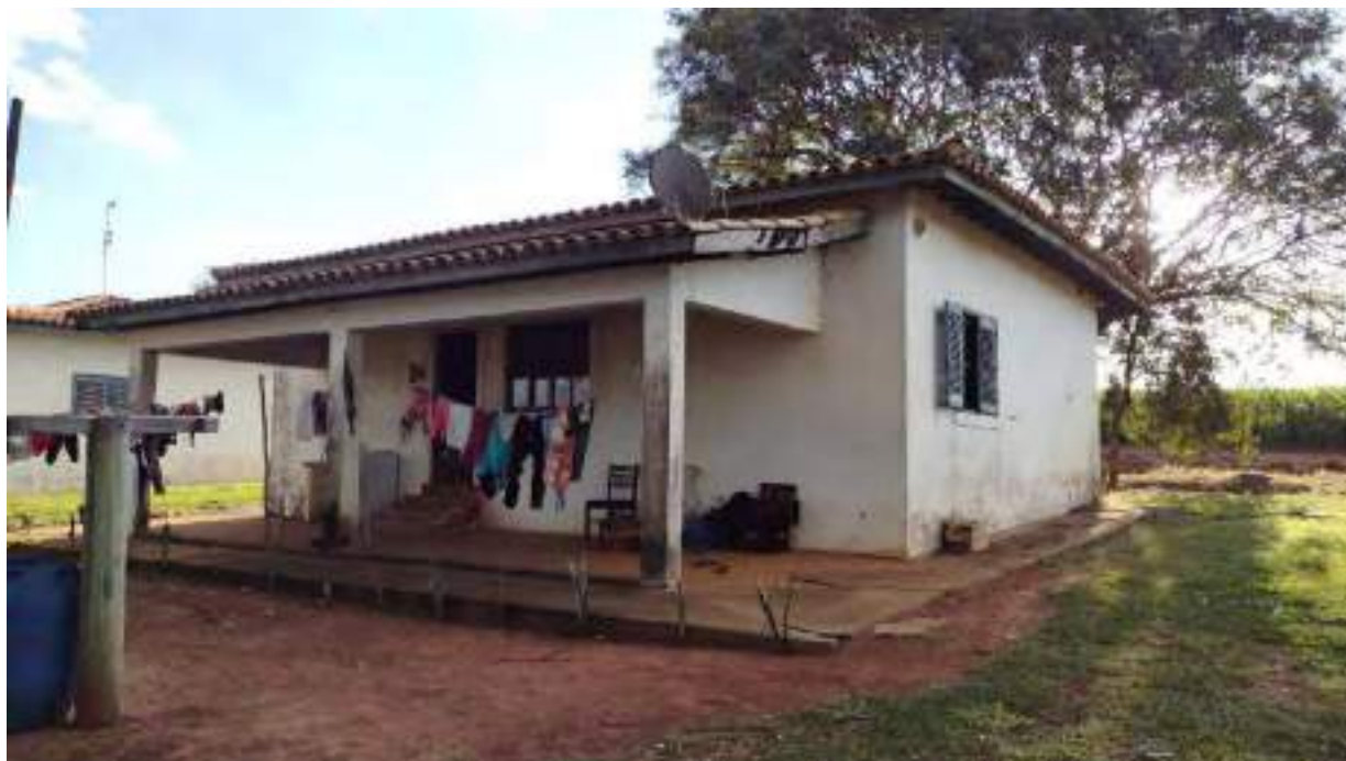
Foto 93 - Vista da fachada dos fundos da casa 5 da colônia de baixo
