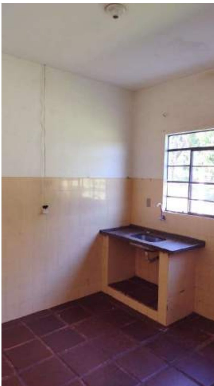
Foto 134 - Vista da cozinha da casa 2 da colônia de cima
