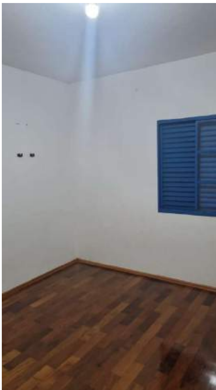
Foto 250 - Vista do dormitório 3 do prédio 6, casa do encarregado
