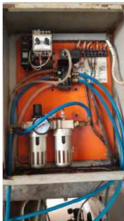
11 e 12 – Paineis de Controle eletropneumático
