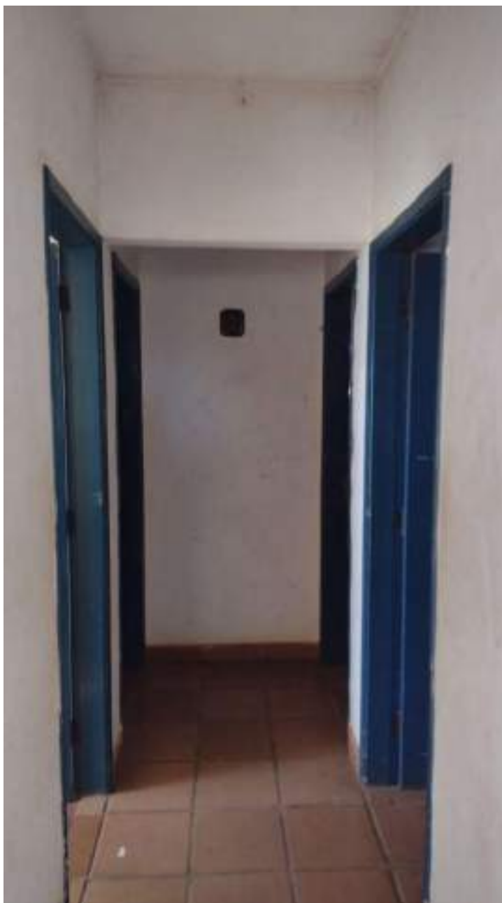
Foto 30 - Vista do corredor de distribuição dos dormitórios e banheiro
