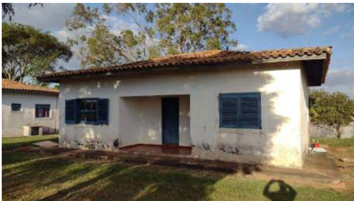
Foto 88 - Vista da fachada da casa 3 da colônia de baixo
