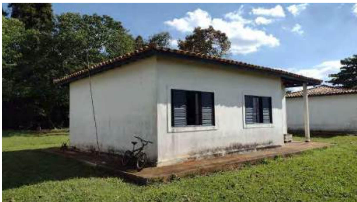
Foto 171 - Vista da fachada dos fundos da casa 6 da colônia de cima
