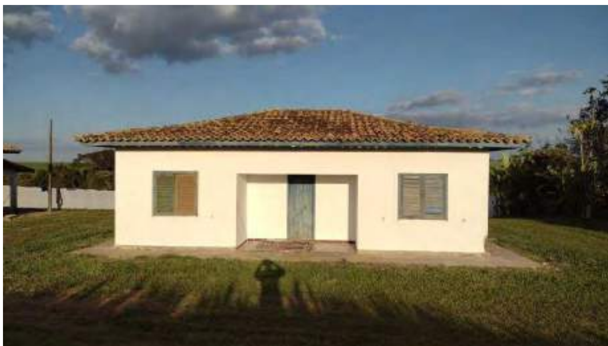
Foto 96 - Vista da fachada da casa 7 da colônia de baixo
