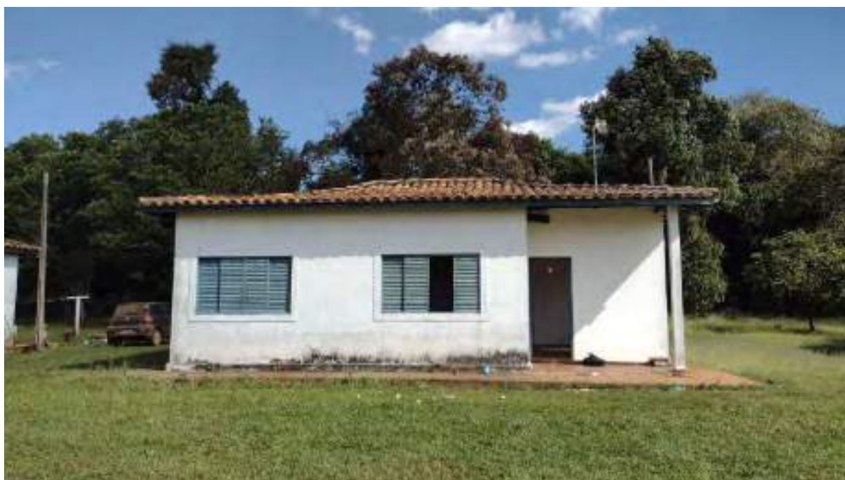
Foto 160 - Vista da fachada da casa 5 da colônia de cima
