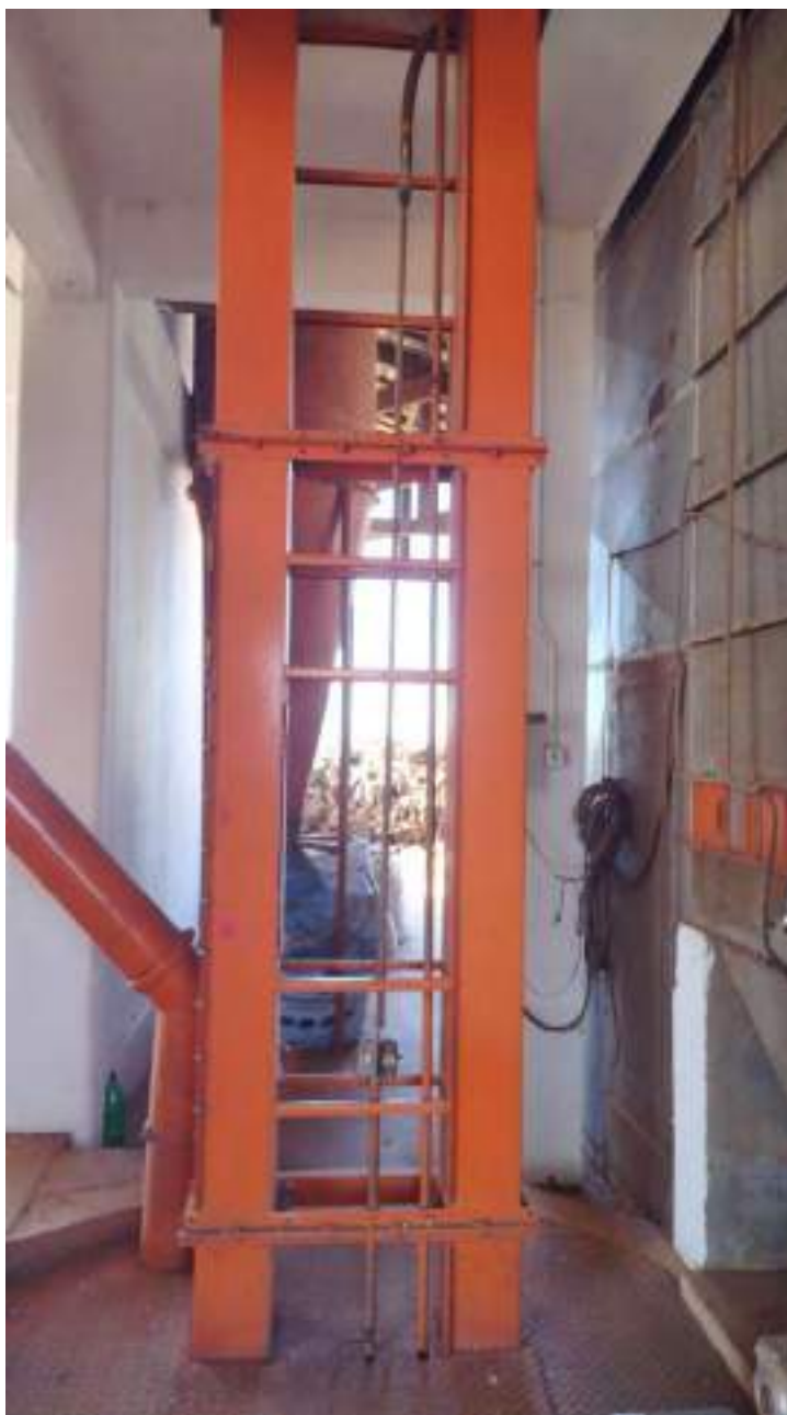
Foto 61 - Vista da área técnica do galpão 4 junto ao silos
