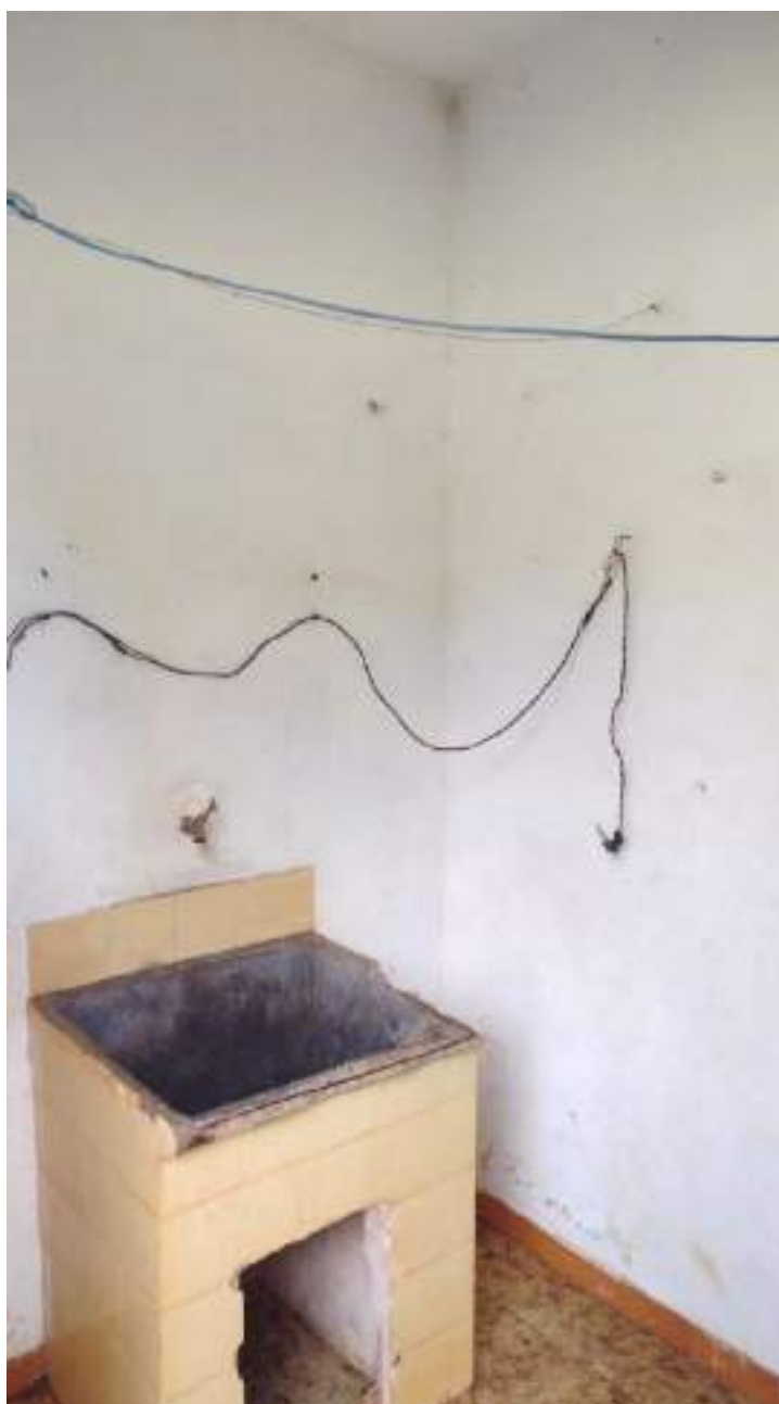
Foto 155 - Vista da área de serviço da casa 4 da colônia de cima
