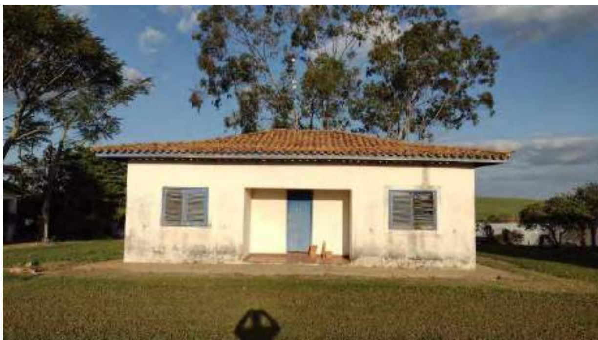
Foto 90 - Vista da fachada da casa 4 da colônia de baixo
