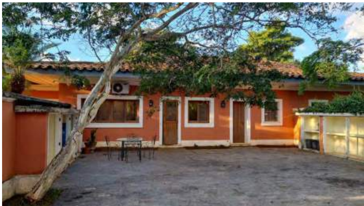
Foto 381 - Vista da fachada dos fundos da casa sede
