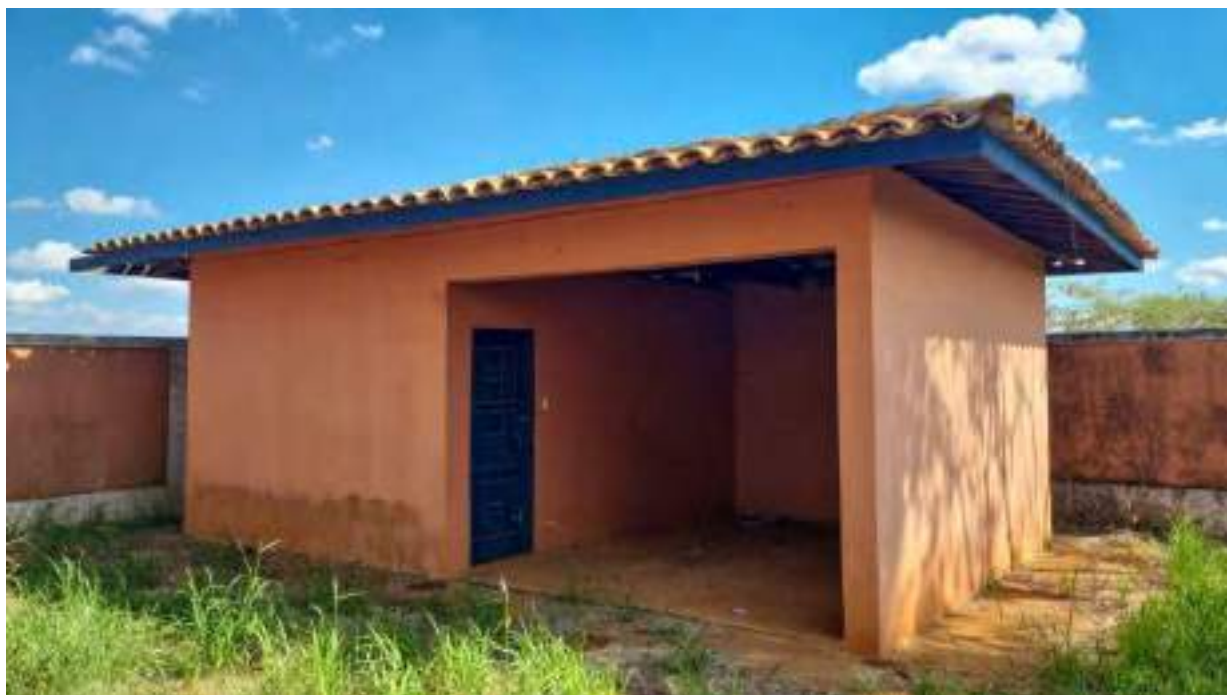
Foto 283 - Vista da fachada da edícula
