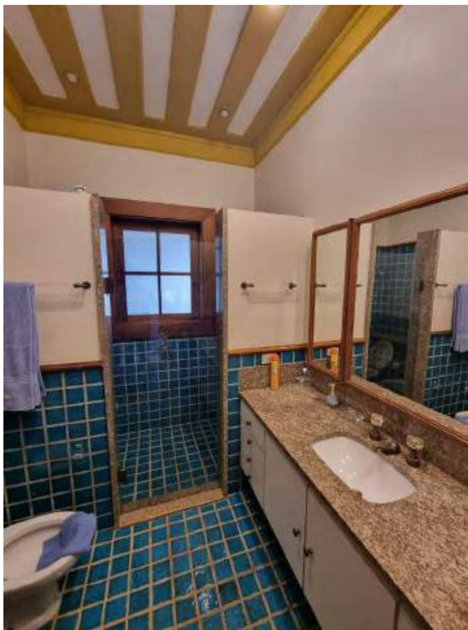
Foto 359 - Vista do banheiro da suíte 1 da casa de hospedes
