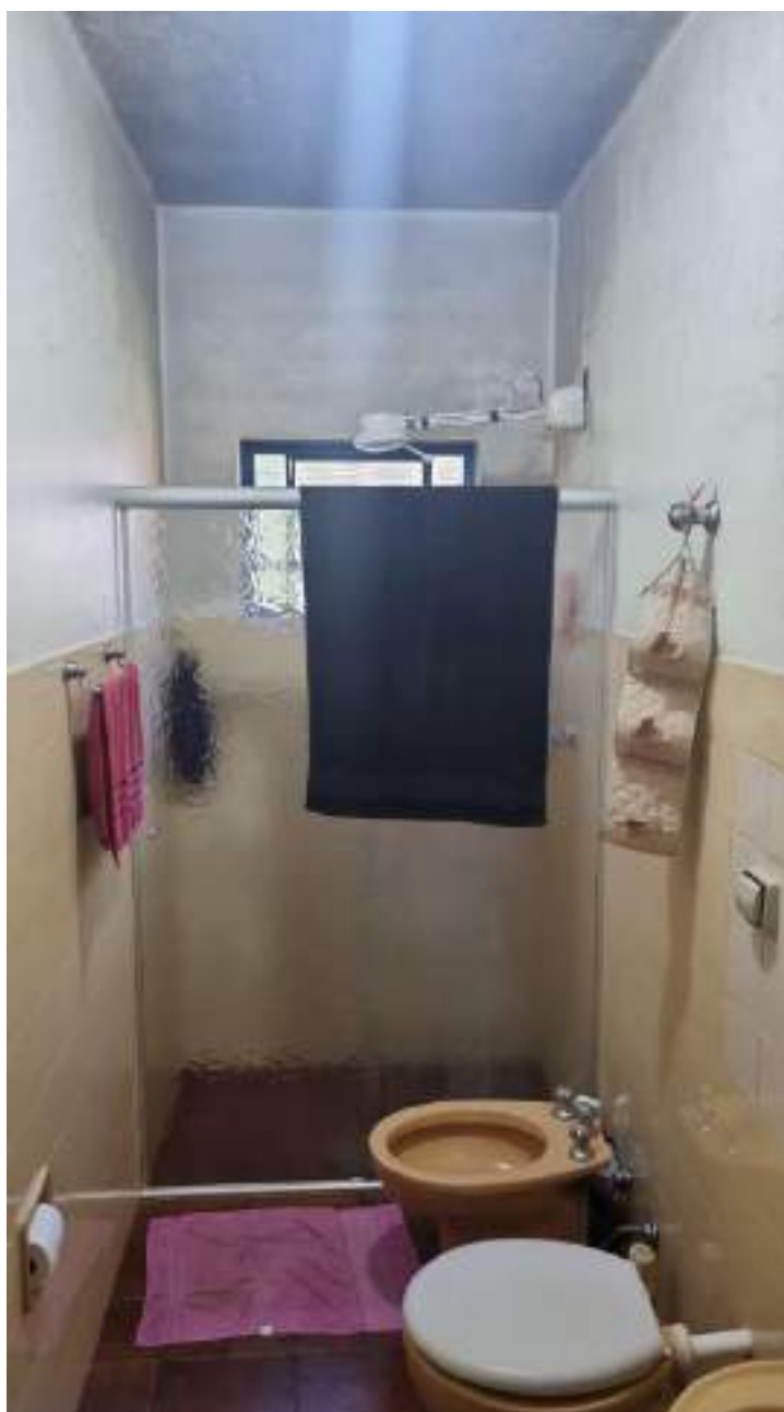
Foto 251 - Vista do banheiro geral 1 do prédio 6, casa do encarregado
