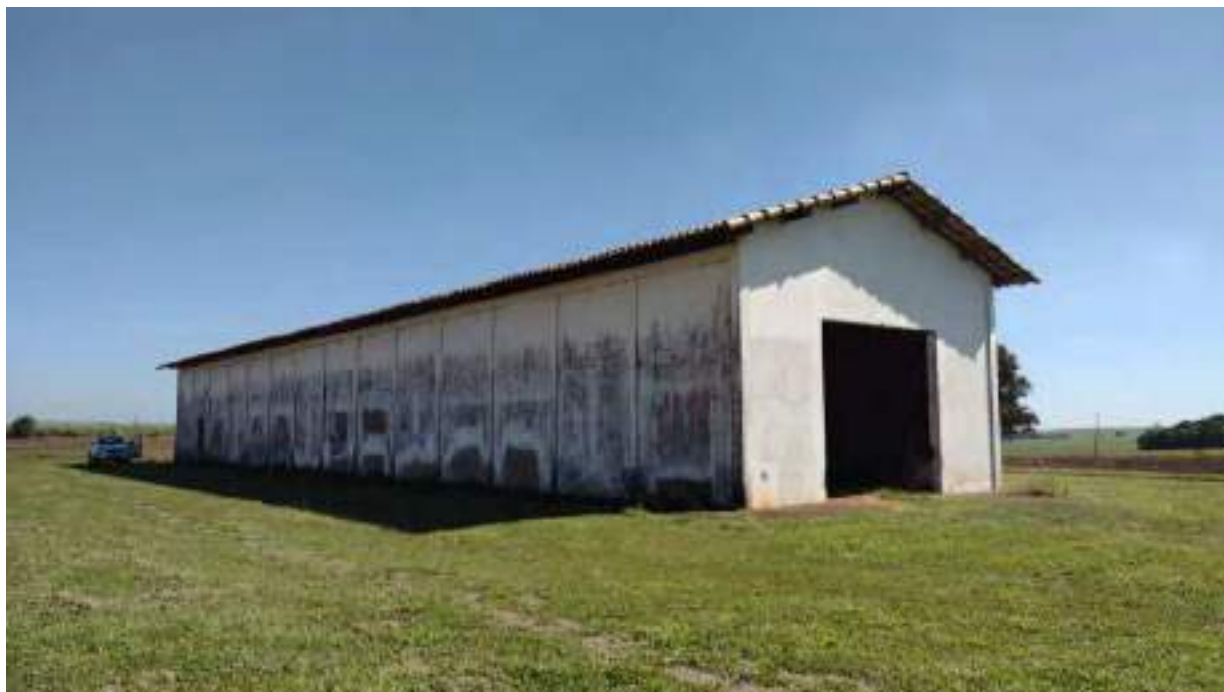
Foto 39 - Vista a fachada do galpão 1
