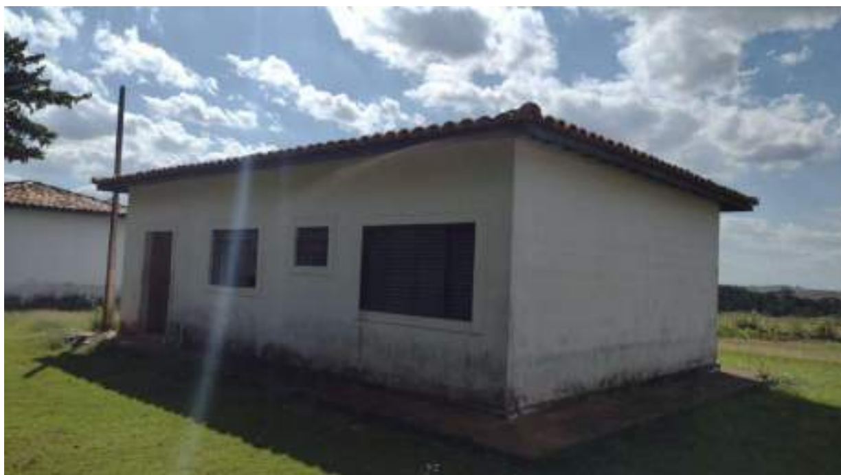
Foto 161 - Vista da fachada dos fundos da casa 5 da colônia de cima
