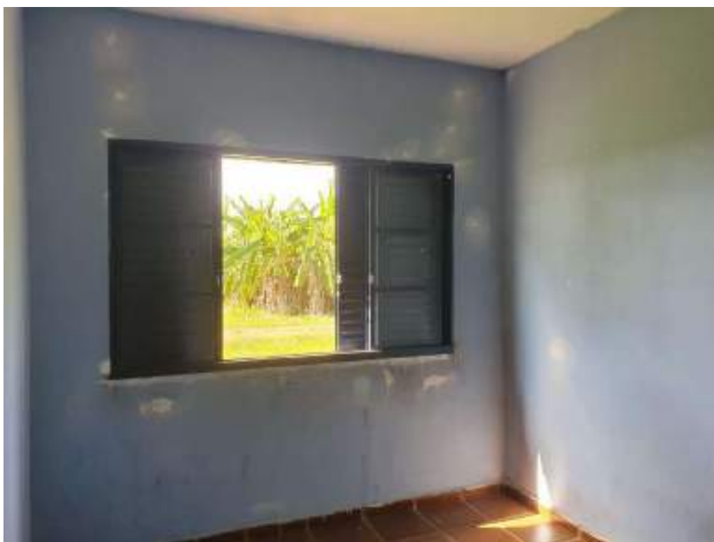
Foto 189 - Vista do dormitório 2 da casa 8 da colônia de cima
