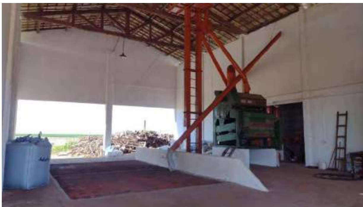
Foto 58 – Outra vista interna do galpão 4 junto ao silos
