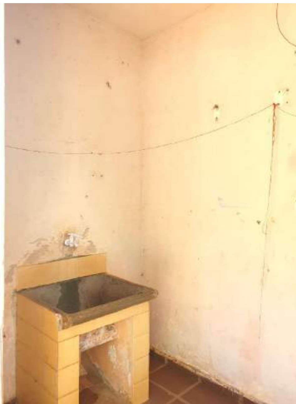
Foto 195 - Vista da área de serviço da casa 9 da colônia de cima
