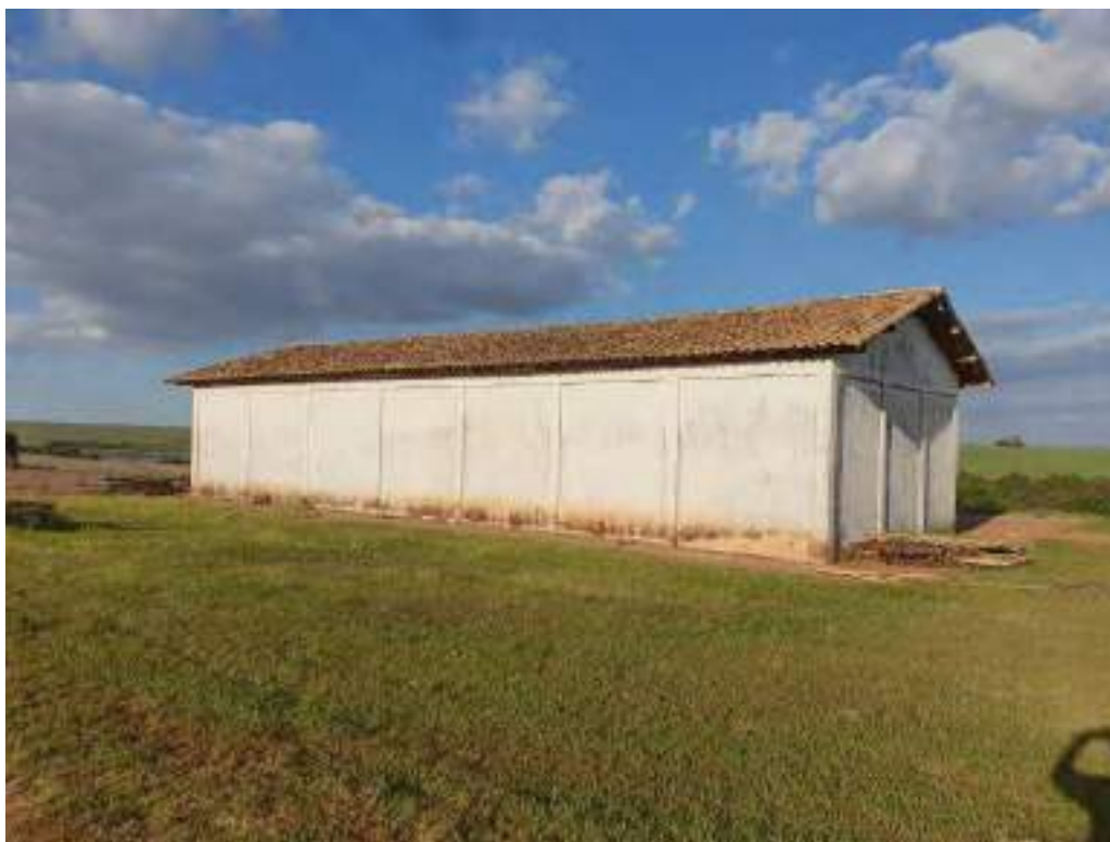
Foto 110 - Vista da fachada lateral do gapão junto a colônia de baixo
