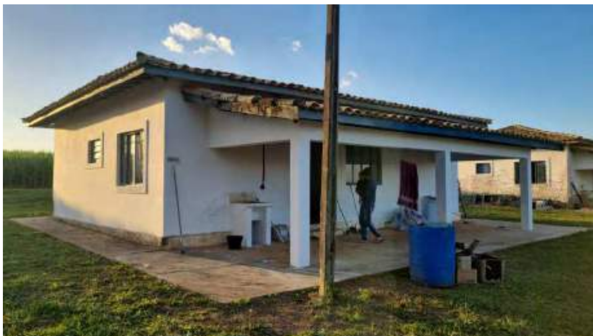
Foto 97 - Vista da fachada dos fundos da casa 7 da colônia de baixo
