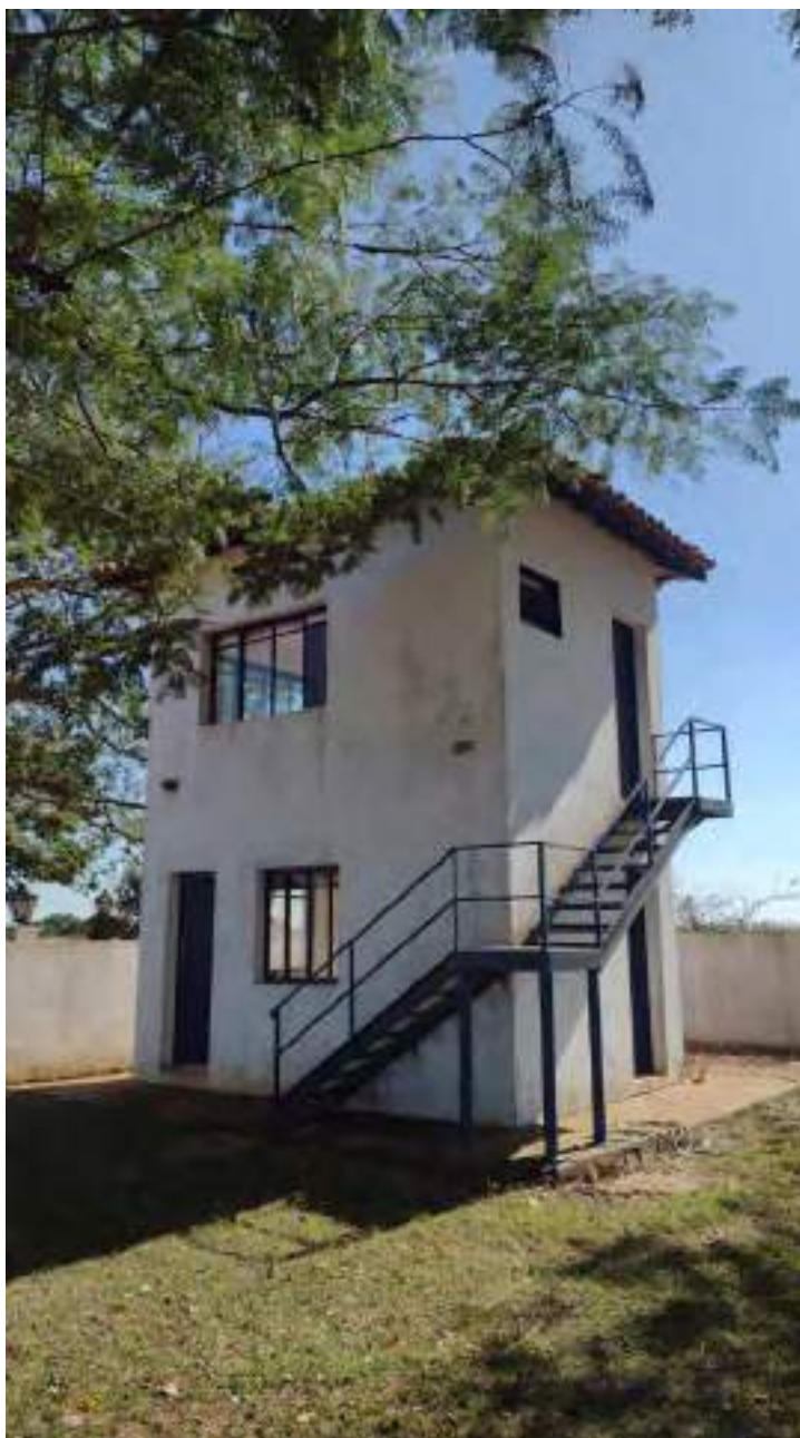
Foto 7 - Vista da portaria
