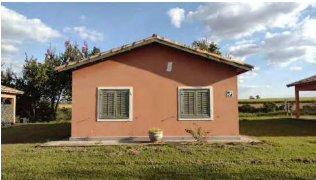
Foto 206 - Vista da fachada da casa 4 da colônia de visitas
