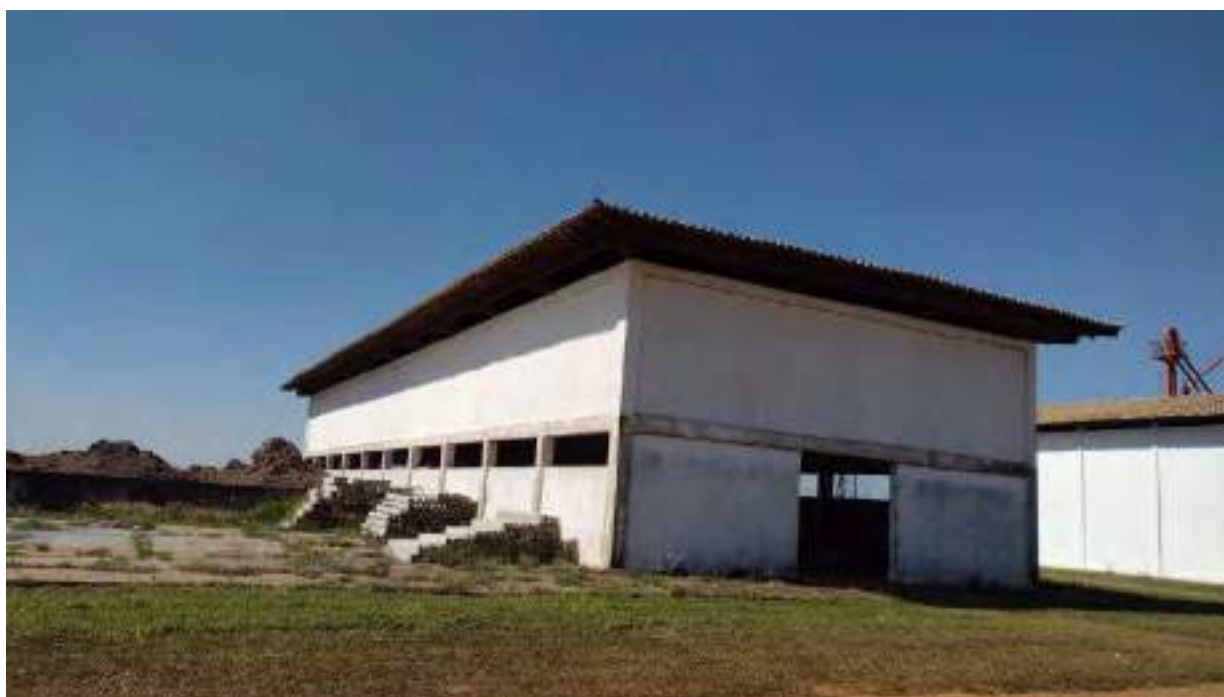
Foto 50 - Vista a fachada do galpão 3
