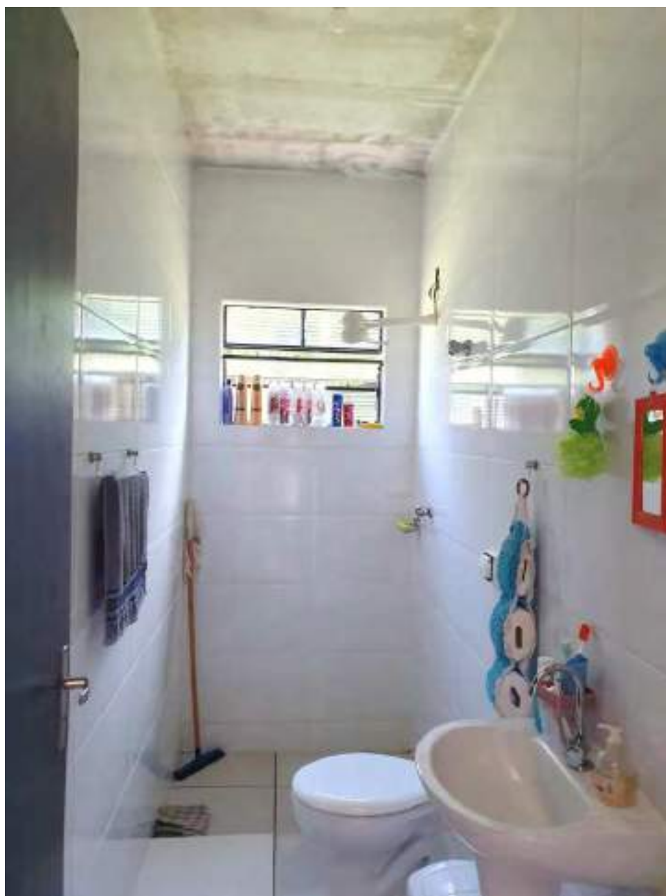
Foto 176 - Vista do banheiro da casa 7 da colônia de cima
