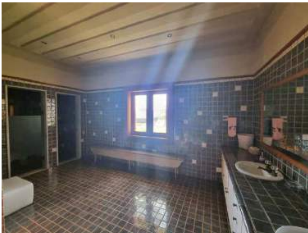
Foto 340 - Vista do vestiário feminino da área gourmet
