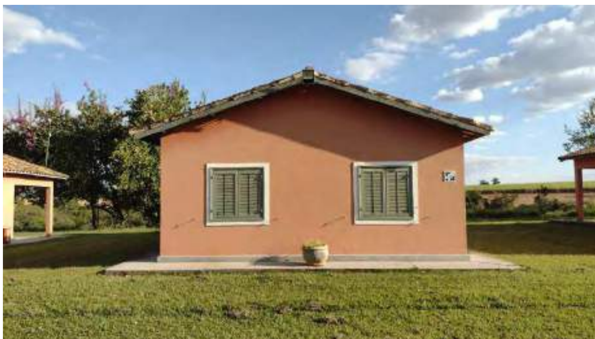
Foto 204 - Vista da fachada da casa 3 da colônia de visitas
