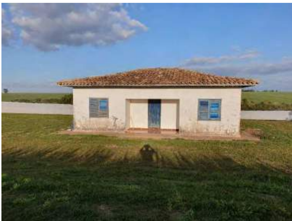
Foto 104 – Vista da fachada da casa 8 da colônia de baixo
