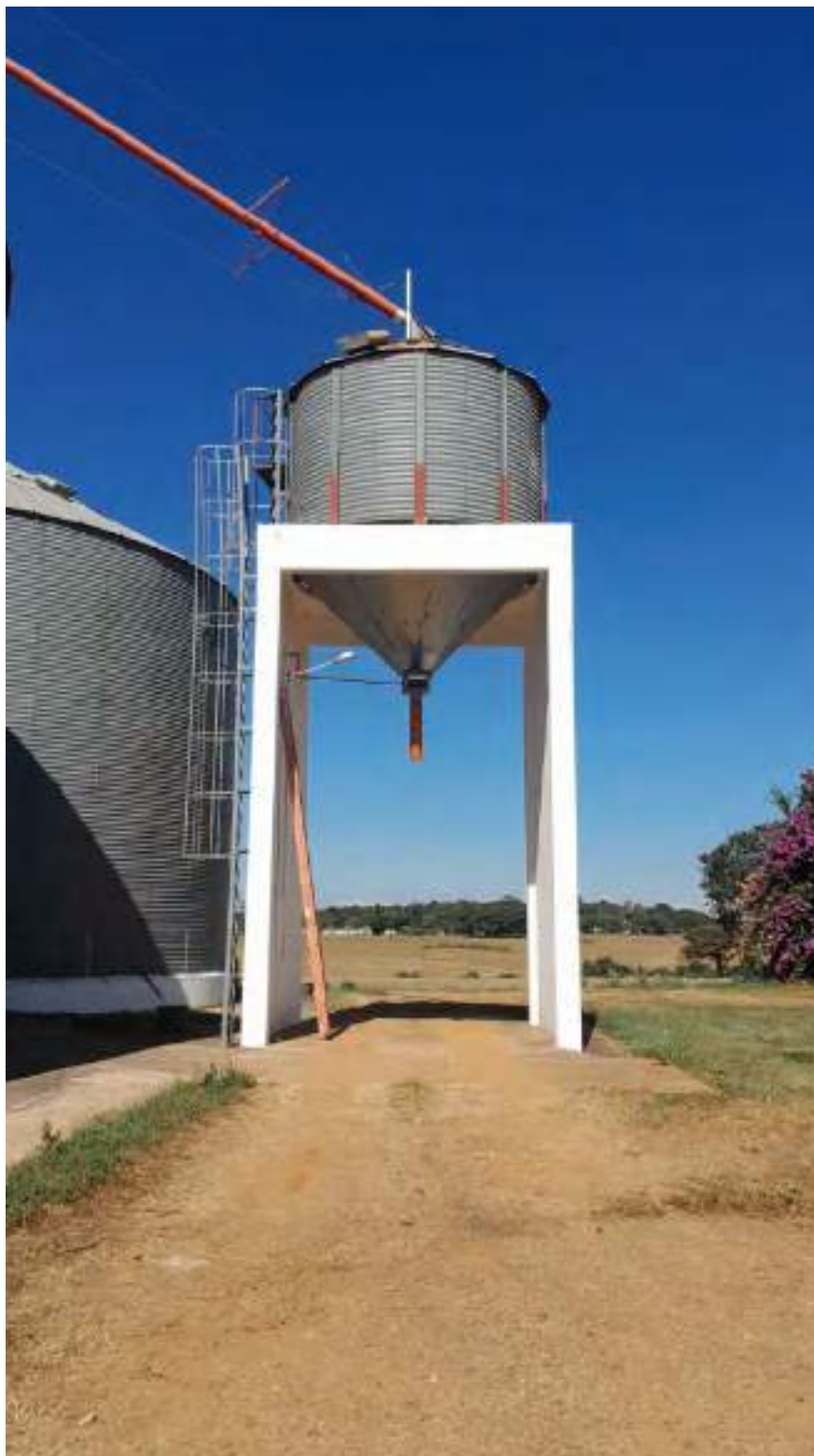
41 – Silo elevado ou Talha
