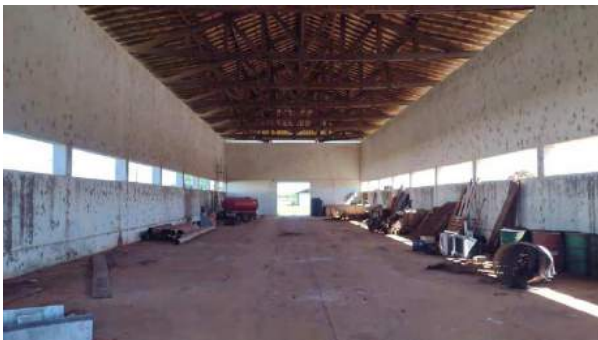
Foto 52 - Vista geral interna do galpão 3
