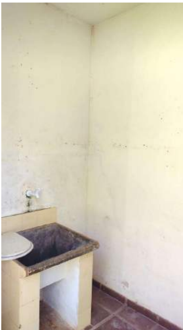
Foto 136 - Vista da área de serviço da casa 2 da colônia de cima
