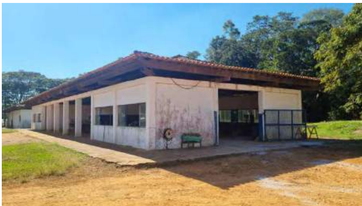
Foto 222 - Vista da fachada do prédio 1
