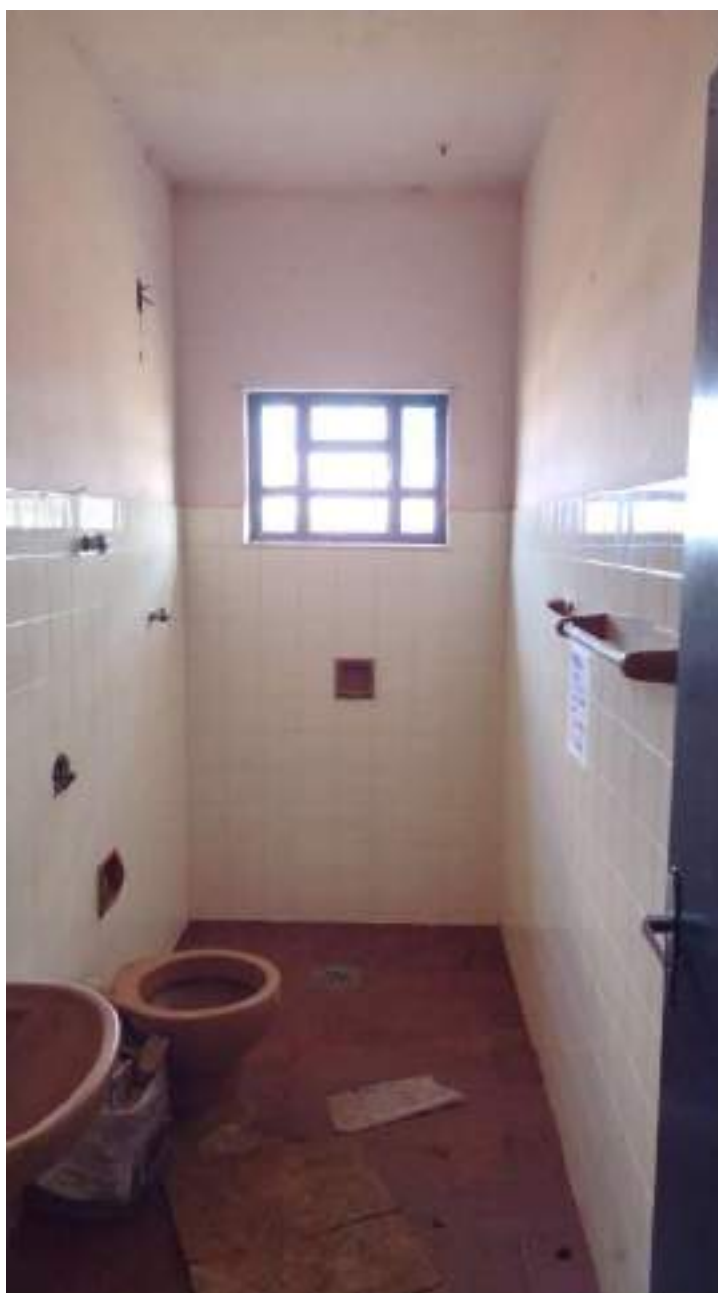
Foto 85 - Vista do banheiro da casa 1 da colônia de baixo
