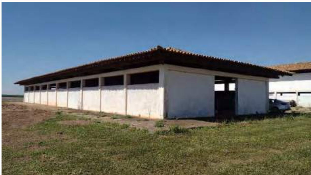
Foto 43 - Vista a fachada do galpão 2
