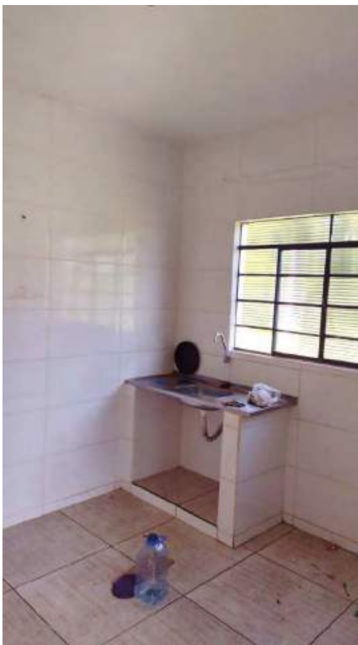
Foto 163 - Vista da cozinha da casa 5 da colônia de cima
