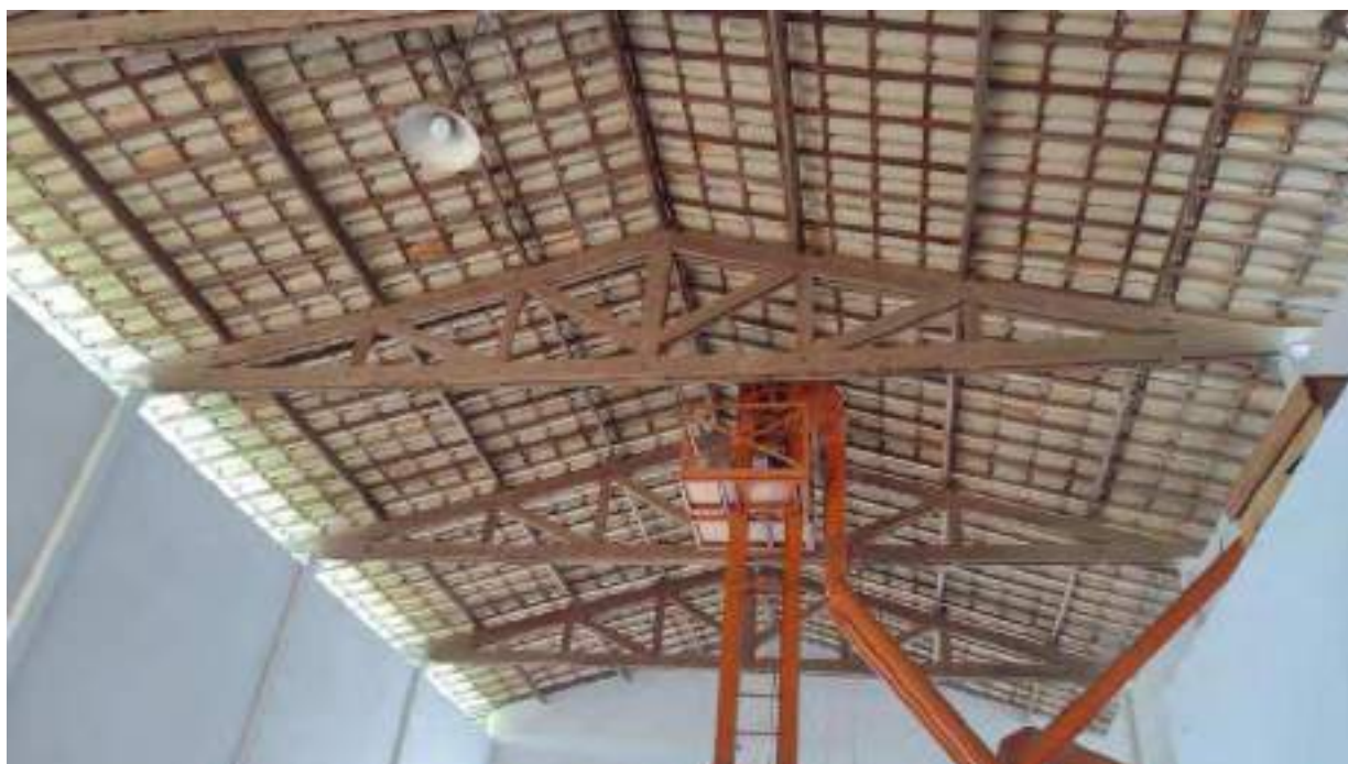
Foto 59 - Vista da cobertura do galpão 4 junto ao silos
