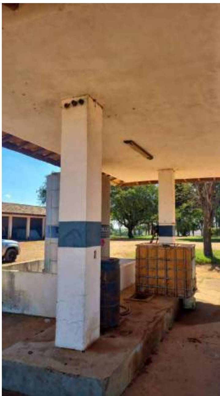
Foto 257 - Vista do posto de abastecimento
