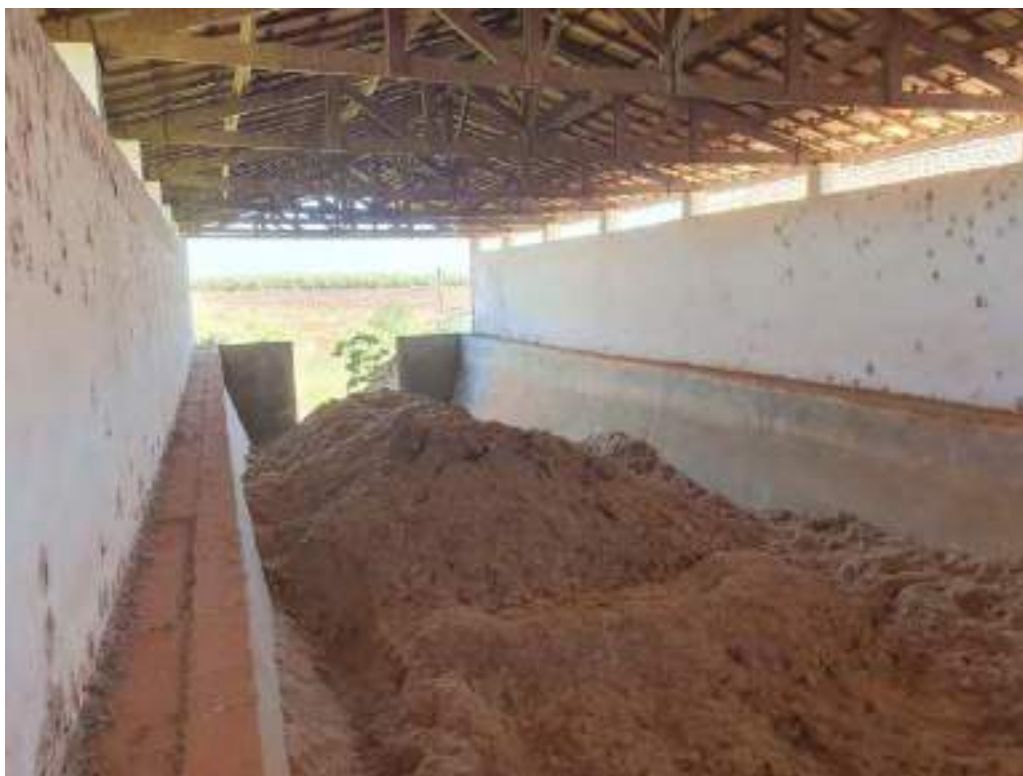
Foto 73 - Vista geral interna do galpão 2 em frente aos silos
