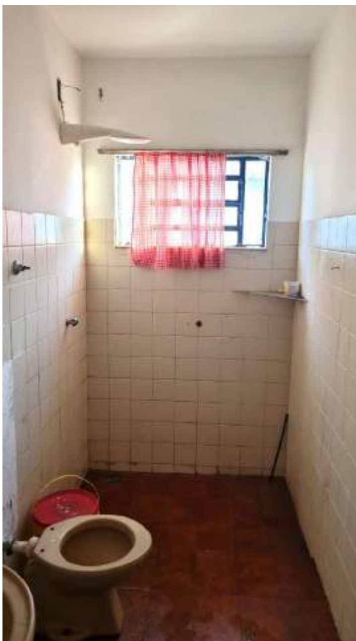
Foto 100 - Vista do banheiro da casa 7 da colônia de baixo
