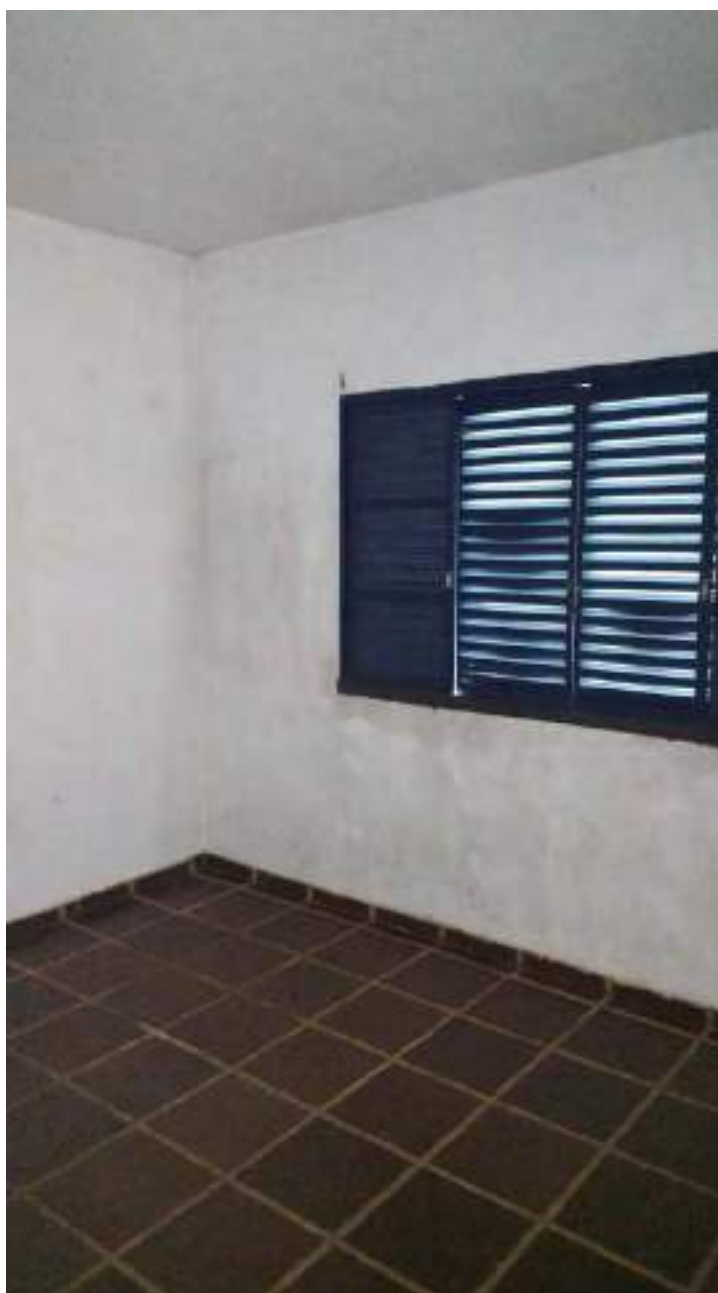
Foto 157 - Vista do dormitório 1 da casa 4 da colônia de cima
