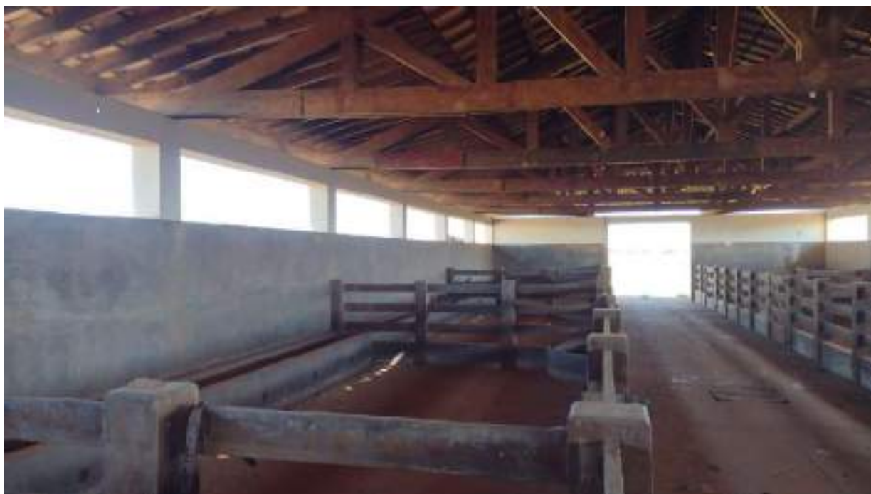
Foto 47 - Vista geral interna do galpão 2
