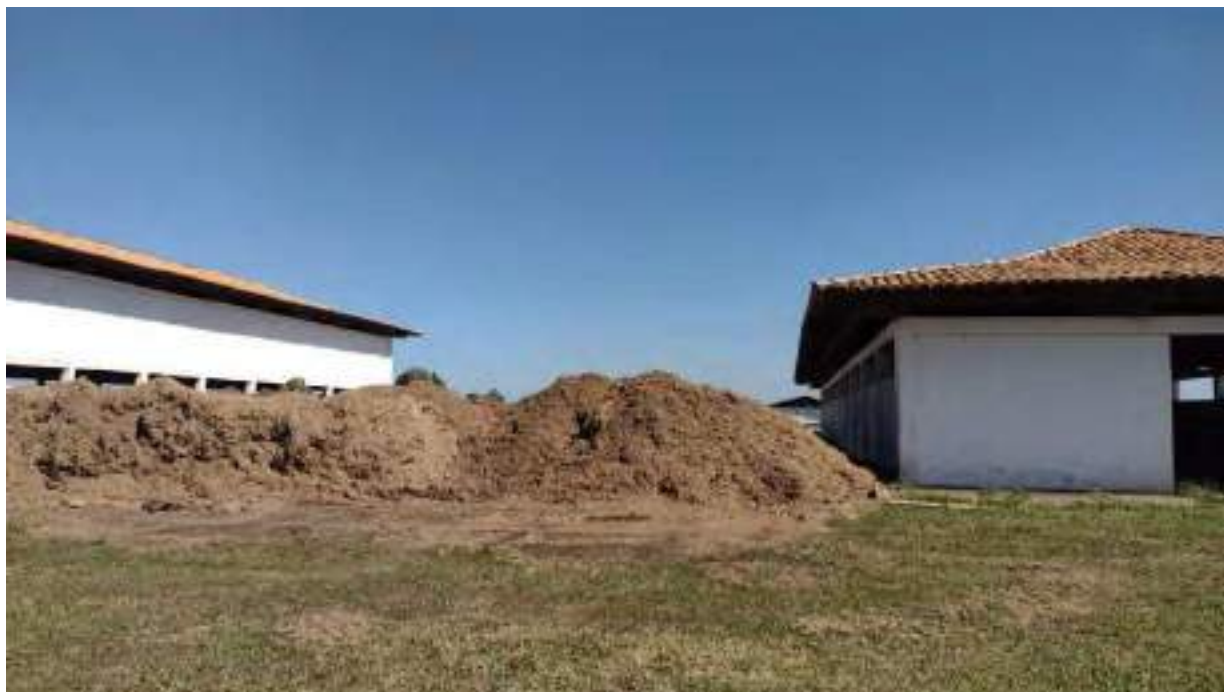
Foto 45 - Vista da área entre o galpão 2 e galpão 3
