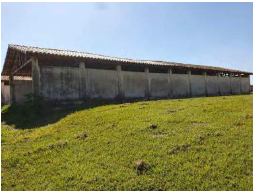
Foto 72 – Vista da fachada lateral do galpão 3 em frente aos silos
