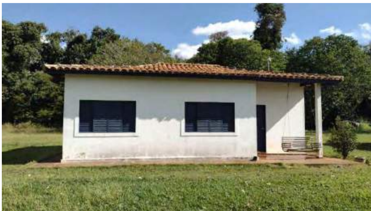
Foto 172 - Vista da fachada da casa 7 da colônia de cima
