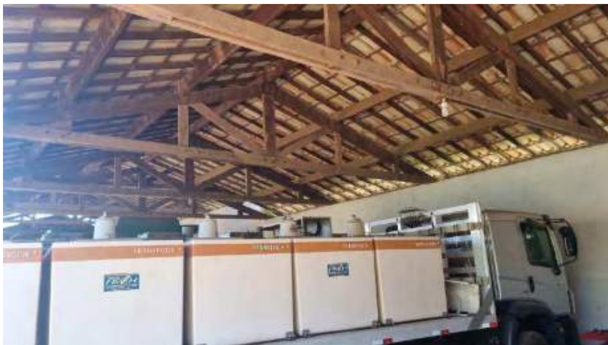
Foto 234 – Outra vista interna do prédio 4
