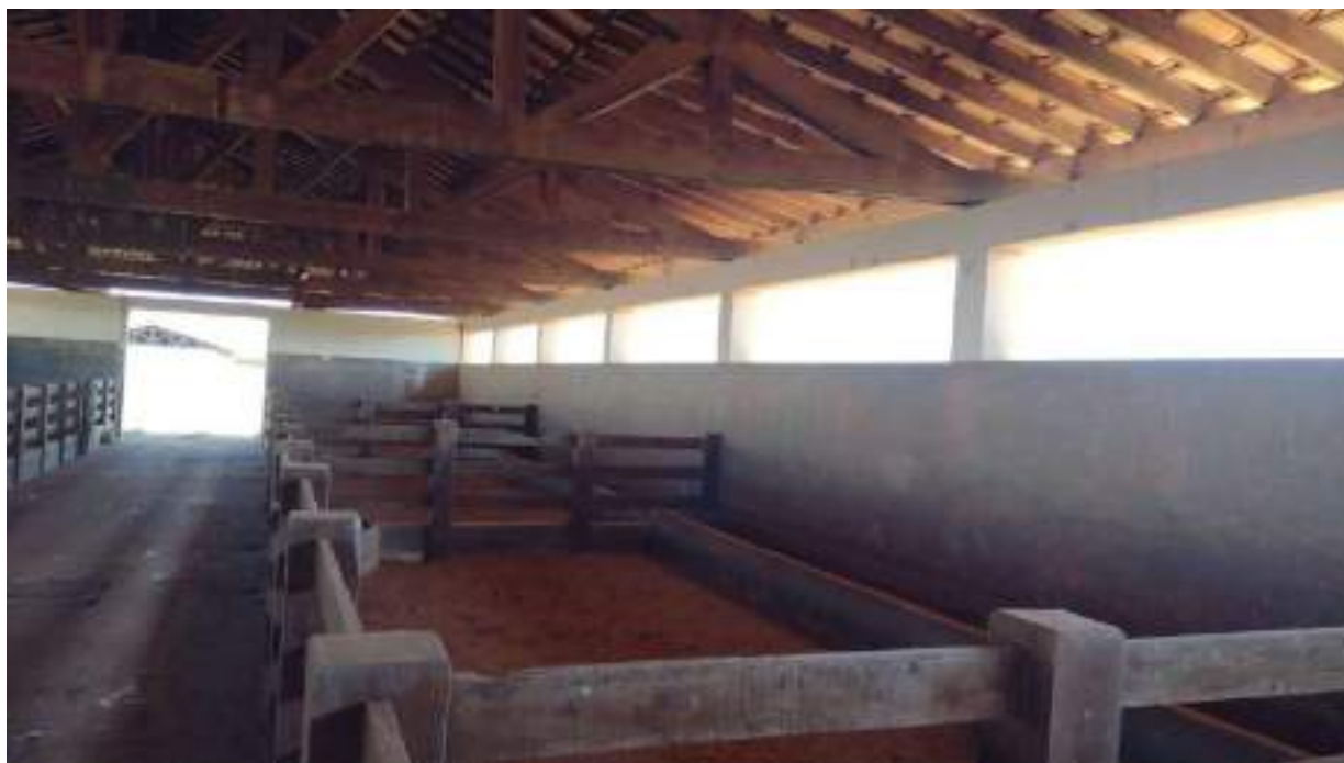
Foto 48 - Vista geral interna do galpão 2
