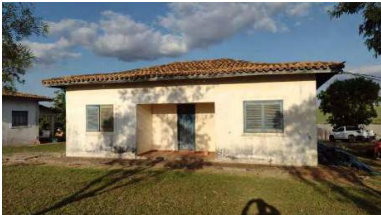
Foto 78 - Vista da fachada da casa 1 da colônia de baixo
