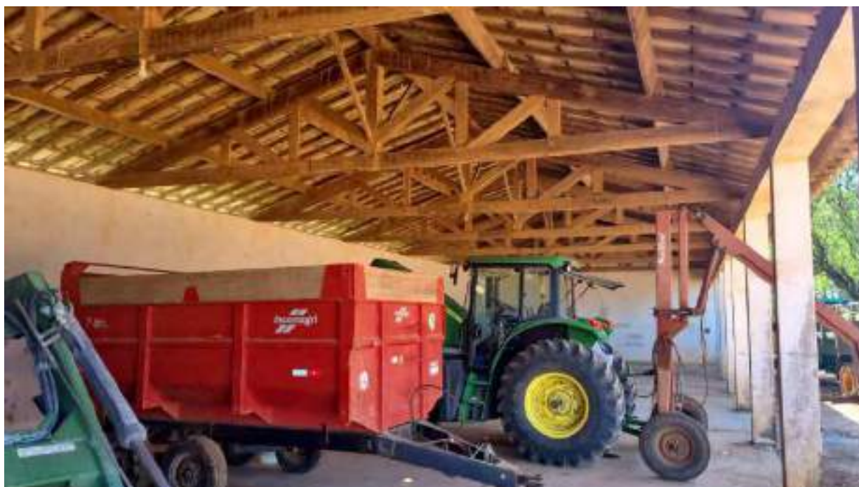
Foto 230 - Vista interna do prédio 3
