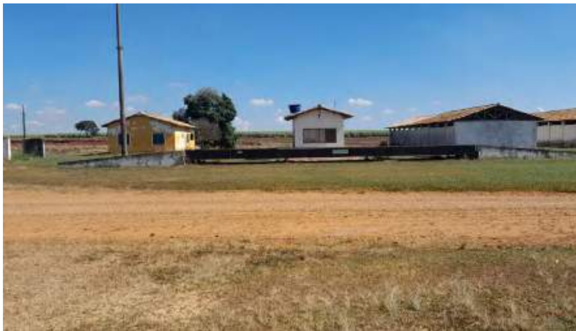
42 – Vista Geral – Cabine e Balança Rodoviária
