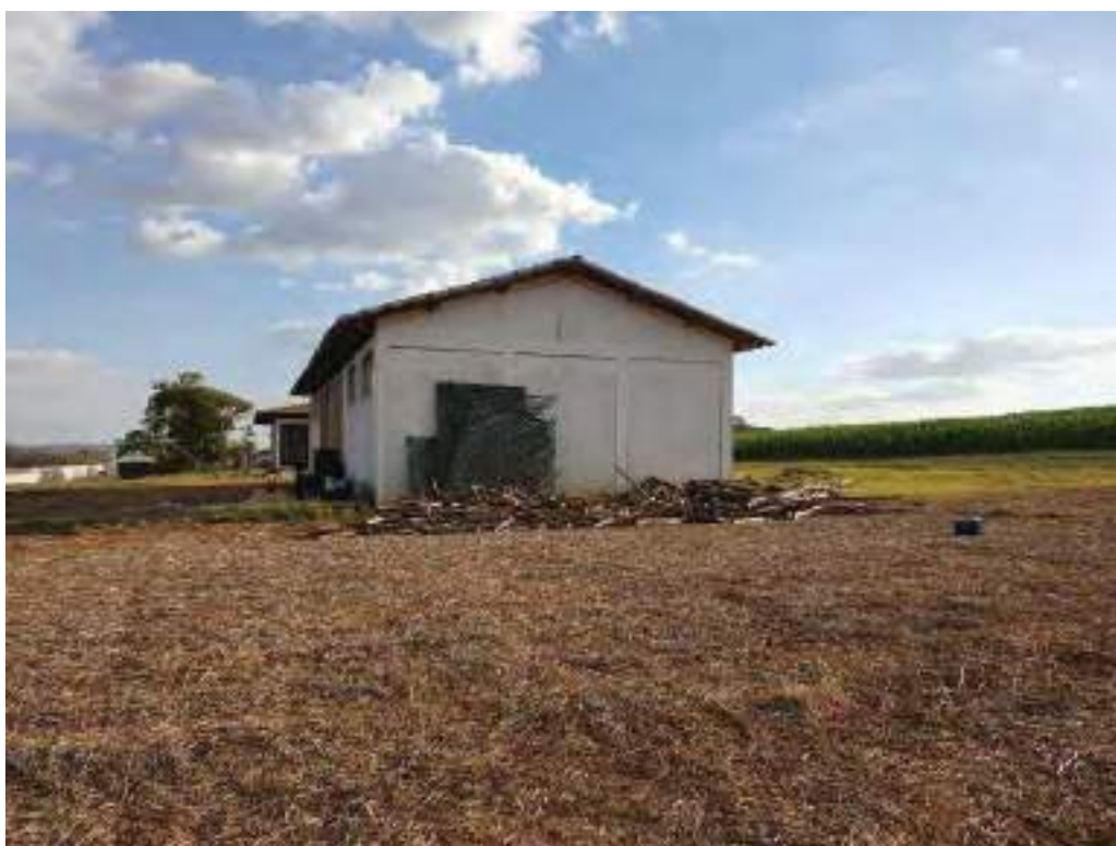
Foto 109 – Outra vista da fachada do gapão junto a colônia de baixo
