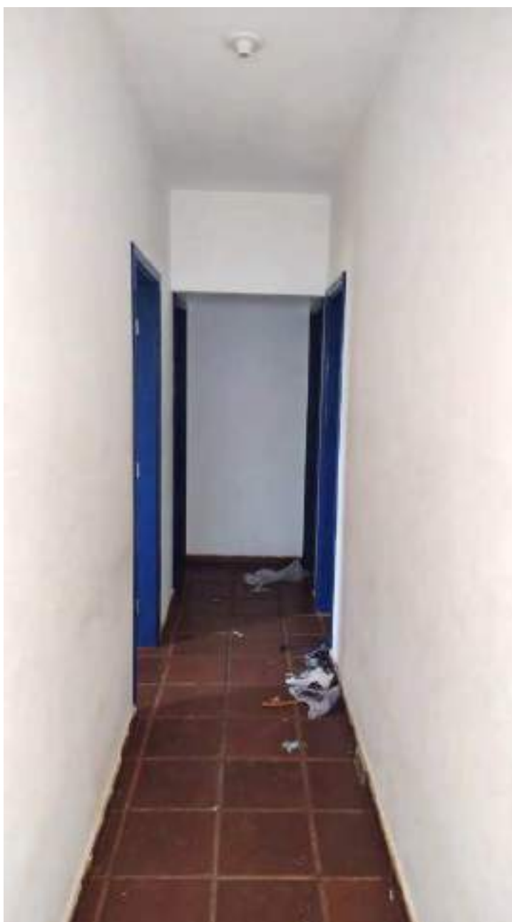
Foto 166 - Vista do corredor de distribuição dos dormitórios da casa 5 da colônia de cima
