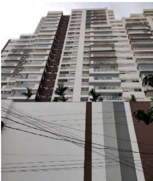
FOTO Nº 02 Vista parcial Fachada do Imóvel
