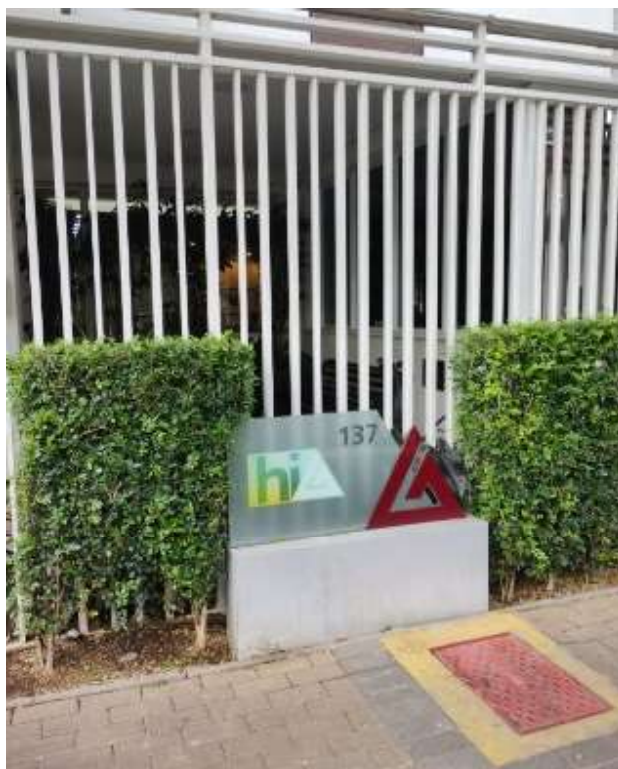
FOTO Nº 01 Vista parcial Fachada do Imóvel
