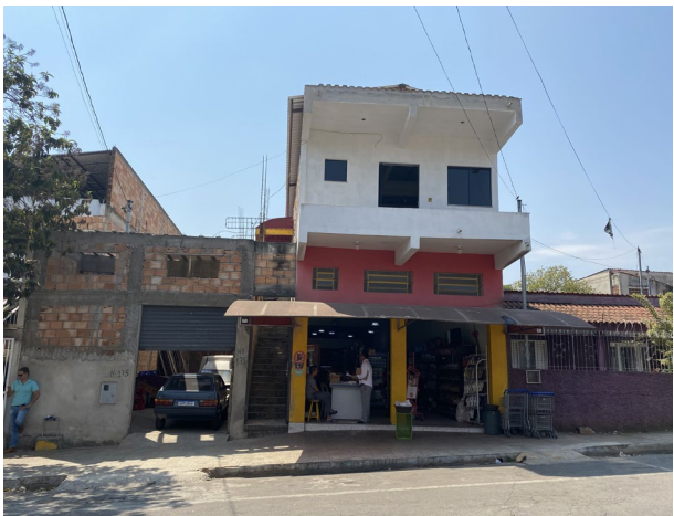
Foto 1 – VISTA FRONTAL E AO LADO O GALPÃO
