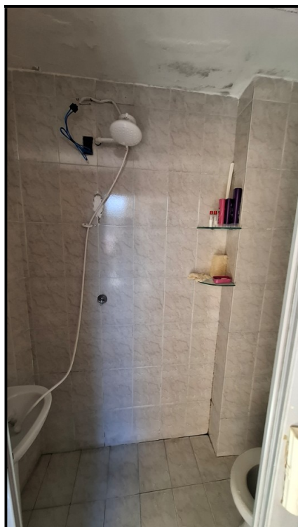
Foto 25: 2º Subsolo – Banheiro
