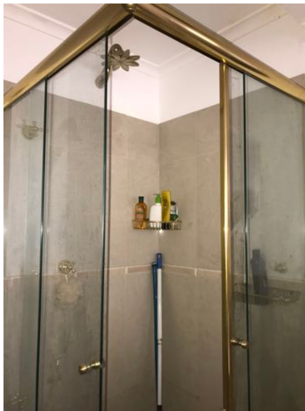
Foto 22: box e chuveiro do banheiro que atende ao terceiro quarto.
