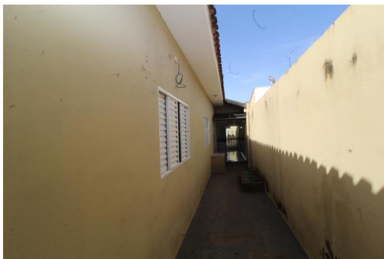
21- Corredor / area de circulação
