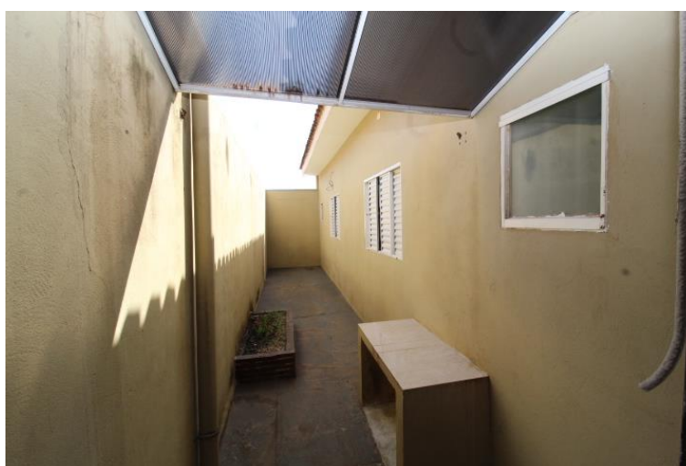
20- Corredor / area de circulação
