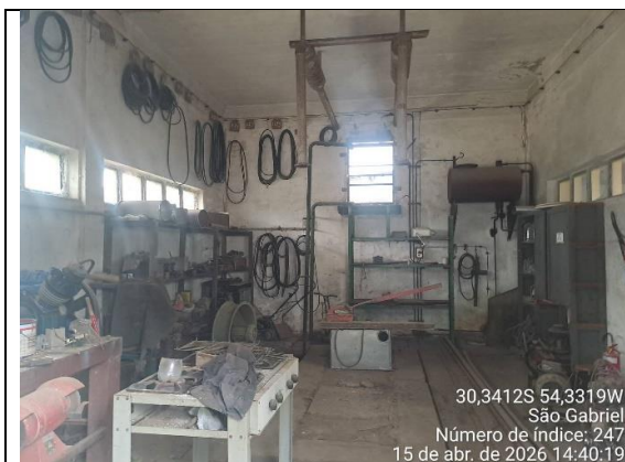
Foto 7 – Vista interna do antigo Gerador
