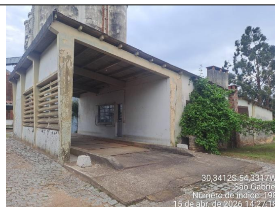
Foto 4 – Estação de Pesagem Rodoviária
