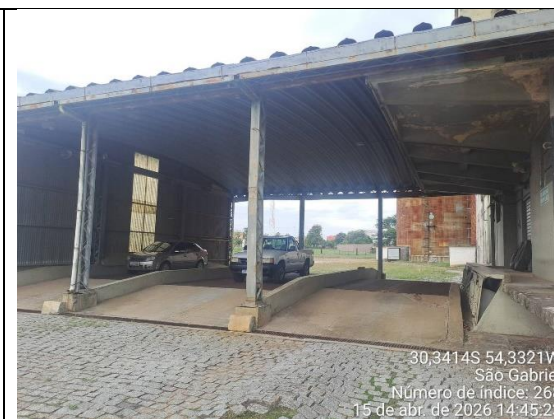
Foto 12 – Moegas Rodoviárias (I, II e III)
