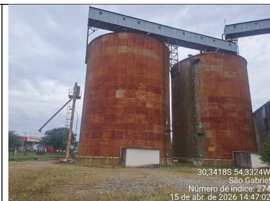
Foto 15 – Silos Metálicos e Passarela
