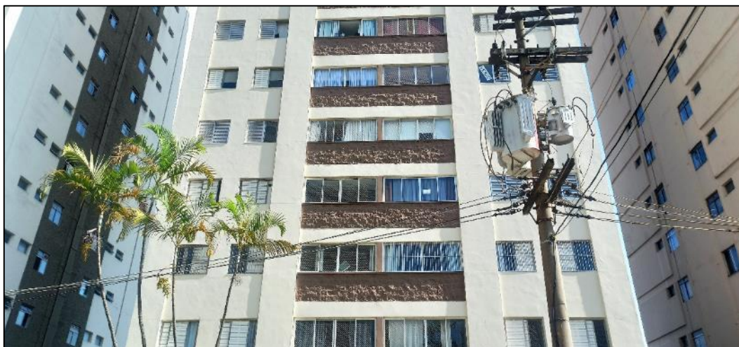
Foto 1. Fachada do condomínio
