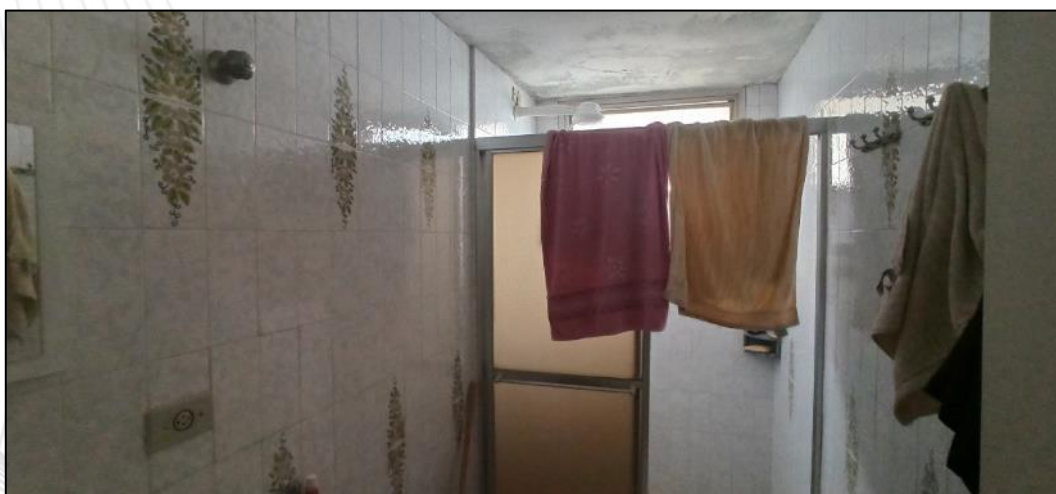
Foto 24. Detalhes banheiro social
