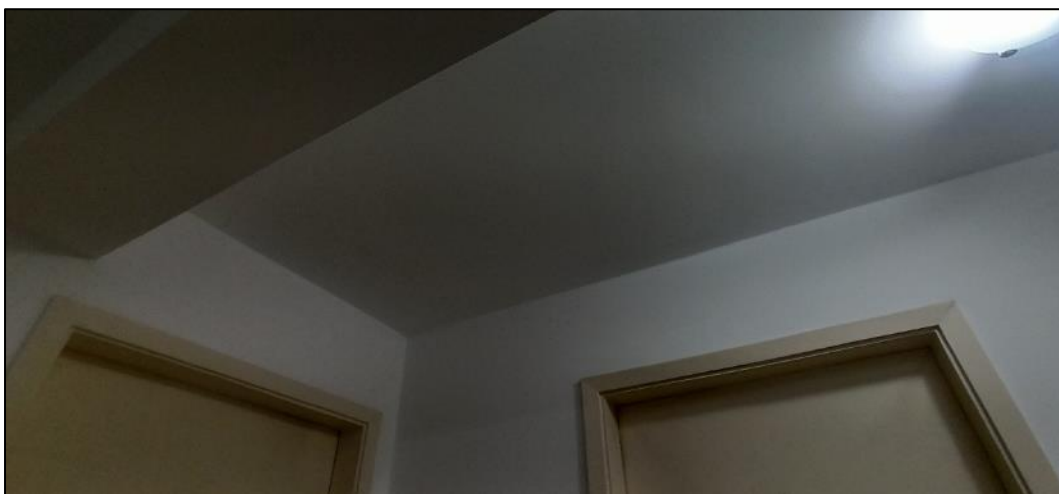
Foto 13. Teto hall de entrada do apartamento
