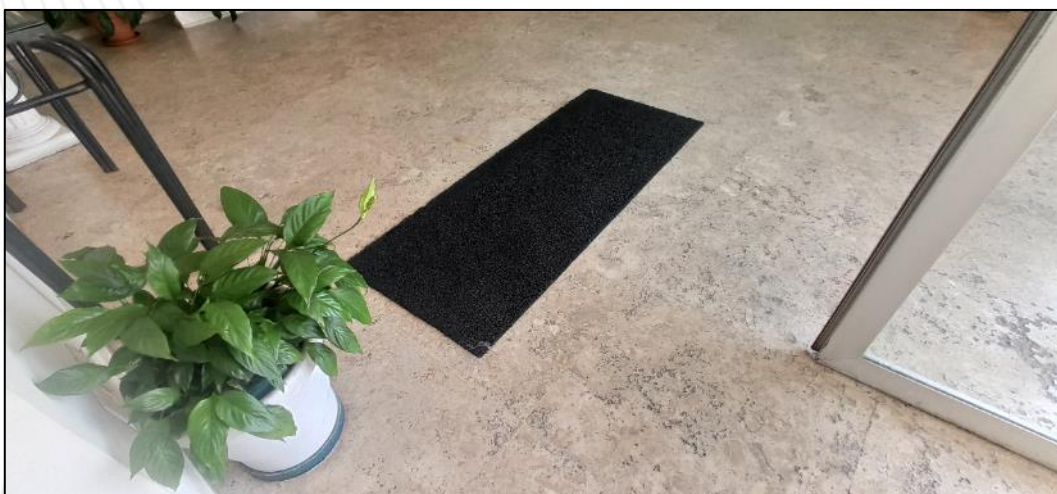
Foto 6. Piso do hall de entrada
