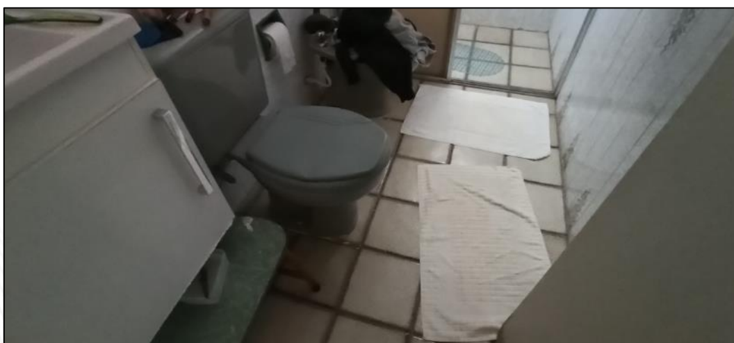
Foto 23. Piso do banheiro social
