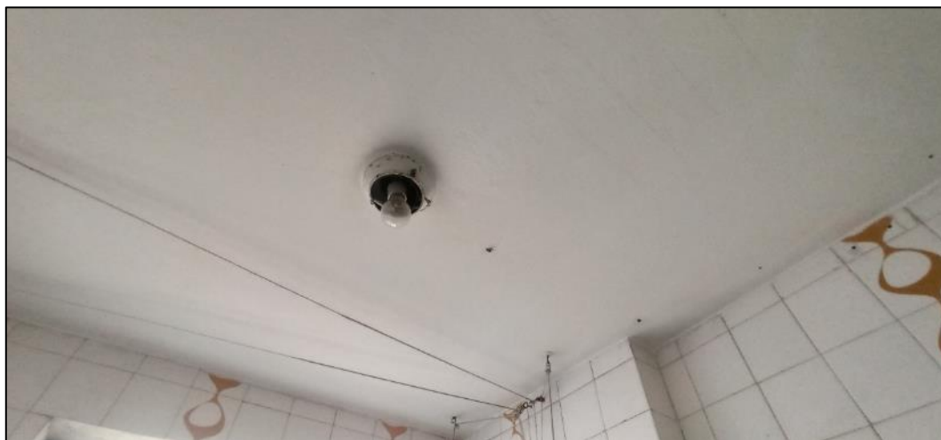
Foto 34. Teto área de serviço
