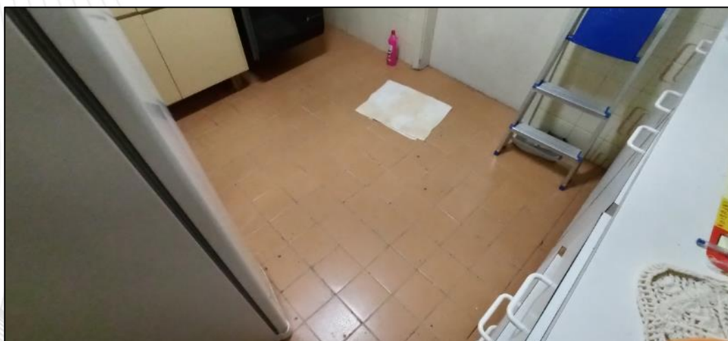
Foto 39. Piso da cozinha
