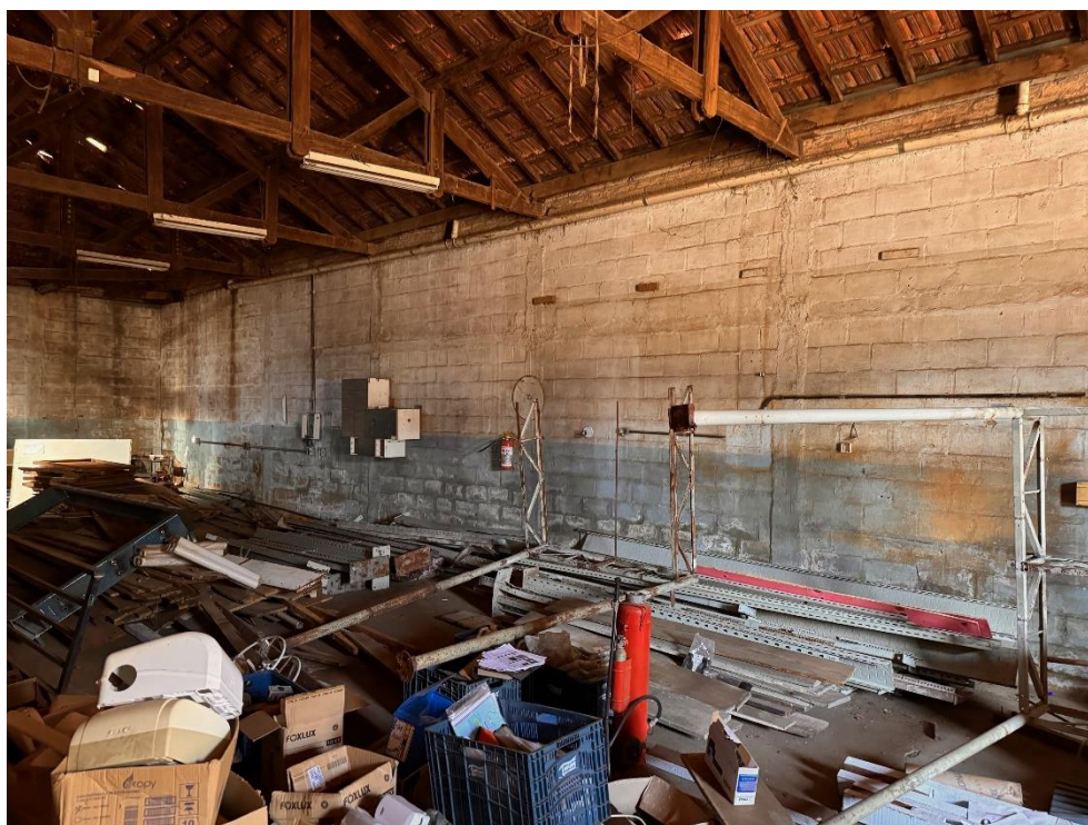
Foto 03 Detalhes das paredes. Blocos de concreto
