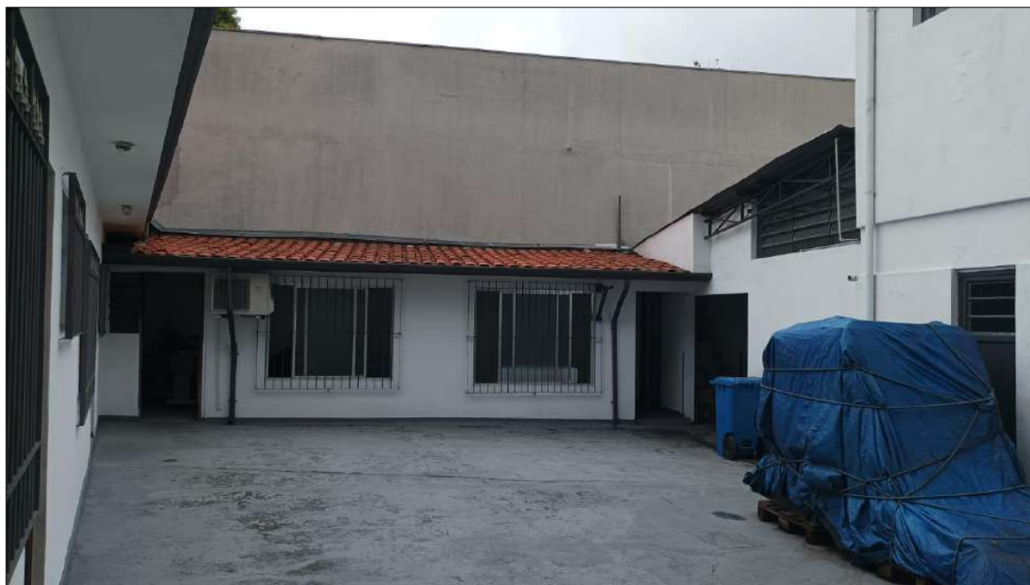
Foto 13 – Fachada lateral residência.
