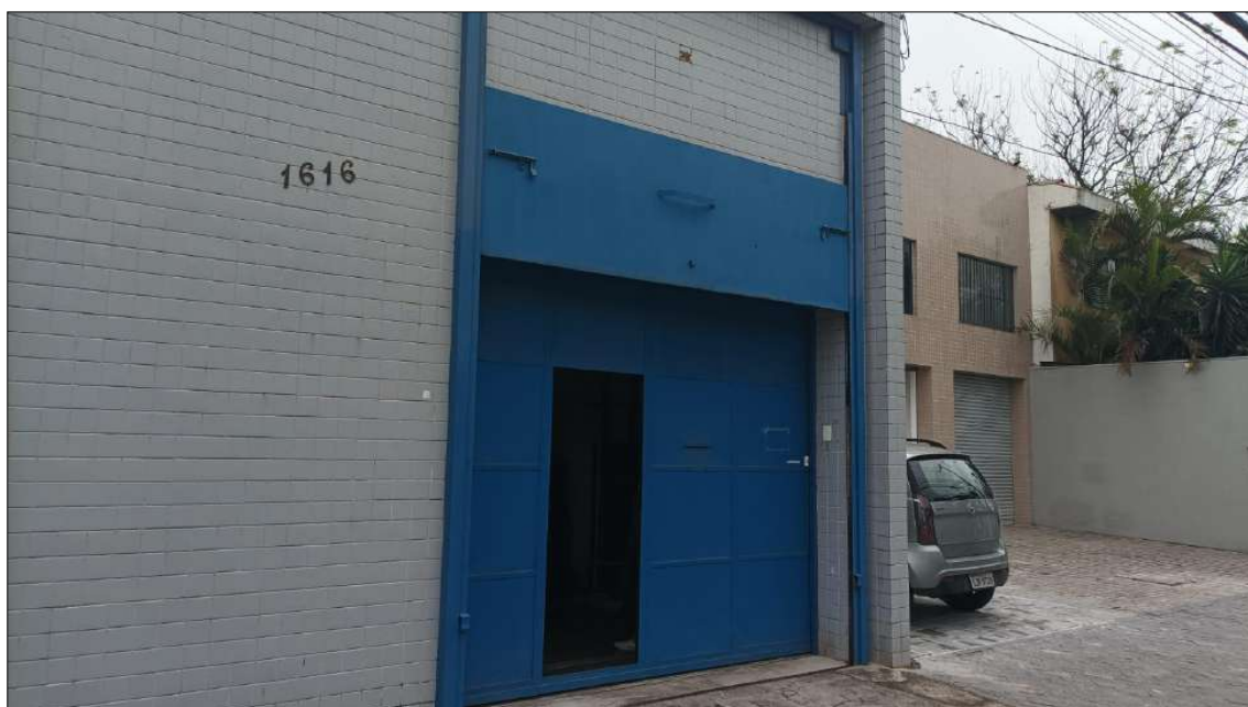
Foto 2 – Portão de entrada ao imóvel.
