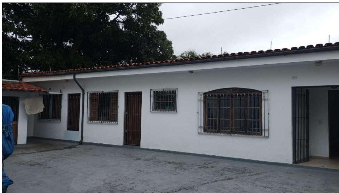
Foto 12 – Fachada principal residência.
