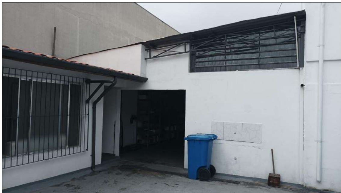
Foto 11 – Saída do galpão/depósito com acesso a área livre/descoberta para a residência, aos fundos do terreno.
