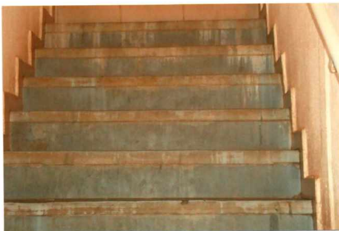
Vista da entrada do bloco n.º 20 e escada de acesso ao 3.º pavimento.
