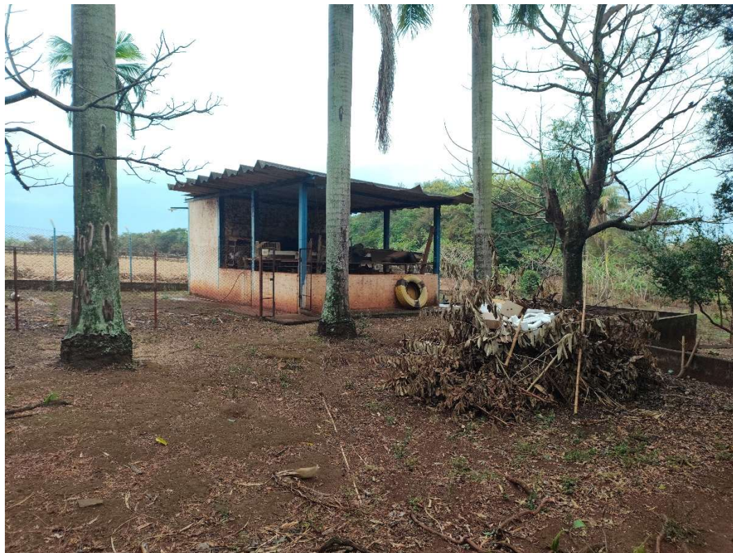
Foto 21 - Pequena construção sem valor
