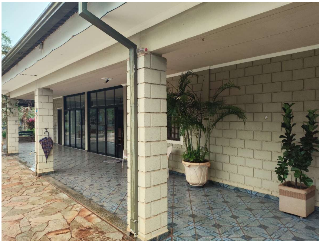
Foto 9 - Vista externa do imóvel.
