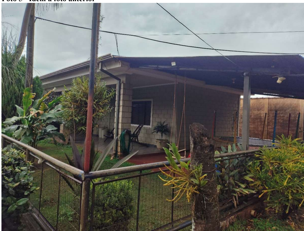
Foto 6 - Vista externa do imóvel
