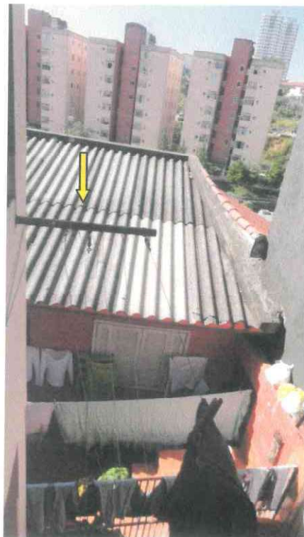
Vista da cobertura da Edificação “B”.
