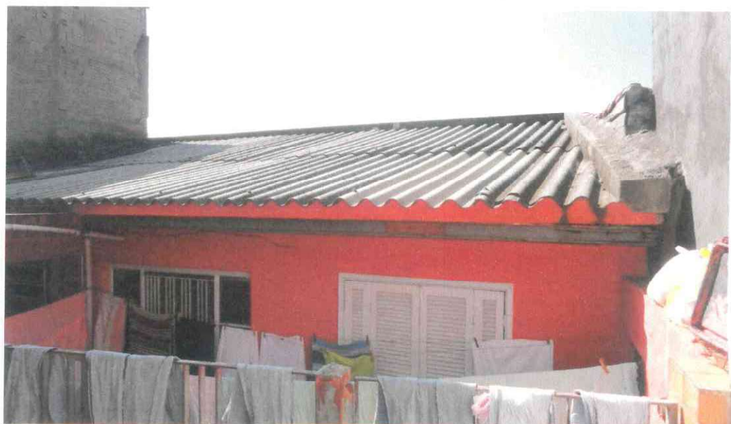
Fachada da frente da edificação.
