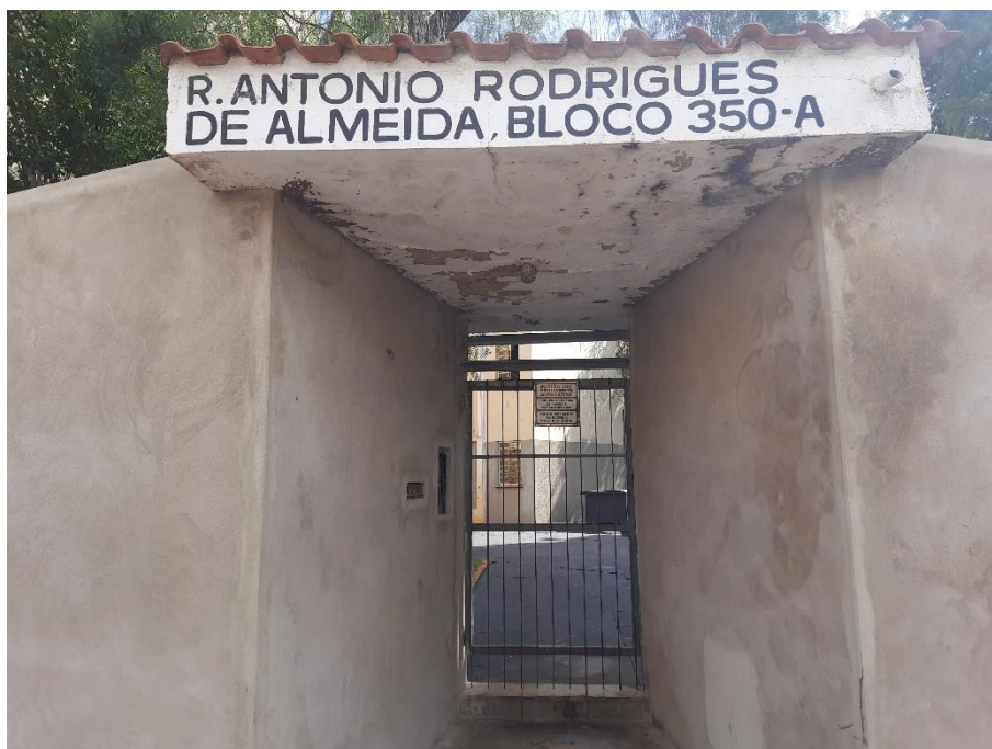
Foto 1 - Fachada do Imóvel
