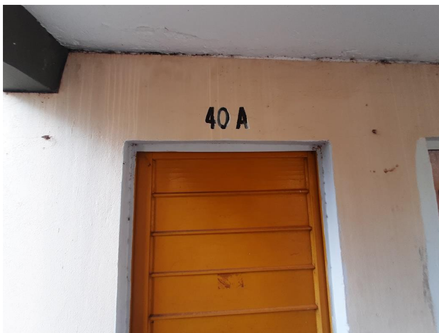
Foto 2 - Entrada do Imóvel
