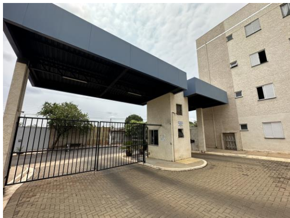
Imagem 01 – Fachada externa do condomínio
