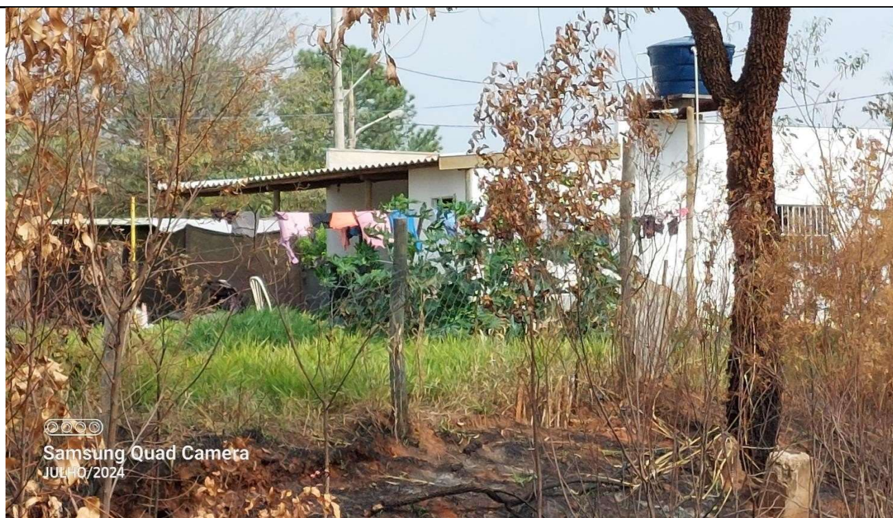
Foto 6: Detalhe da edificação ocupada
