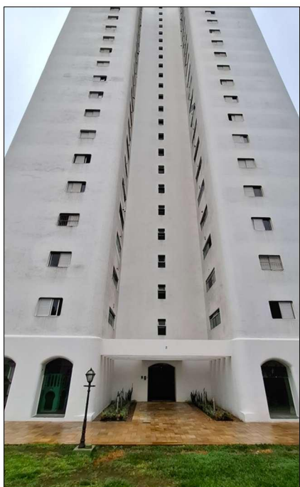
Foto 17: Bloco 3 – área externa
