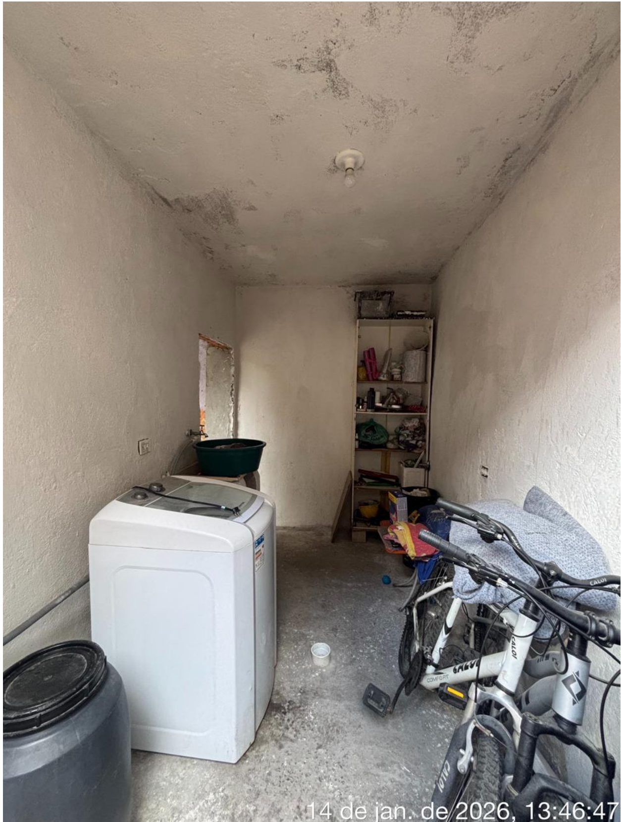
Foto 08: Área de serviço
