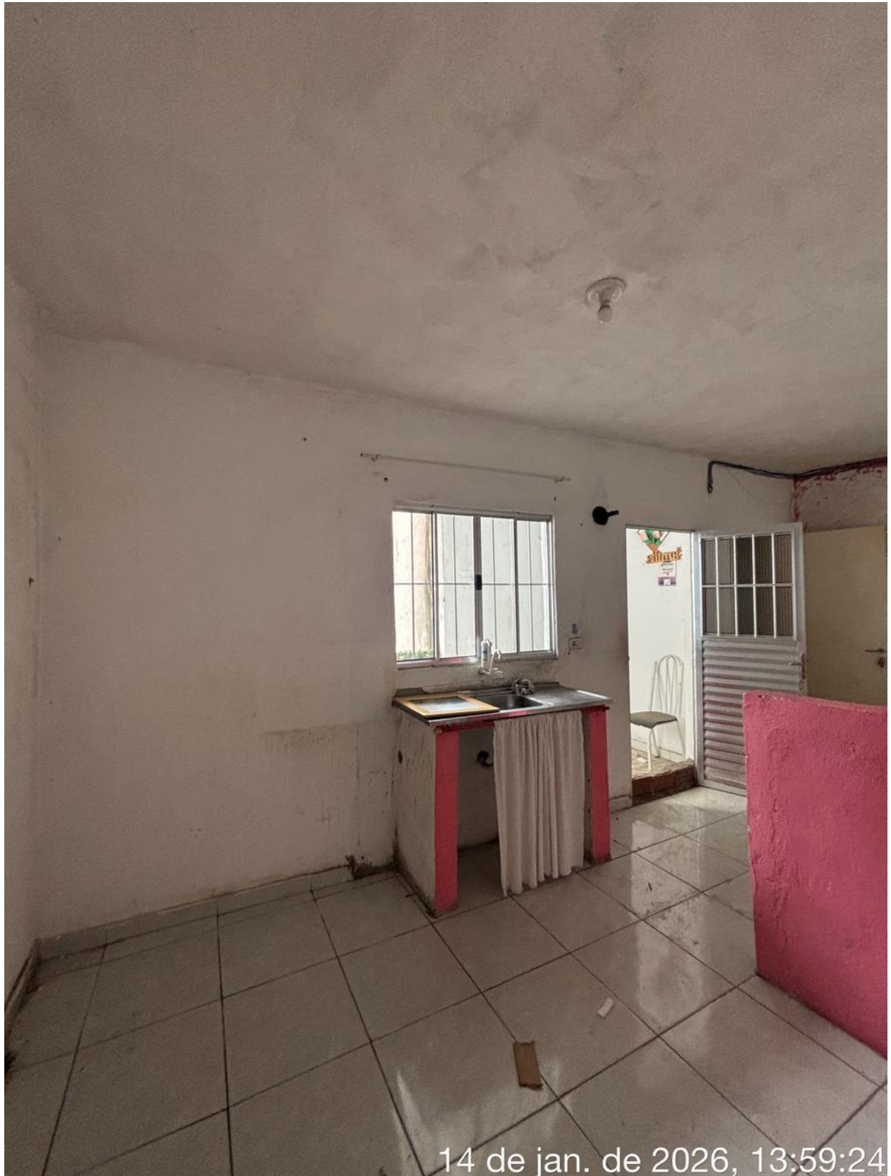
Foto 20: Sala de estar / Cozinha
