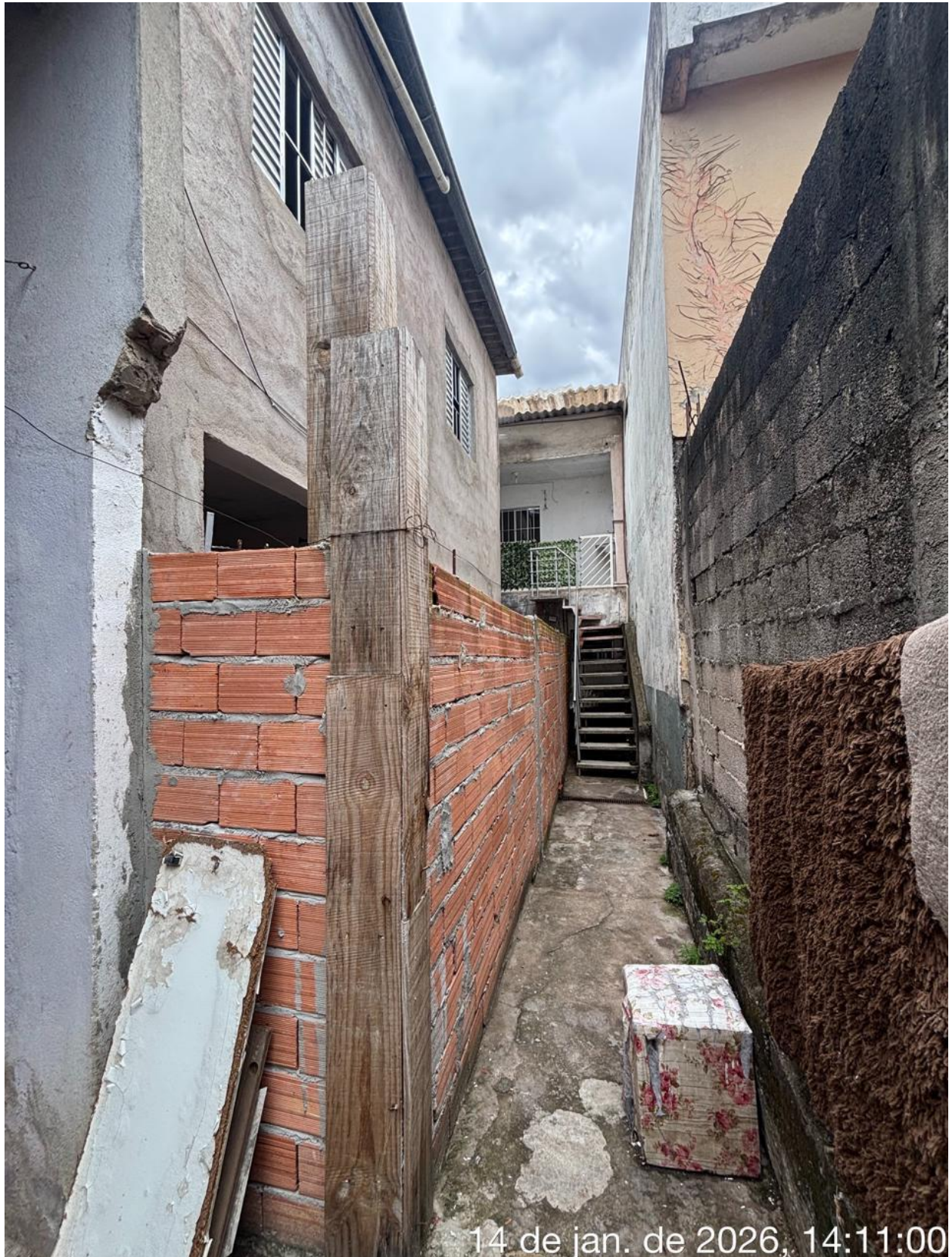
Foto 16: Corredor externo acesso ao pavimento superior
