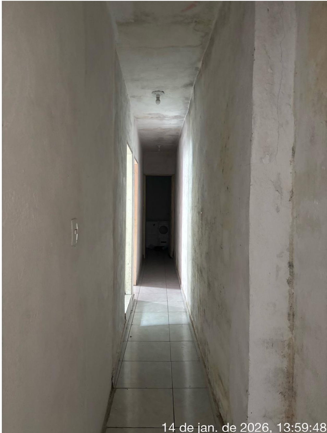
Foto 21: Corredor de circulação
