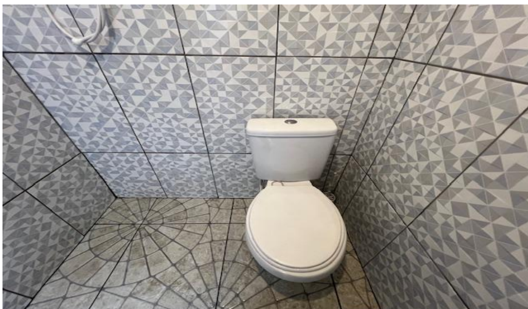
Foto 10 – Banheiro (casa térrea)
