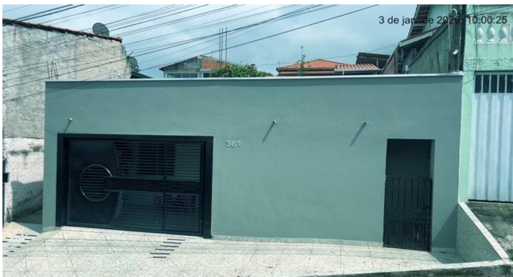
Foto 1 – Vista fachada da casa térrea – Rua Jamaica
