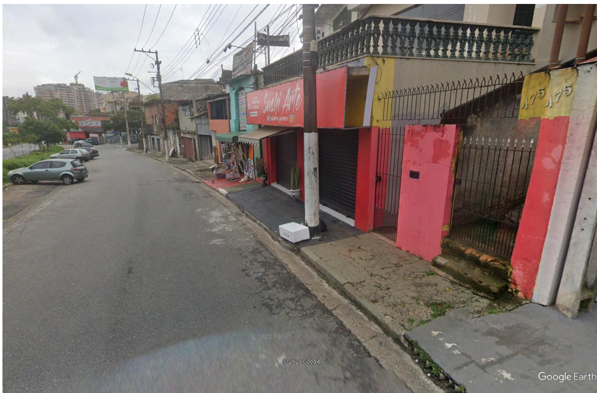
Foto 07 – Vista frontal da fachada
